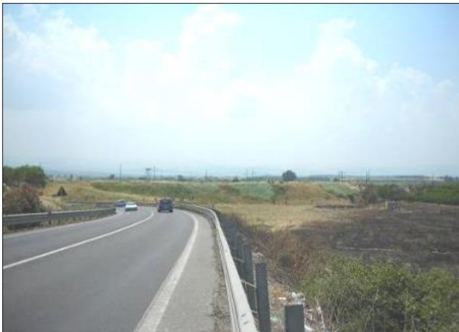
Foto 7.18 – Versante meridionale del rilievo terrazzato di Panne – Tenutella degradante in direzione della ferrovia esistente.
