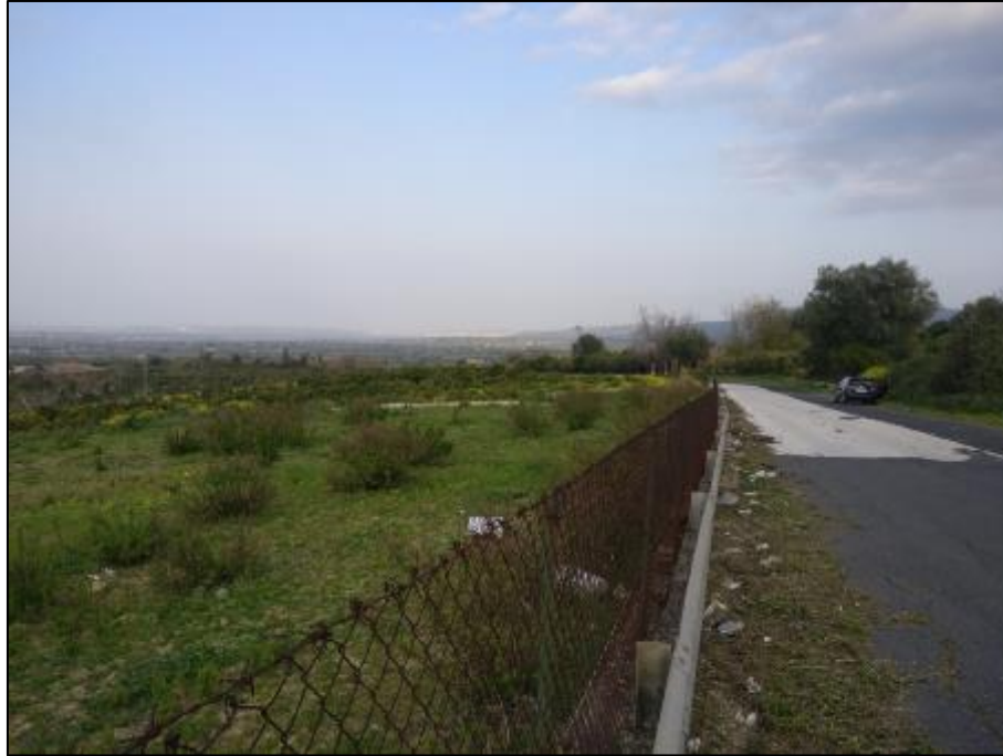
Foto 7.8 – Panoramica della zona di testata della Frana L4_1.
