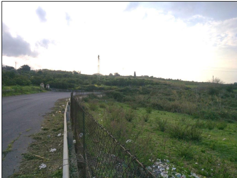
Foto 7.7 – Panoramica della zona di testata della Frana L4_1.
