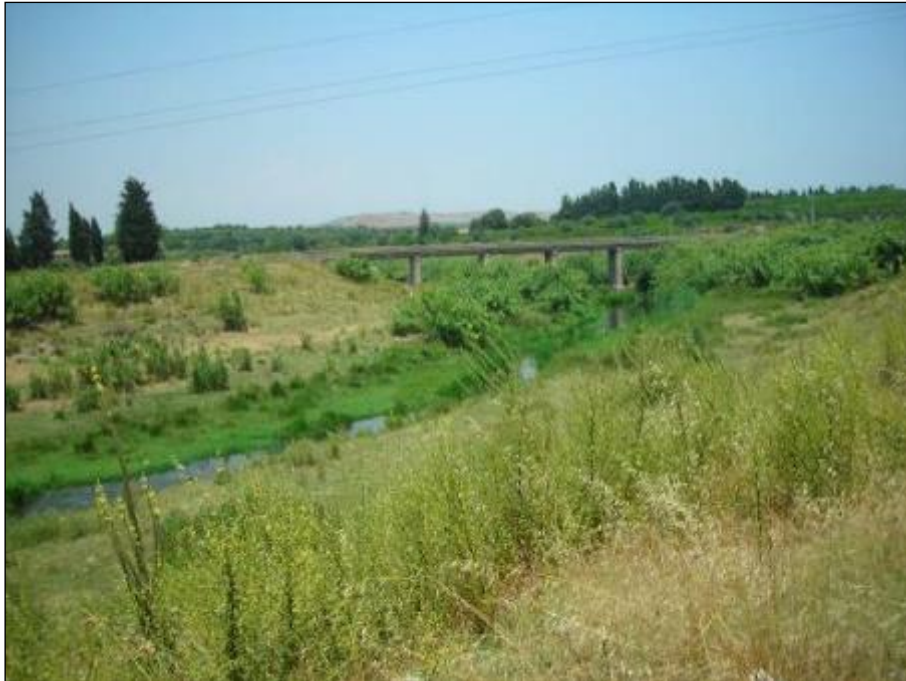
Foto 7.17 – Incisione fluviale del Fiume San Leonardo presso il termine del Lotto.
