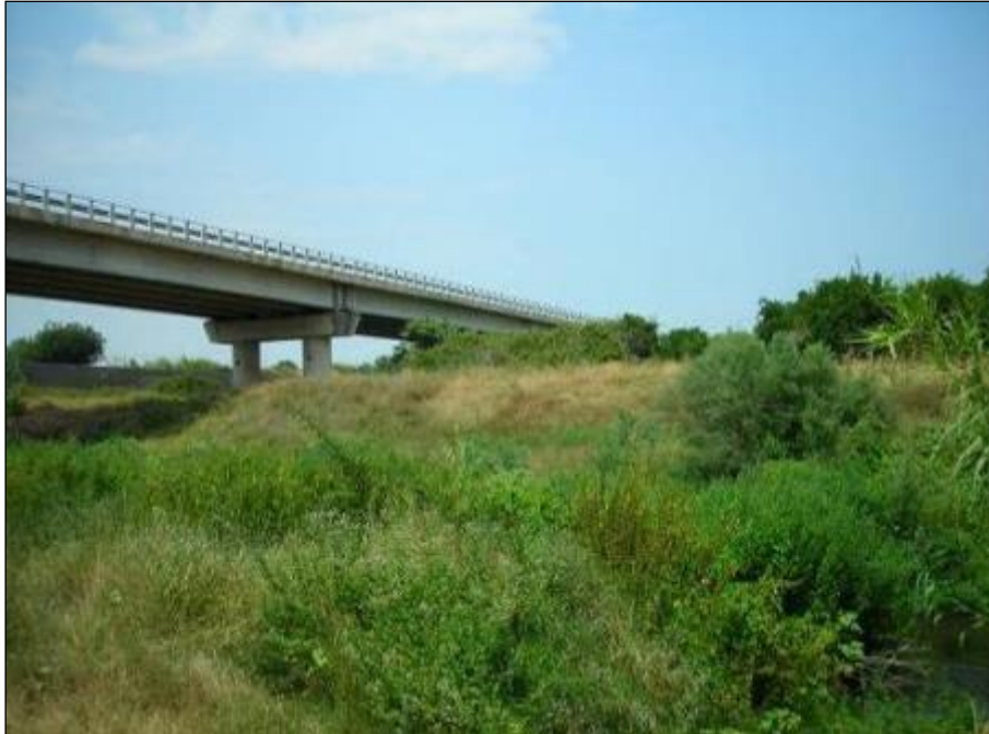
Foto 7.19 – Spalla sinistra dell'esistente Viadotto di fine lotto che oltrepassa il Fiume San Leonardo.
