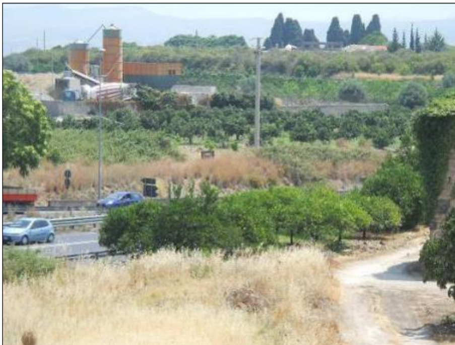
Foto 7.1 – Vista di insieme dell'ampia area terrazzata di Francofonte presso la zona di imbocco meridionale della Galleria di progetto.
