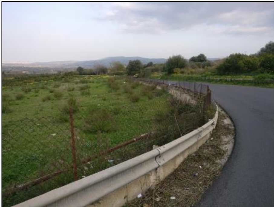
Foto 7.9 – Panoramica della zona di testata della Frana L4_1.
