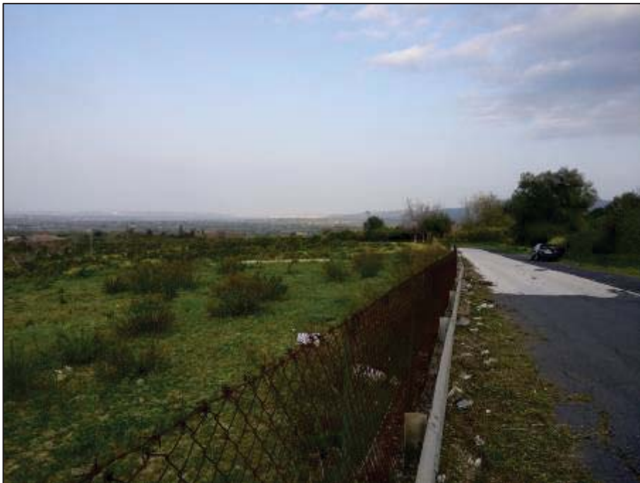
Foto 2.6 – Panoramica di un ulteriore tratto della SP94 riasfaltata.
