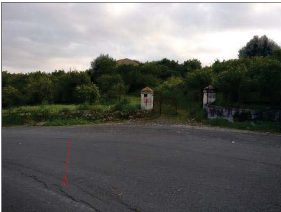
Foto 2.4 – Vistose lesioni e deformazioni presenti sulla strada di Svincolo (SP94) coincidenti con il coronamento della Frana L4_1.
