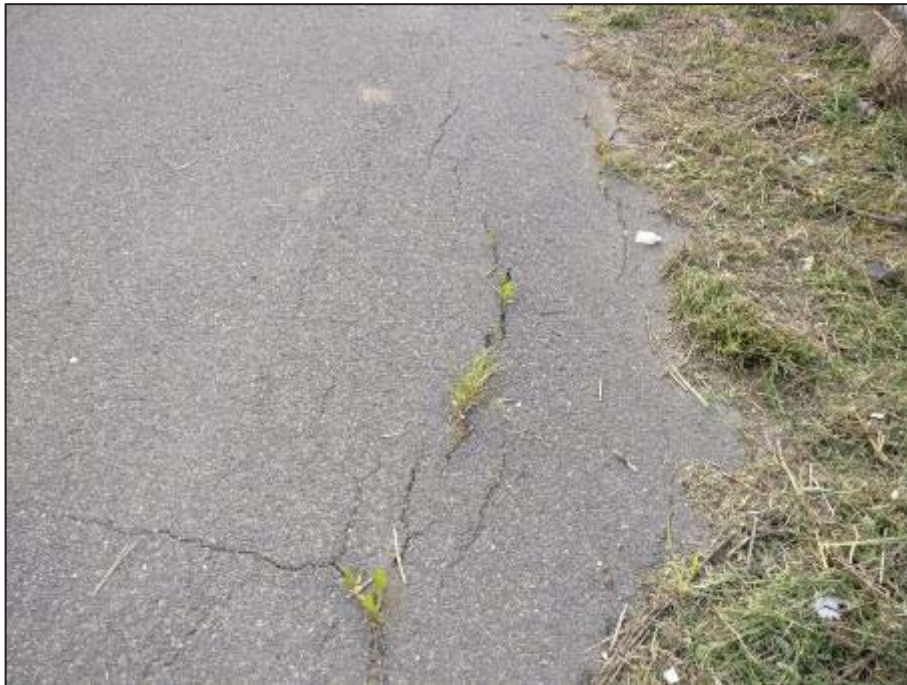
Foto 2.4 – Vistose lesioni e deformazioni presenti sulla strada di Svincolo (SP94) coincidenti con il coronamento della Frana L4_1.
