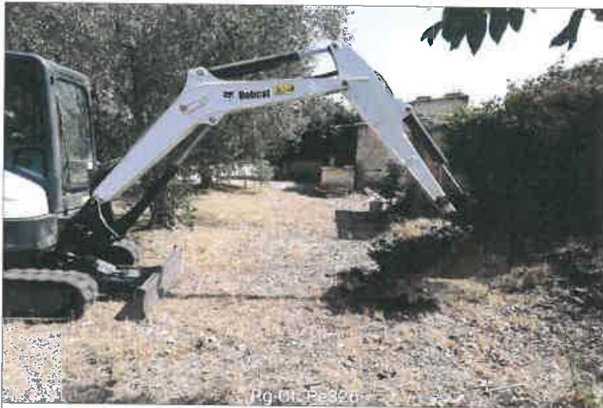
Ubicazione pozzetto esplorativo
