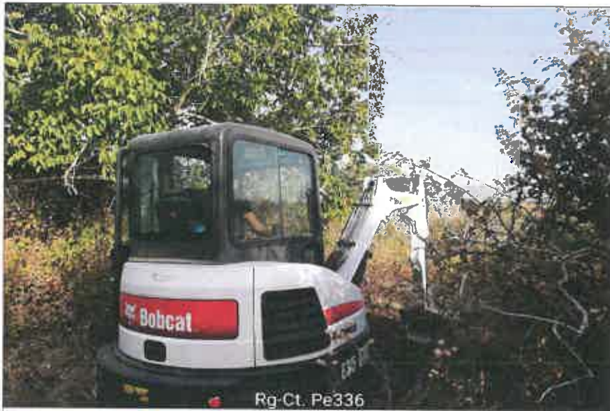
Ubicazione pozzetto esplorativo
