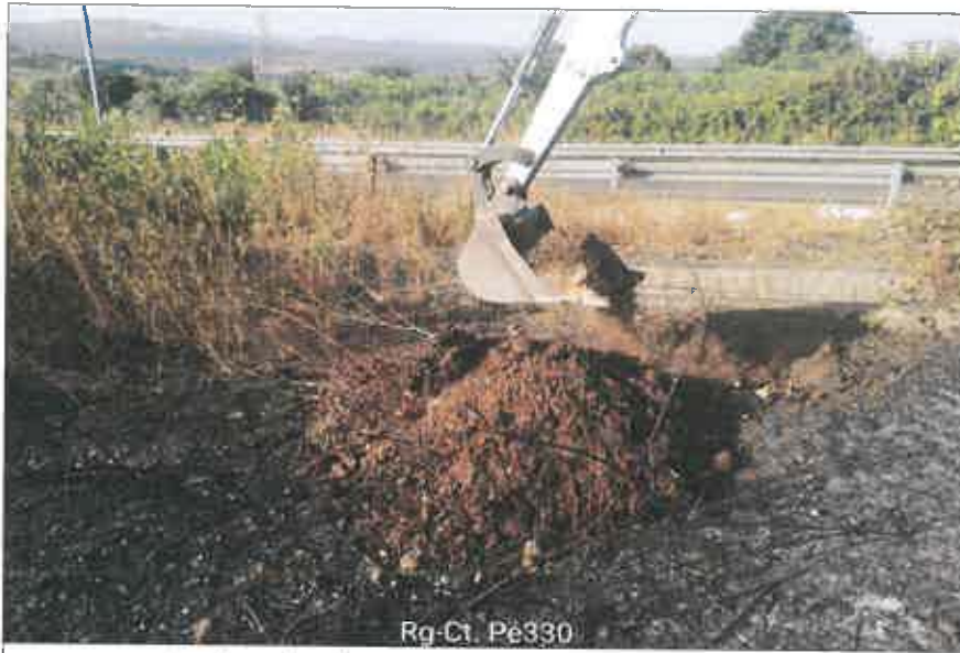
Ubicazione pozzetto esplorativo
