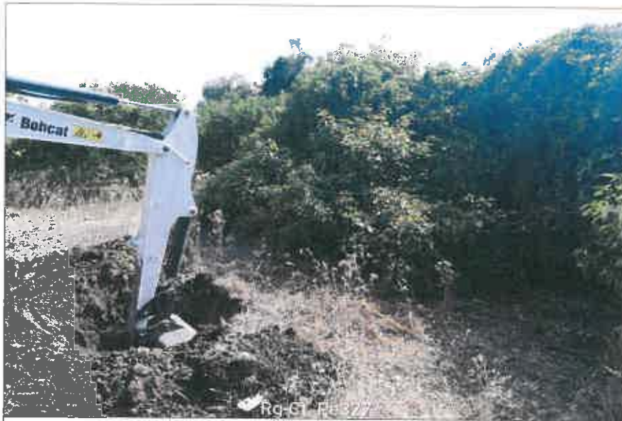
Ubicazione pozzetto esplorativo
