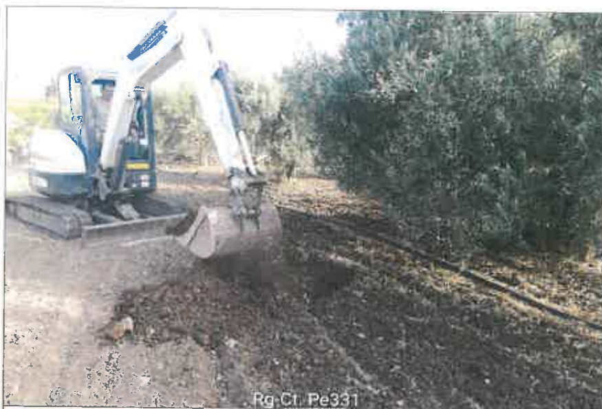
Ubicazione pozzetto esplorativo
