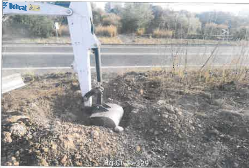
Ubicazione pozzetto esplorativo
