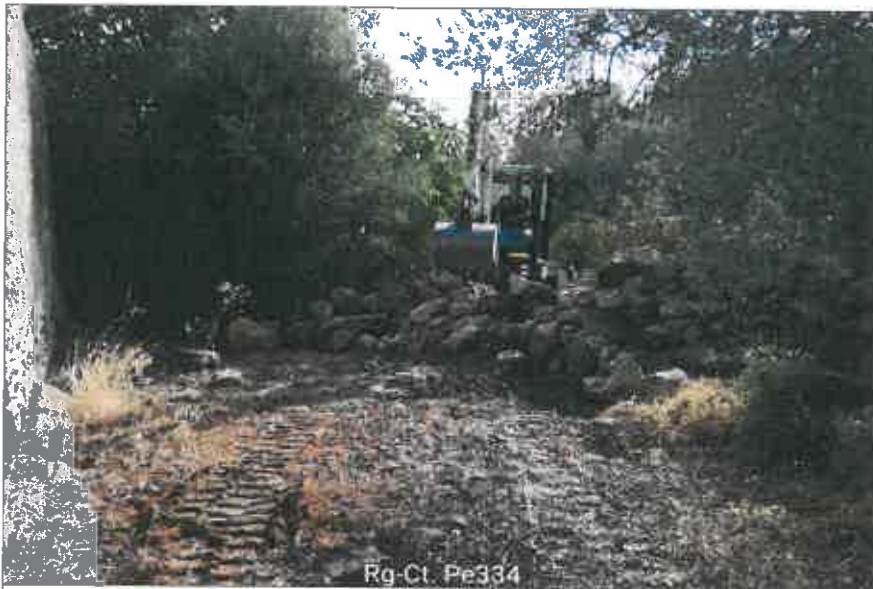
Ubicazione pozzetto esplorativo
