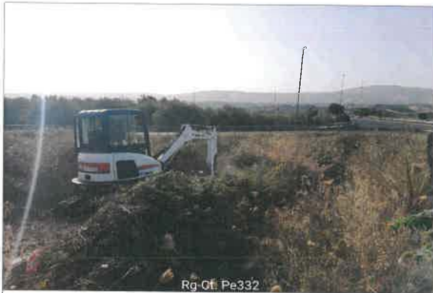
Ubicazione pozzetto esplorativo
