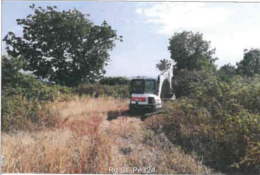
Ubicazione pozzetto esplorativo
