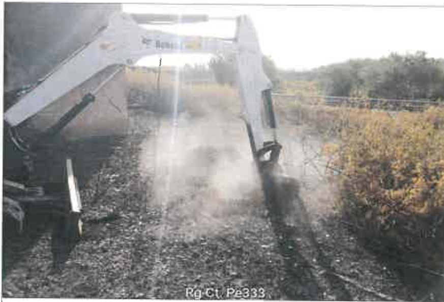
Ubicazione pozzetto esplorativo
