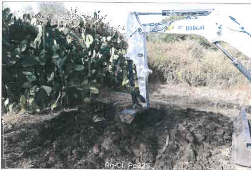
Ubicazione pozzetto esplorativo
