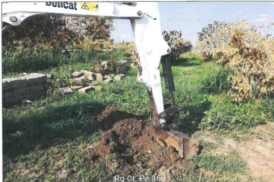
Ubicazione pozzetto esplorativo
