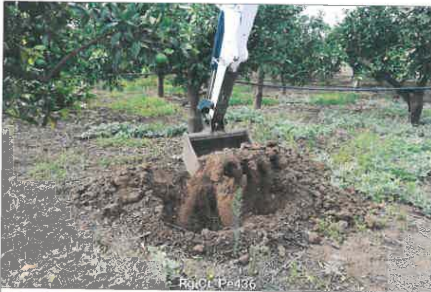
Ubicazione pozzetto esplorativo
