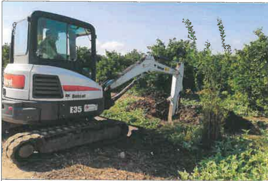
Ubicazione pozzetto esplorativo
