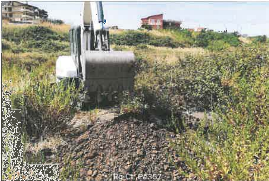
Ubicazione pozzetto esplorativo
