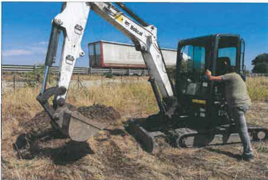
Ubicazione pozzetto esplorativo
