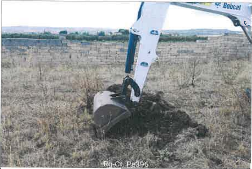
Rg-Ct. Pe396 Ubicazione pozzetto esplorativo
