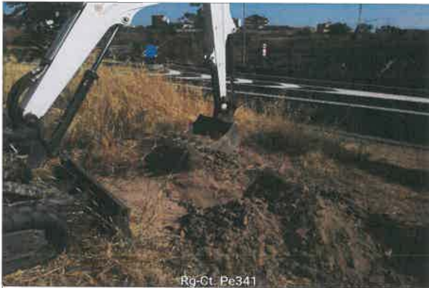
Ubicazione pozzetto esplorativo
