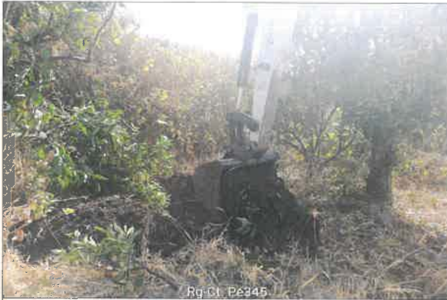
Ubicazione pozzetto esplorativo
