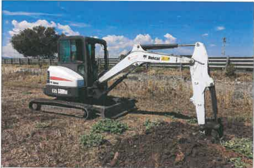
Ubicazione pozzetto esplorativo
