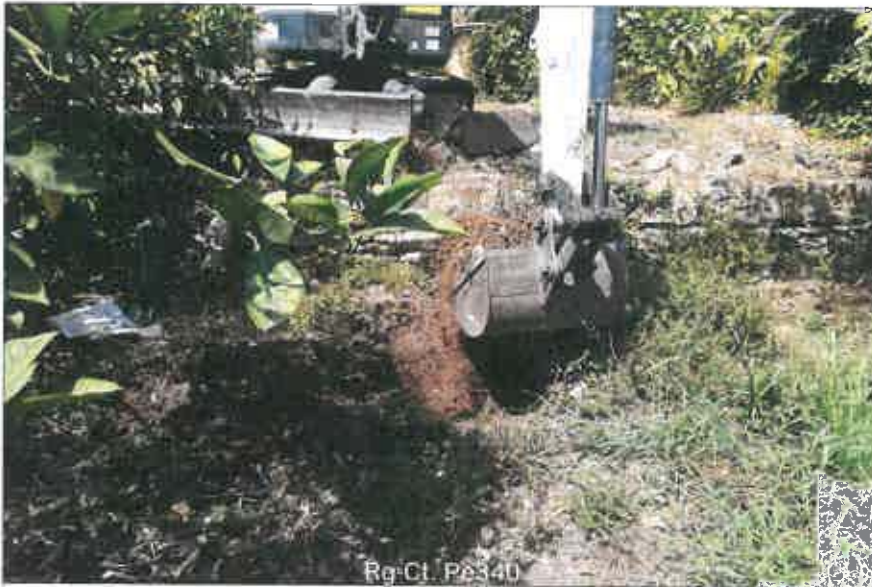
Ubicazione pozzetto esplorativo
