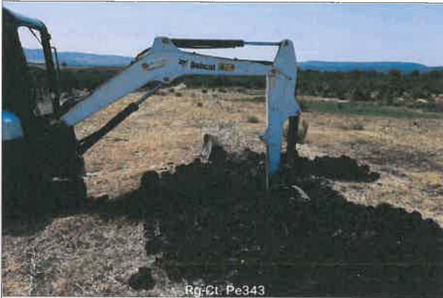
Ubicazione pozzetto esplorativo
