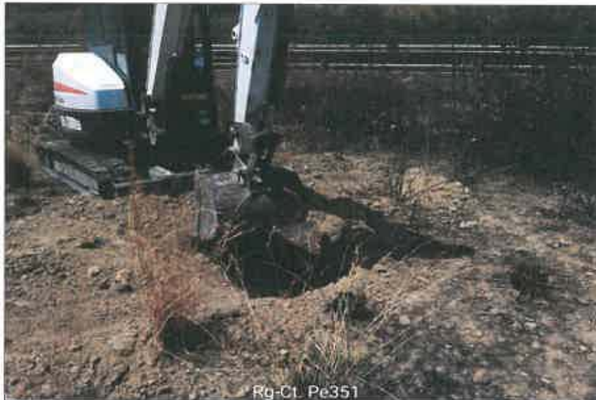
Ubicazione pozzetto esplorativo
