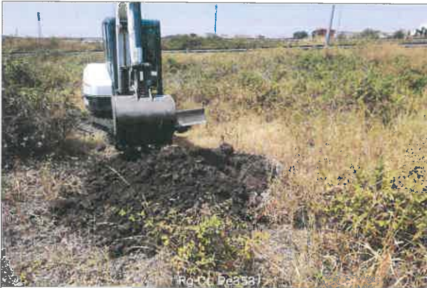
Ubicazione pozzetto esplorativo
