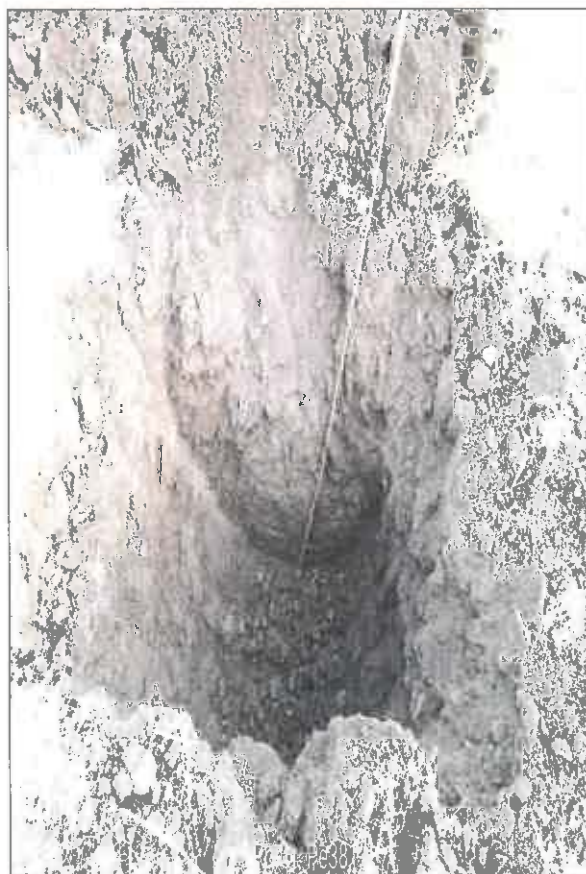
Pozzetto esplorativo - profondità da m 0,00 a m 1,00
