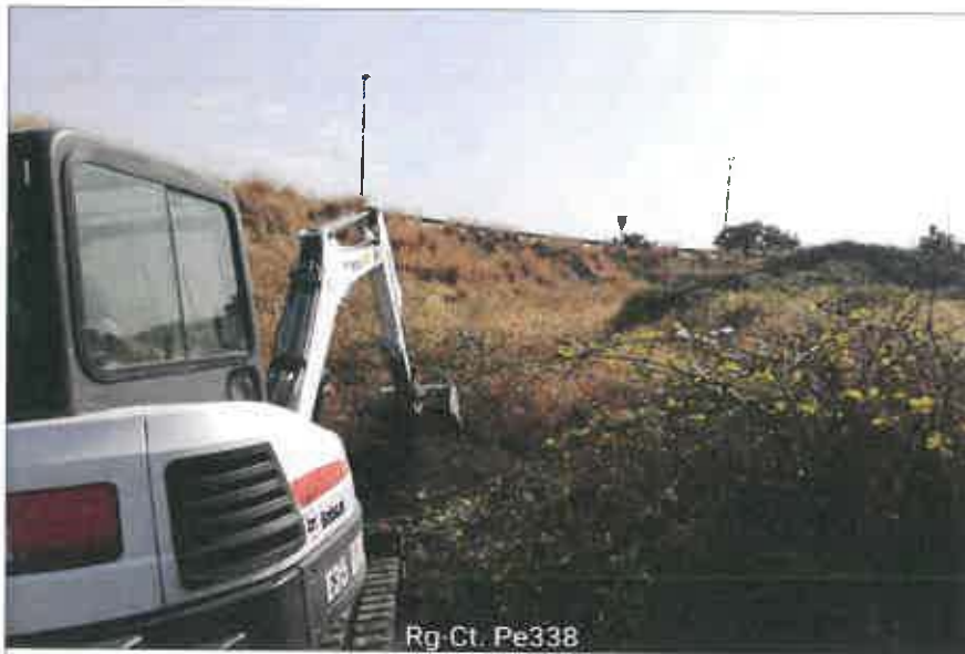
Ubicazione pozzetto esplorativo
