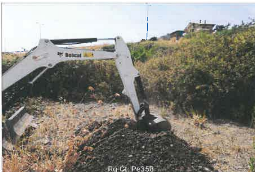
Ubicazione pozzetto esplorativo
