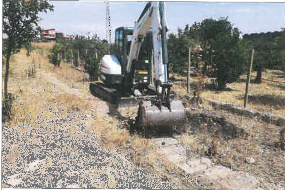
Ubicazione pozzetto esplorativo
