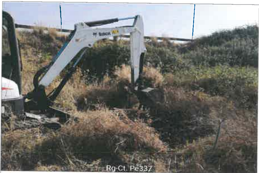
Ubicazione pozzetto esplorativo
