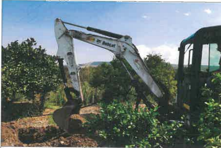
Ubicazione pozzetto esplorativo
