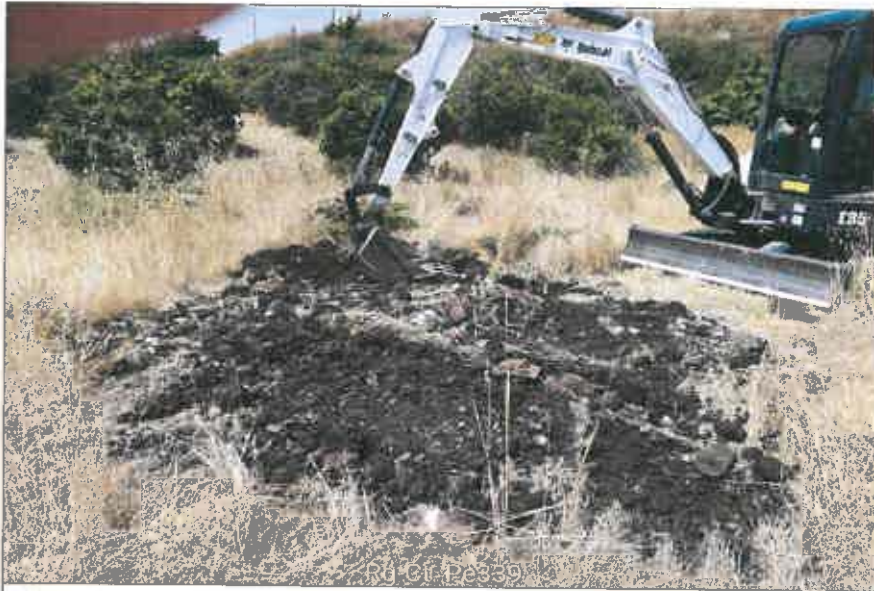
Ubicazione pozzetto esplorativo
