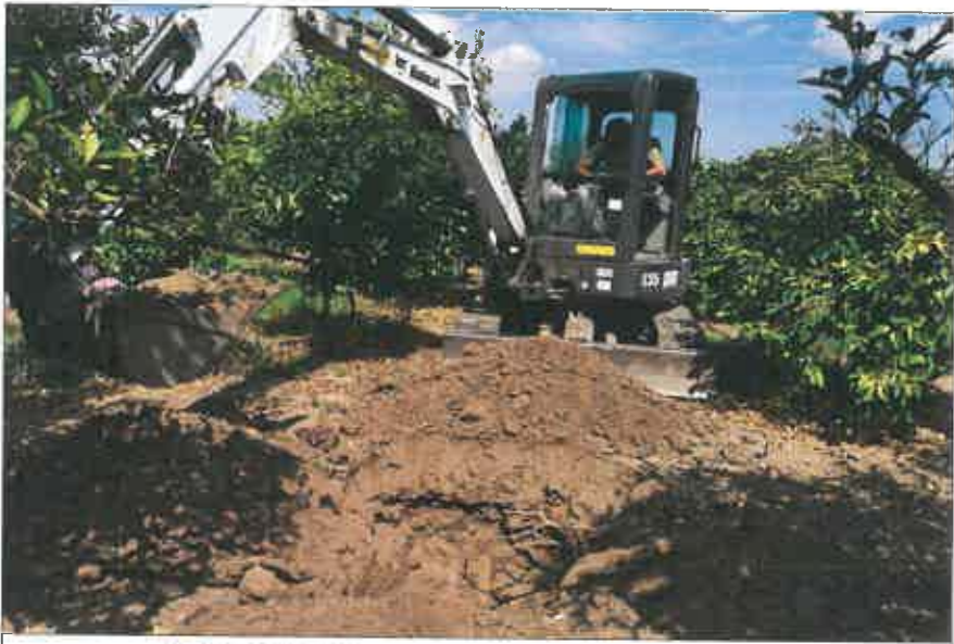
Ubicazione pozzetto esplorativo
