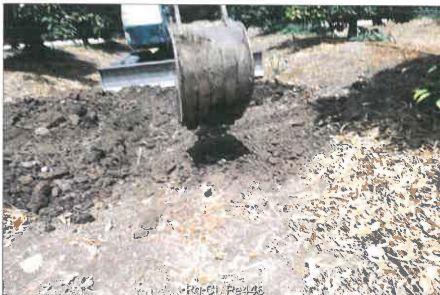
Ubicazione pozzetto esplorativo
