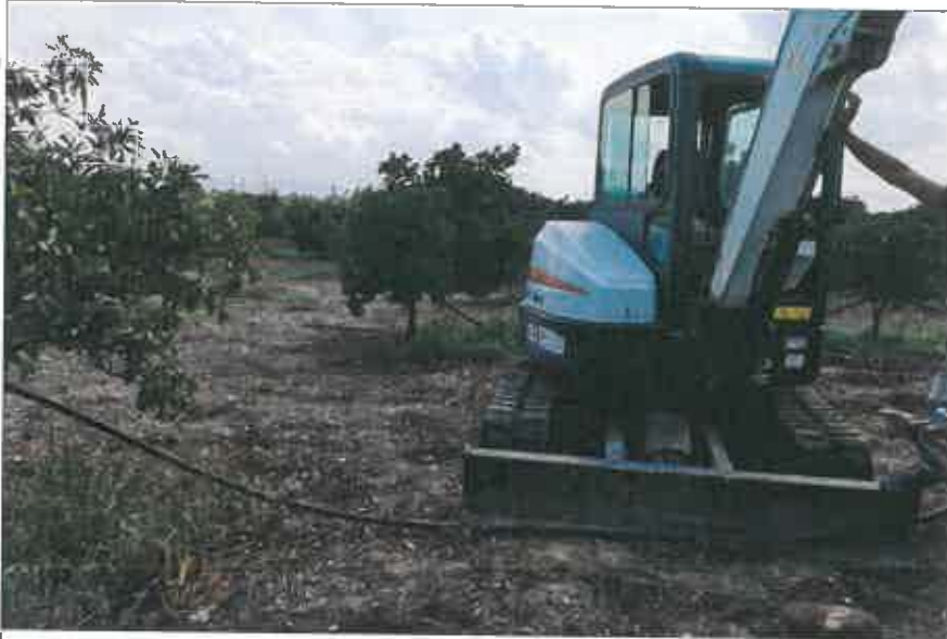
Ubicazione pozzetto esplorativo
