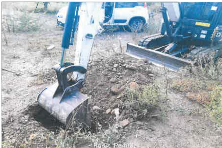
Ubicazione pozzetto esplorativo
