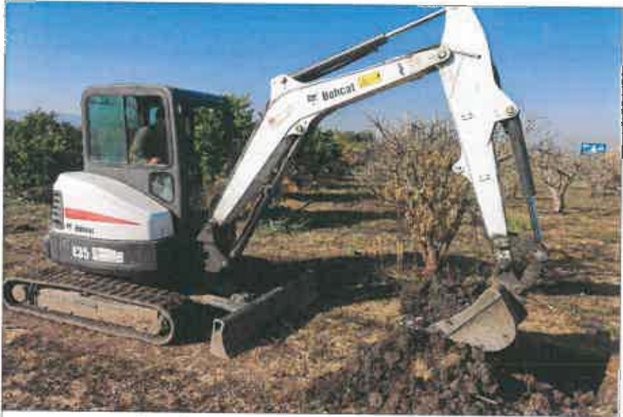
Ubicazione pozzetto esplorativo
