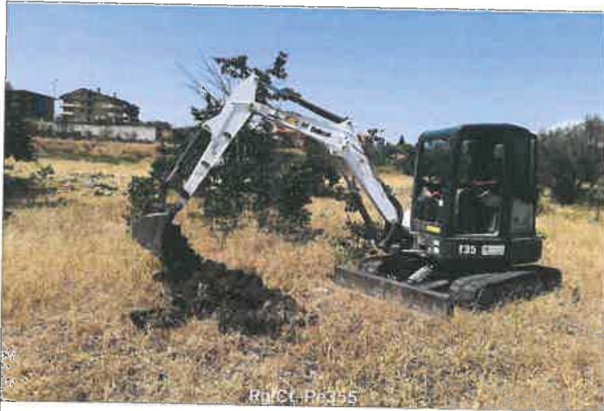
Ubicazione pozzetto esplorativo
