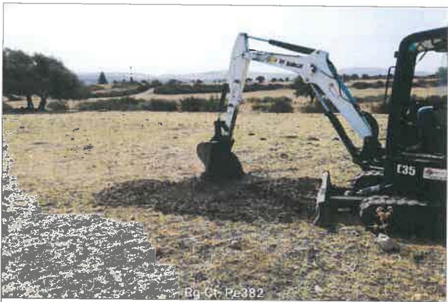
Ubicazione pozzetto esplorativo
