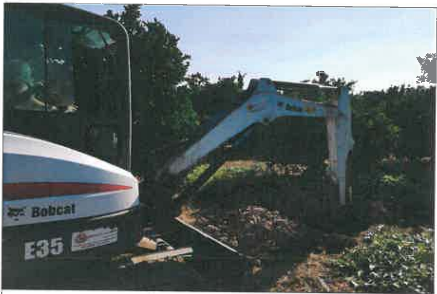
Ubicazione pozzetto esplorativo
