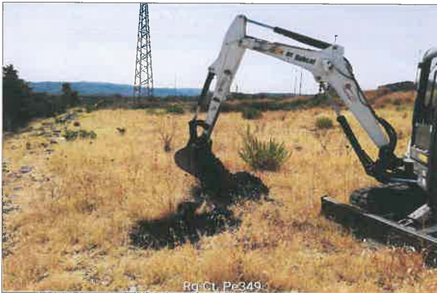
Ubicazione pozzetto esplorativo
