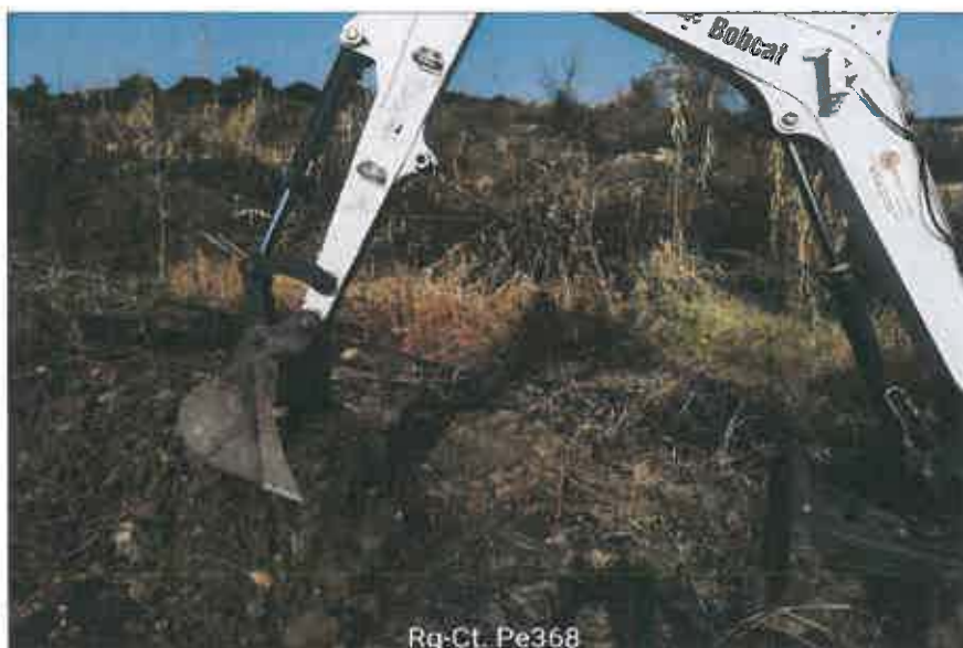
Ubicazione pozzetto esplorativo
