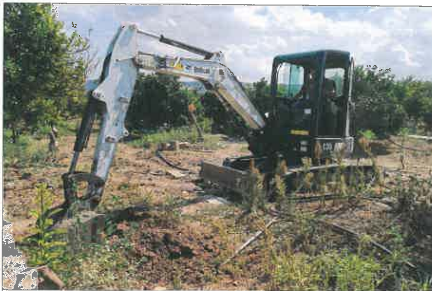
Ubicazione pozzetto esplorativo
