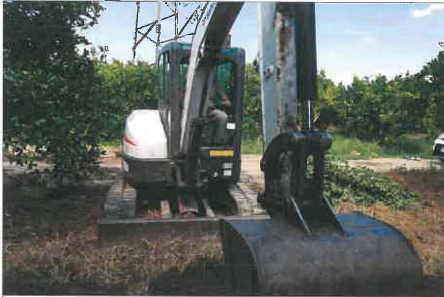
Ubicazione pozzetto esplorativo
