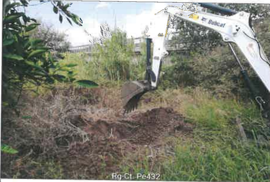
Ubicazione pozzetto esplorativo
