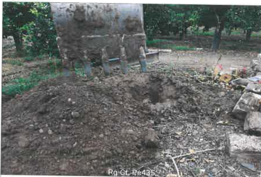
Ubicazione pozzetto esplorativo
