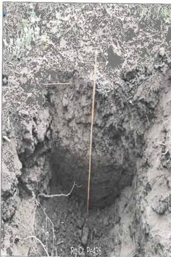
Pozzetto esplorativo
