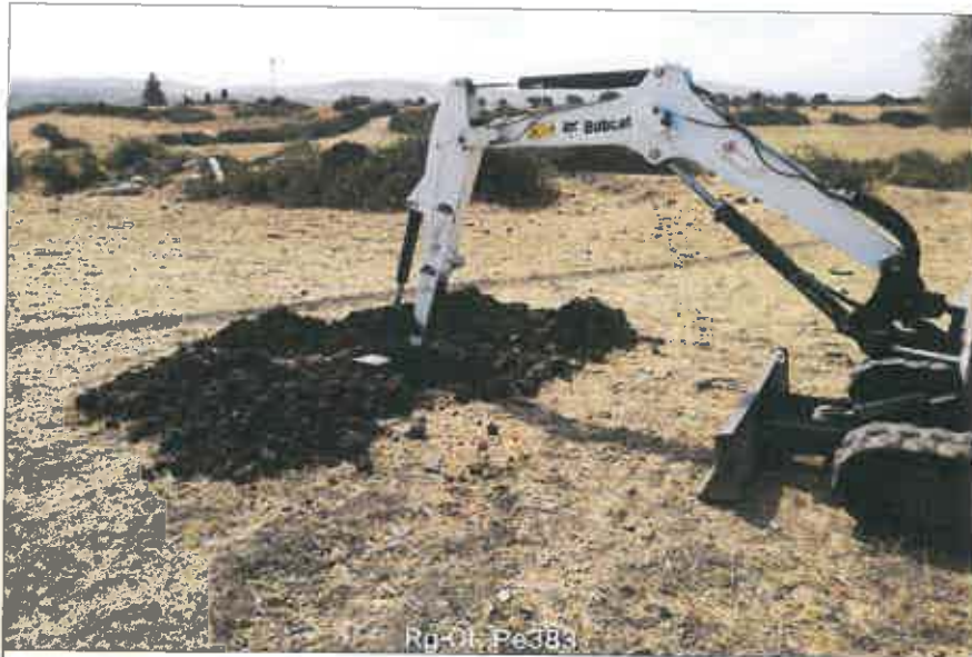
Ubicazione pozzetto esplorativo
