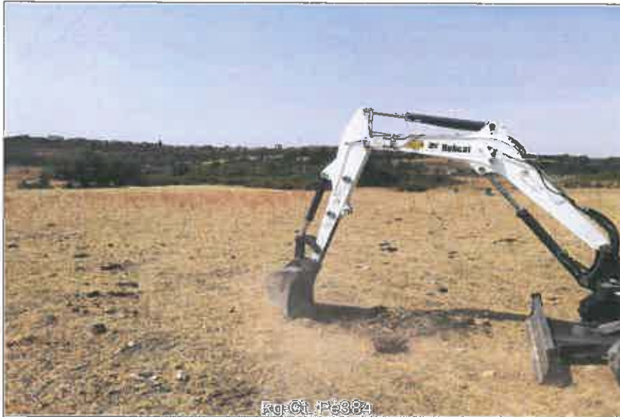
Ubicazione pozzetto esplorativo
