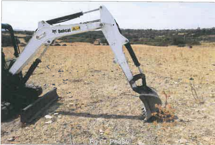
Ubicazione pozzetto esplorativo
