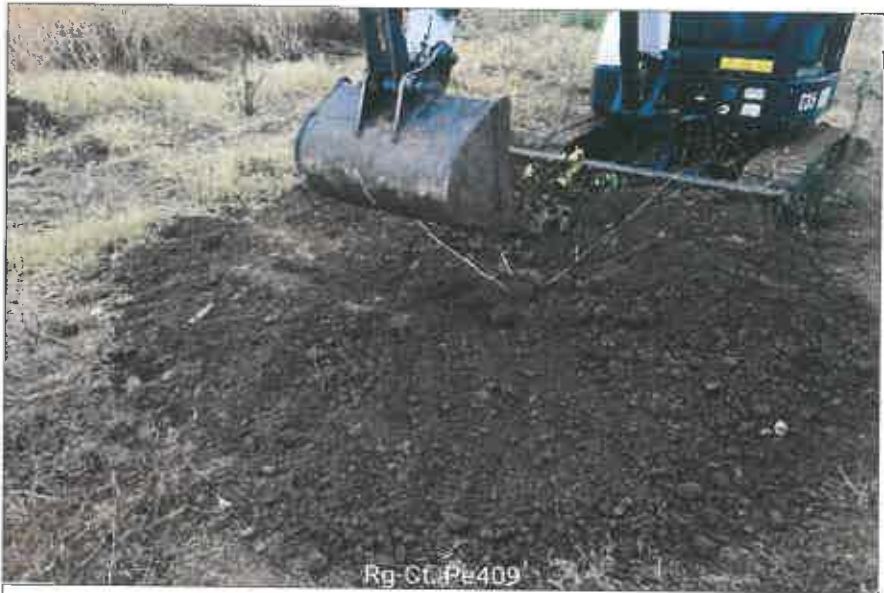
Ubicazione pozzetto esplorativo
