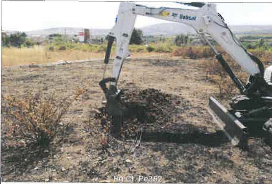
Ubicazione pozzetto esplorativo
