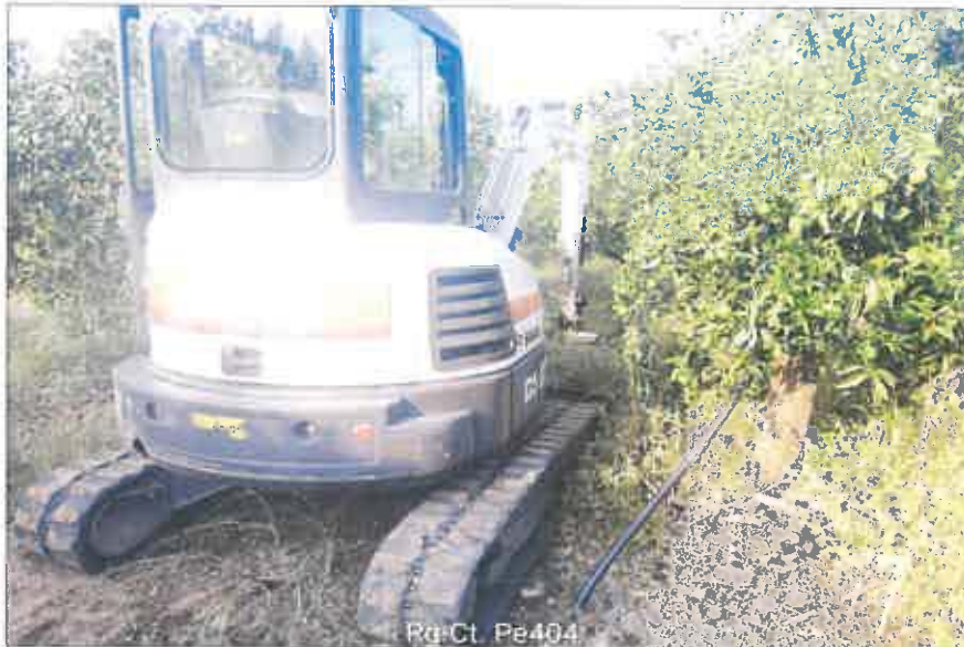
Ubicazione pozzetto esplorativo
