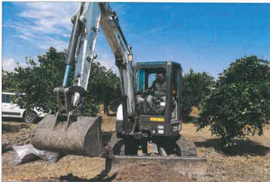
Ubicazione pozzetto esplorativo
