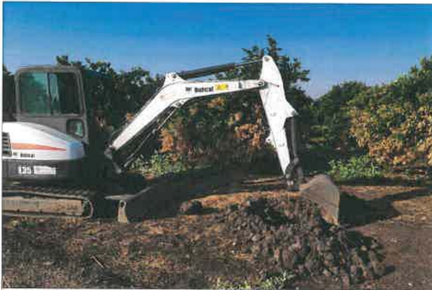
Ubicazione pozzetto esplorativo
