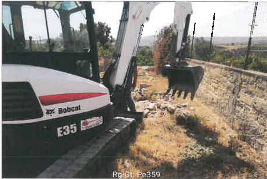
Ubicazione pozzetto esplorativo
