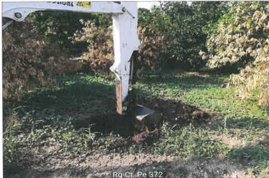
Ubicazione pozzetto esplorativo
