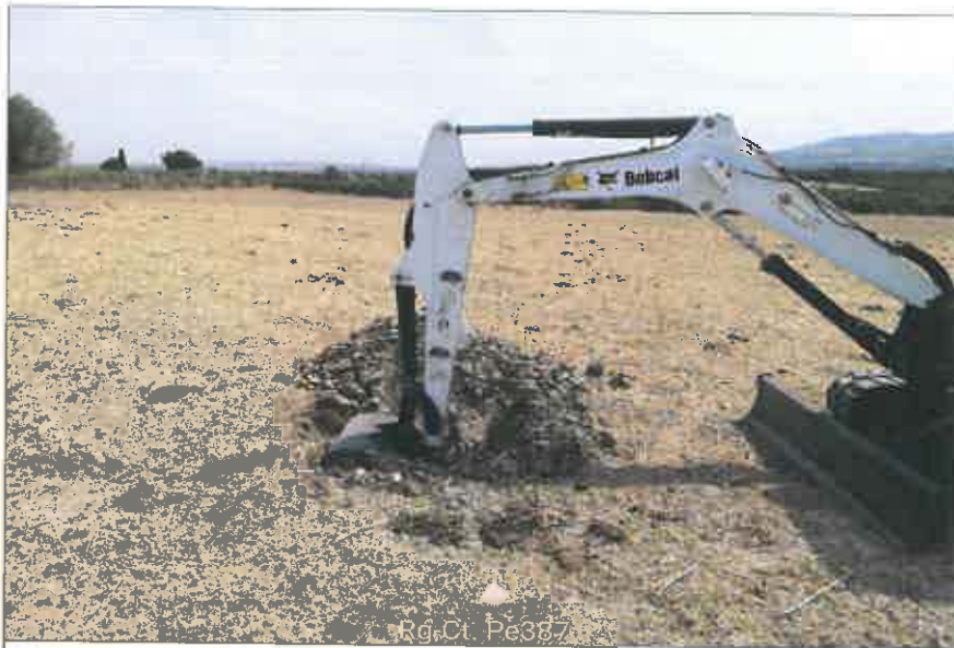
Rg.Ct. Pe387 Ubicazione pozzetto esplorativo
