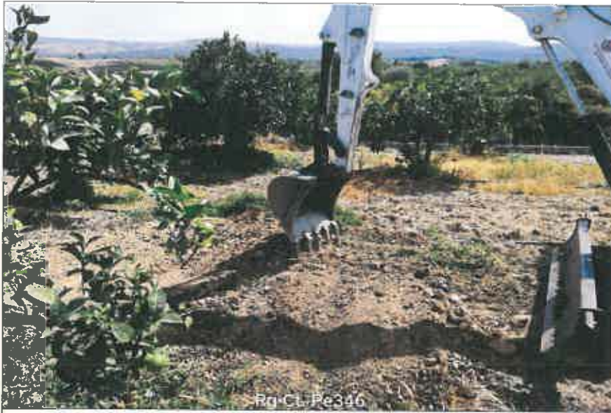
Ubicazione pozzetto esplorativo
