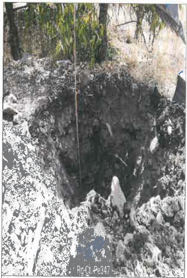
Pozzetto esplorativo - profondità da m 0,00 a m 1,00
