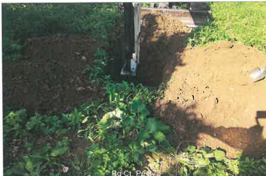
Ubicazione pozzetto esplorativo
