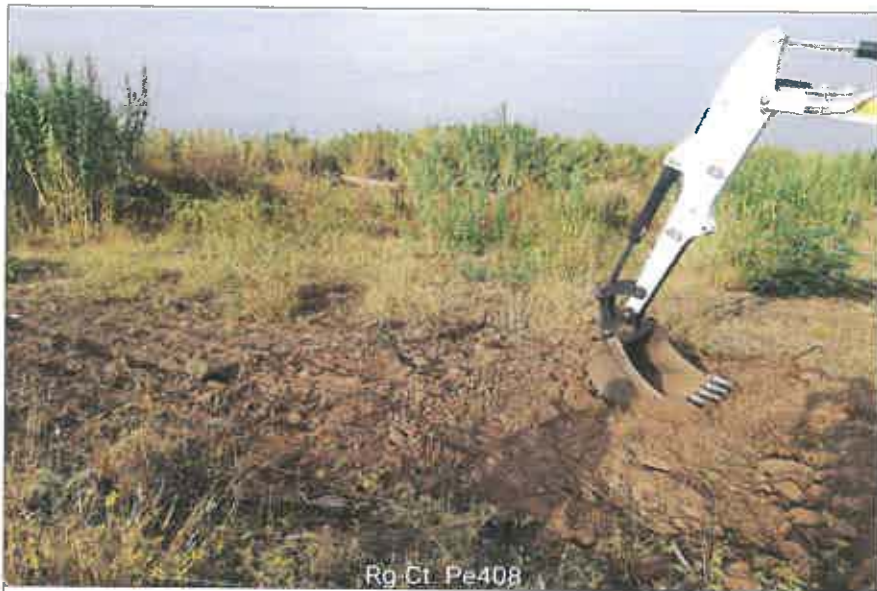
Ubicazione pozzetto esplorativo
