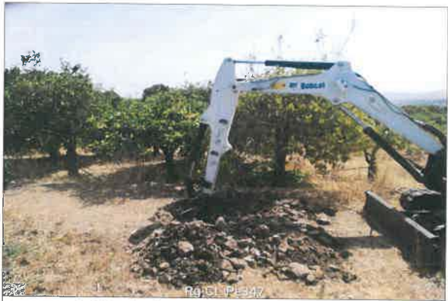
Ubicazione pozzetto esplorativo
