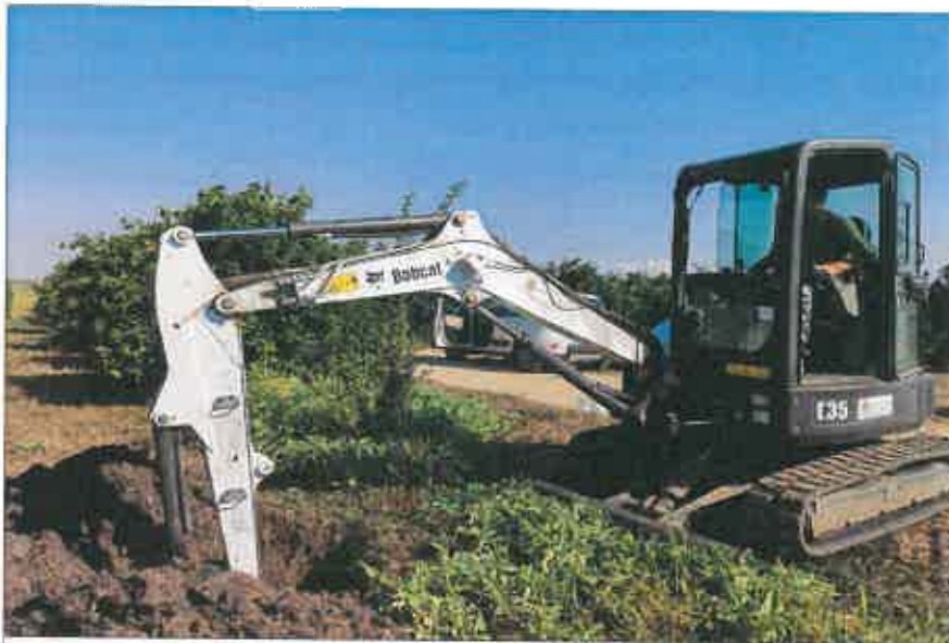
Ubicazione pozzetto esplorativo
