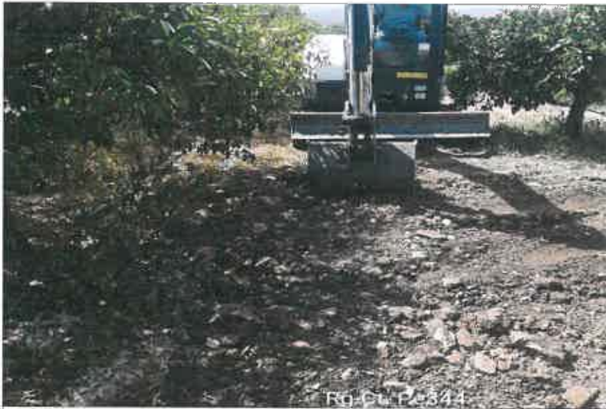
Ubicazione pozzetto esplorativo
