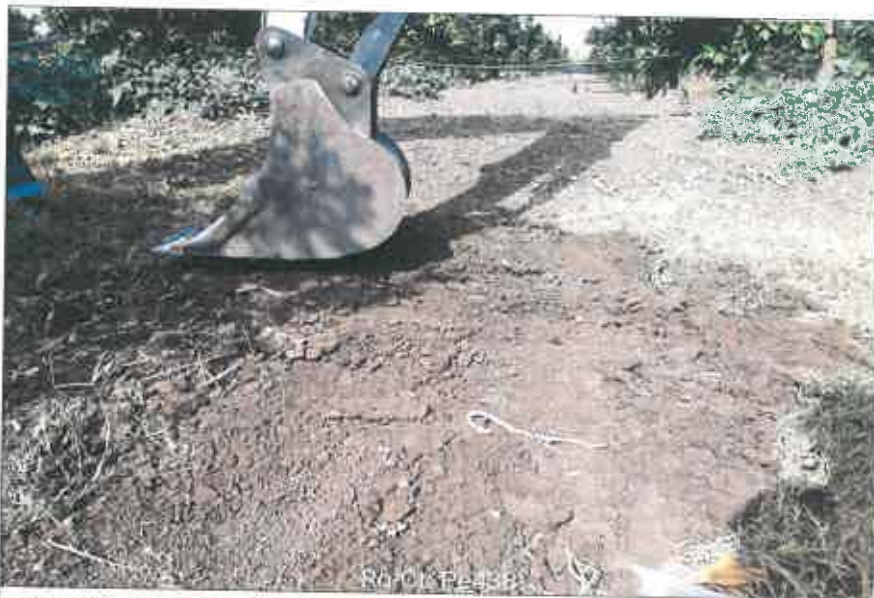
Ubicazione pozzetto esplorativo
