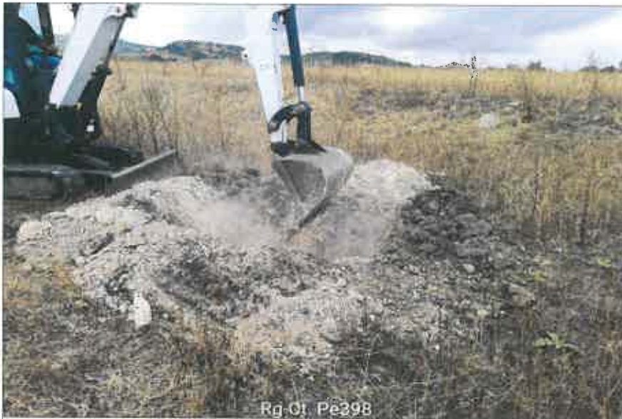
Ubicazione pozzetto esplorativo
