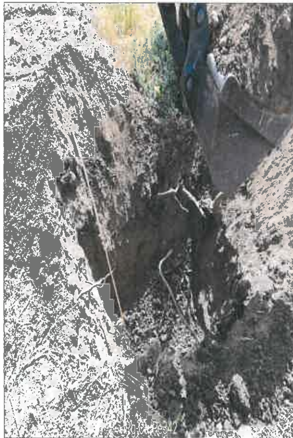
Pozzetto esplorativo - profondità da m 0,00 a m 1,00
