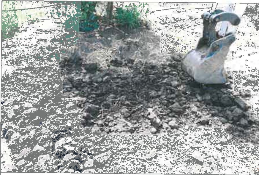
Ubicazione pozzetto esplorativo
