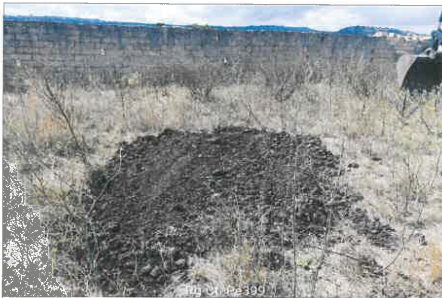
Ubicazione pozzetto esplorativo
