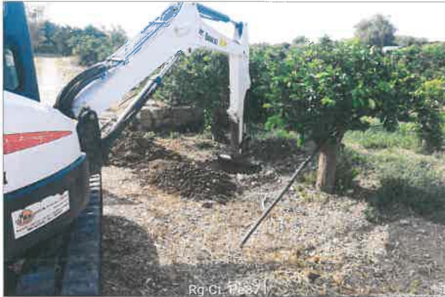
Ubicazione pozzetto esplorativo
