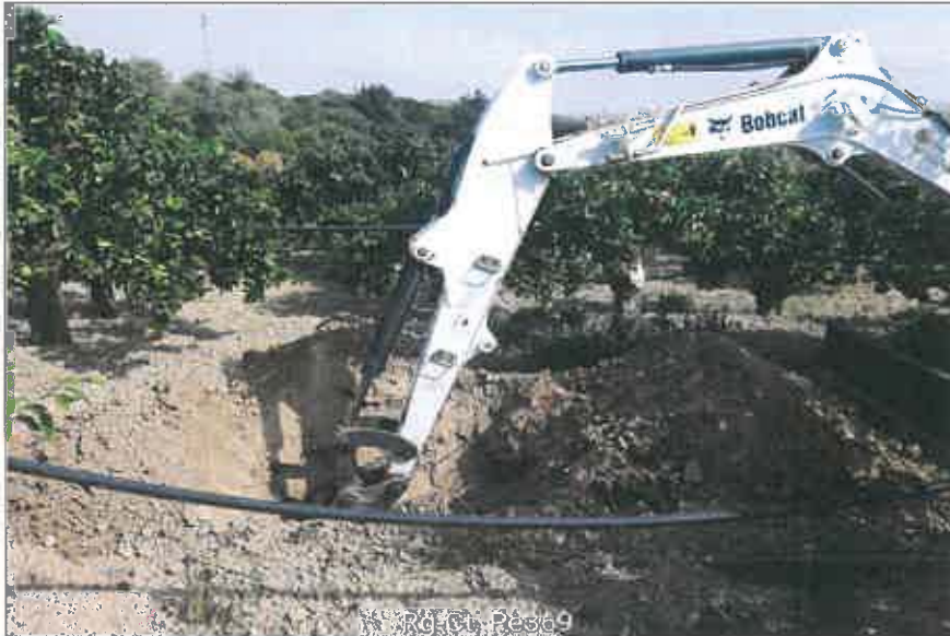
Ubicazione pozzetto esplorativo
