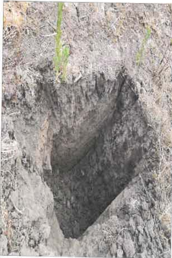
Pozzetto esplorativo
