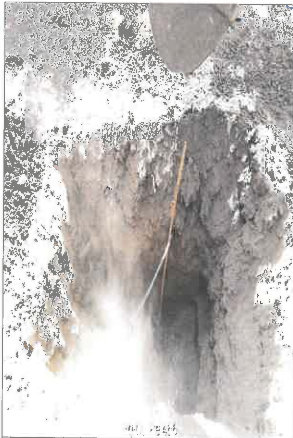
Pozzetto esplorativo
