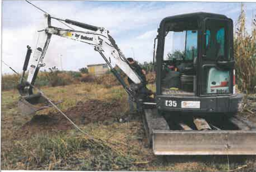
Ubicazione pozzetto esplorativo
