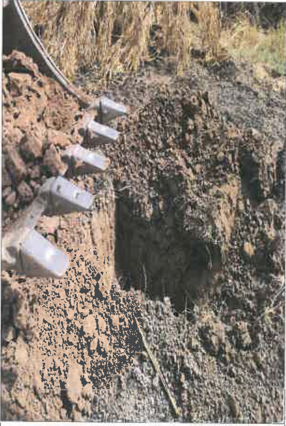
Pozzetto esplorativo
