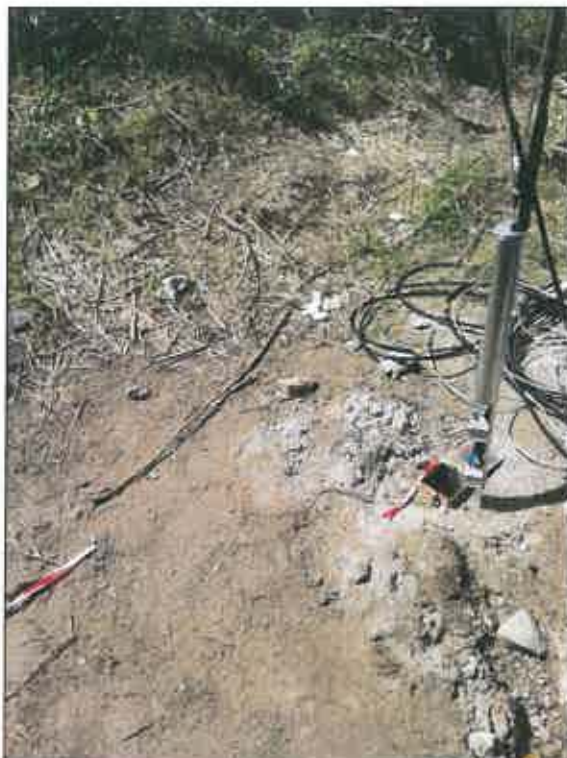
Martello fondo foro ad ancoraggio pneumatico
