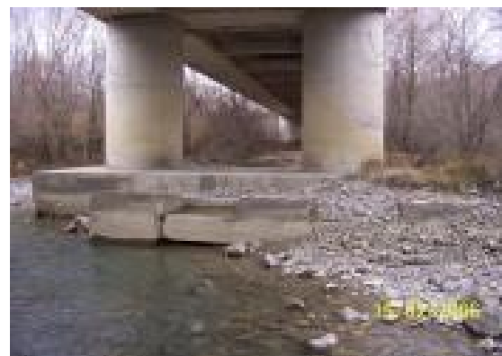
Figura 7-6 - esempi del fenomeno di erosione localizzata alla base delle pile.
