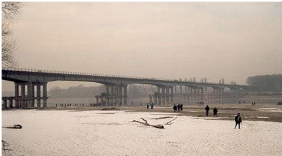
Figura 7-4: Esempio di erosione generalizzata sul fiume Po
