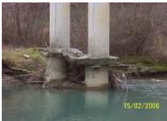
Figura 7-6 - esempi del fenomeno di erosione localizzata alla base delle pile.
