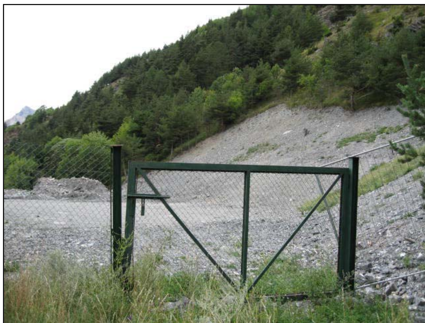
IMBOCCO DEL TUNNEL - area 2 disponibile non riqualificata
