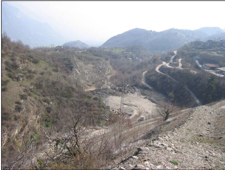
DISCARICA PIANBARALE - Vista del sito di deposito
