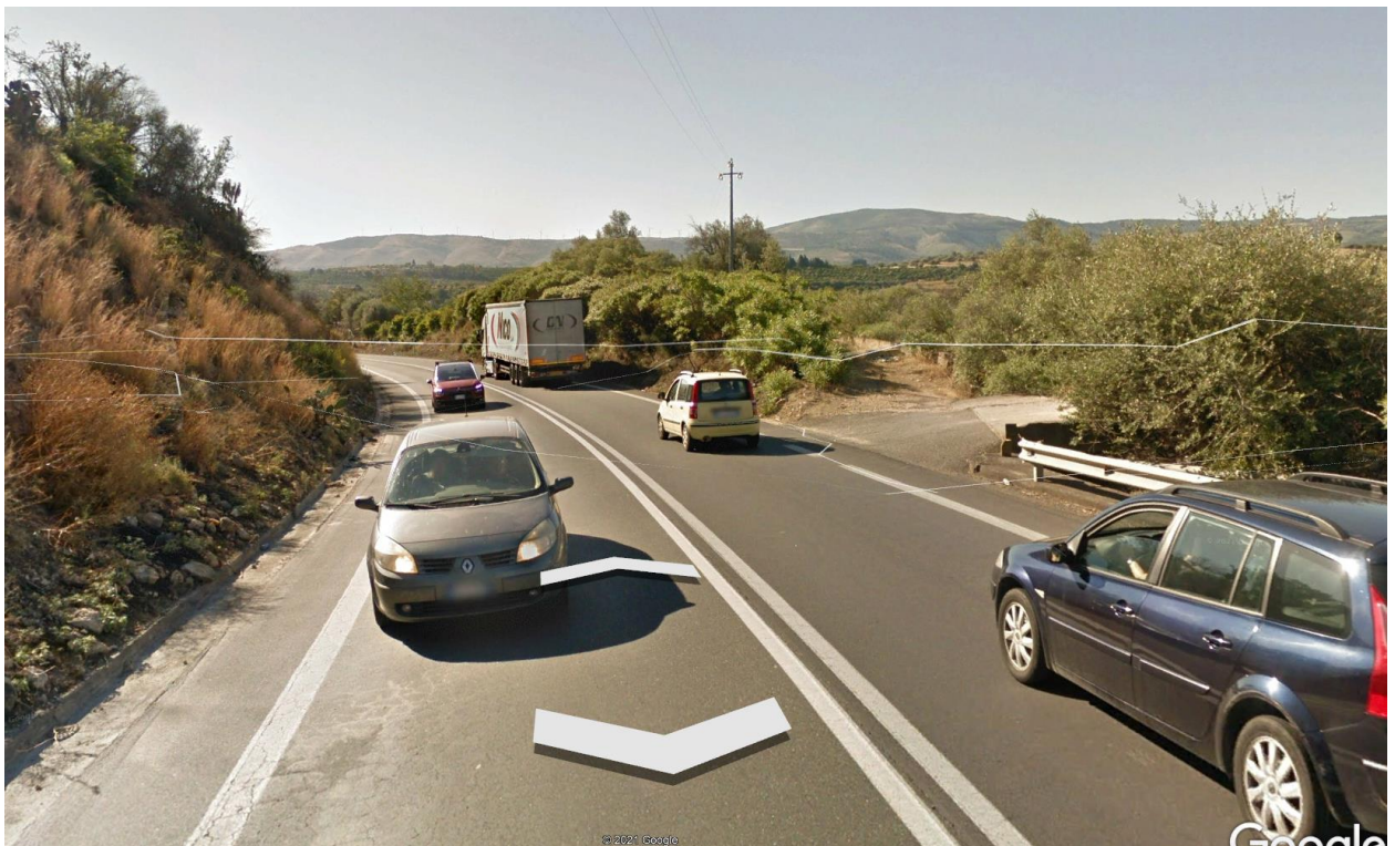
Figura 4-1: Vista della Strada esistente
