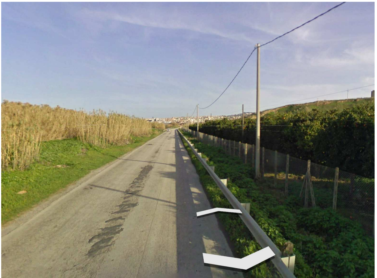
Figura 2: Vista della Strada esistente
