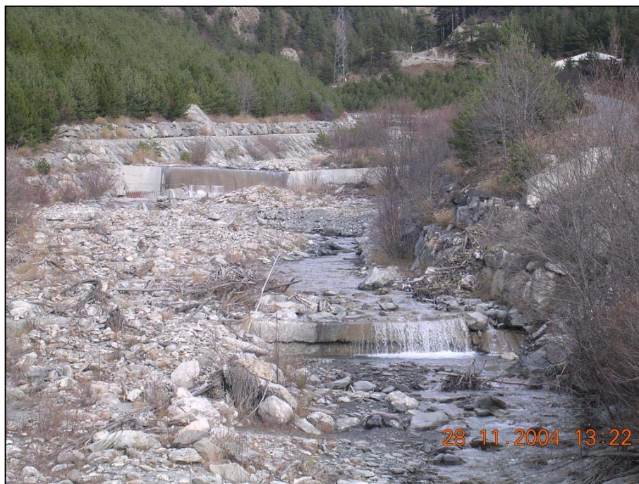
Alveo ingombro di materiale sedimentato
