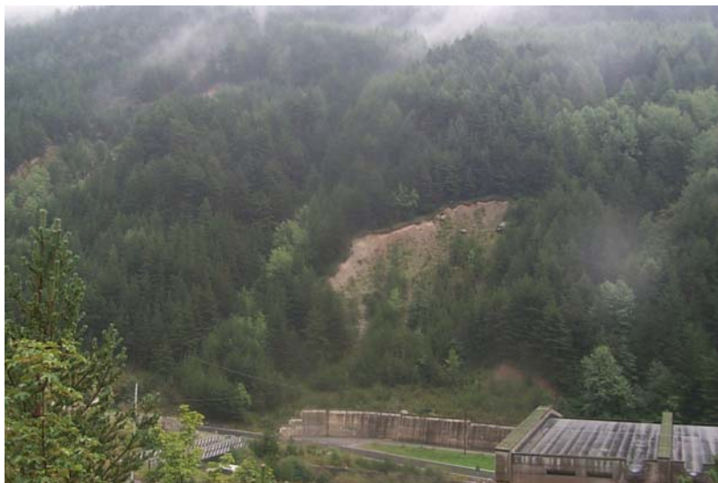
IMBOCCO DEL TUNNEL - movimento gravitativo
