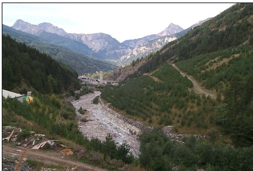
IMBOCCO DEL TUNNEL - Zona deposito
