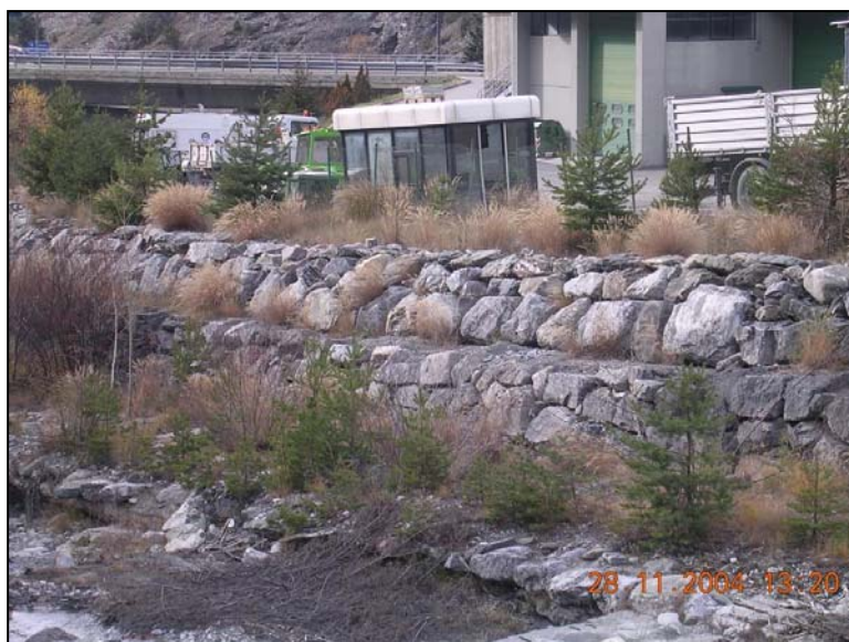
Area interessata dalla messa a dimora della barriera vegetale
