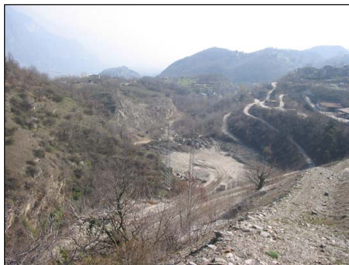
DISCARICA PIANBARALE - Vista del sito di deposito
