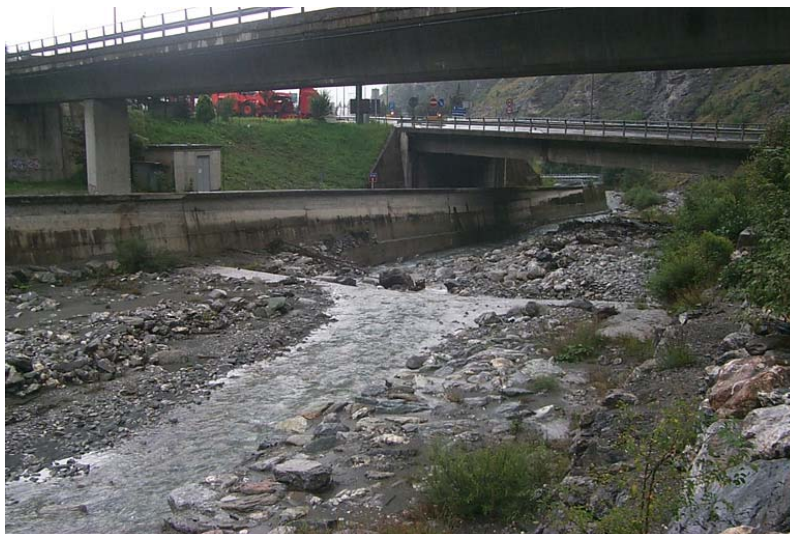
IMBOCCO DEL TUNNEL - Torrente Rochemolles
