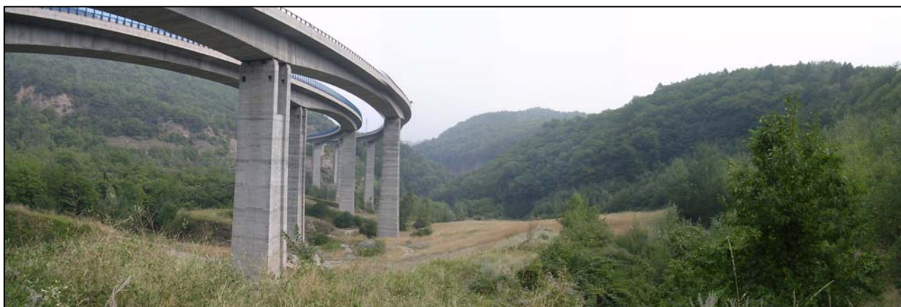
SITO LA MADDALENA - Zona cantiere
