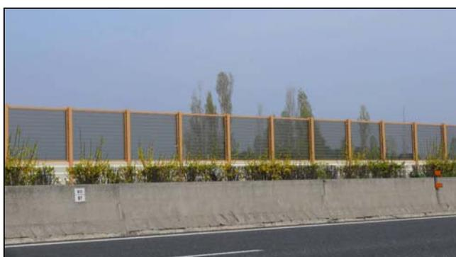
*Esempio di barriera con pannelli trasparenti con trattamento anticollisione dell'avifauna mediante strisce satiniate ottenute per abrasione.*
