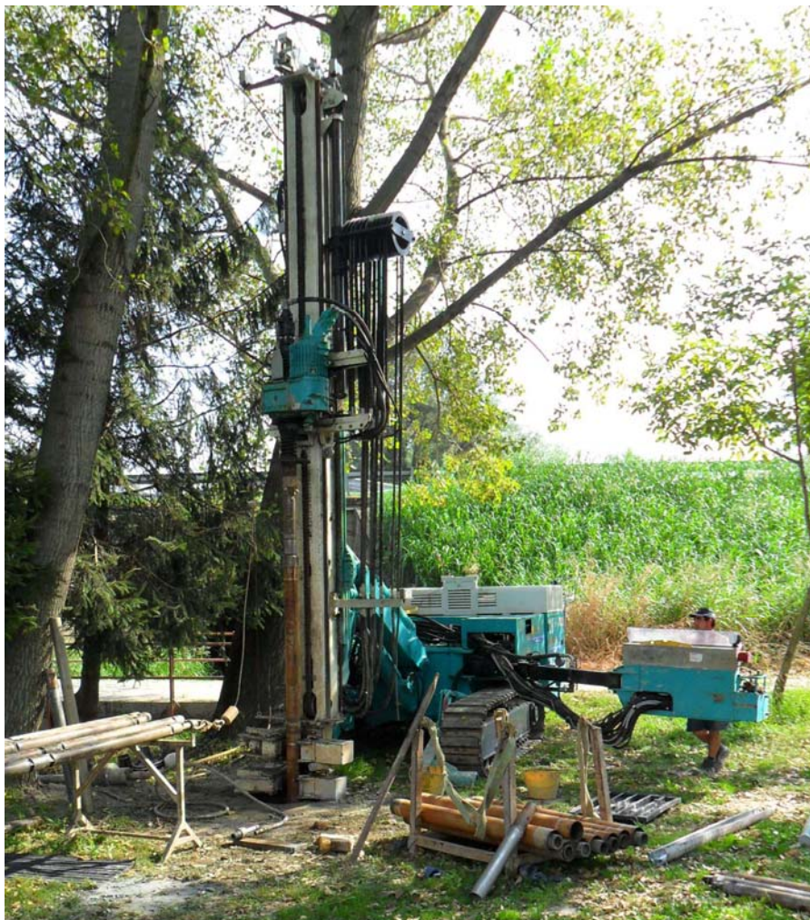
Sonda perforatrice Casagrande C6. Postazione S.3 Fasi di Sondaggio
