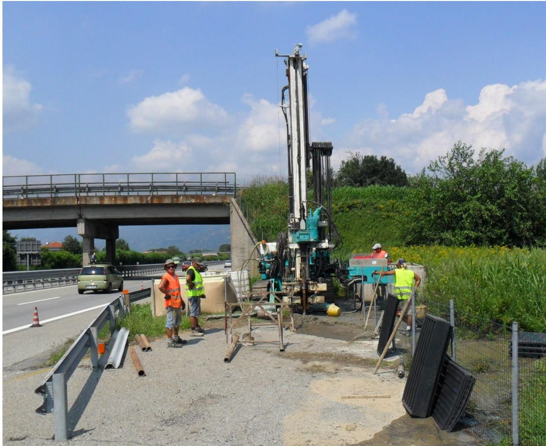
Sonda perforatrice Casagrande C6. Postazione S.1 Fasi di carotaggio
