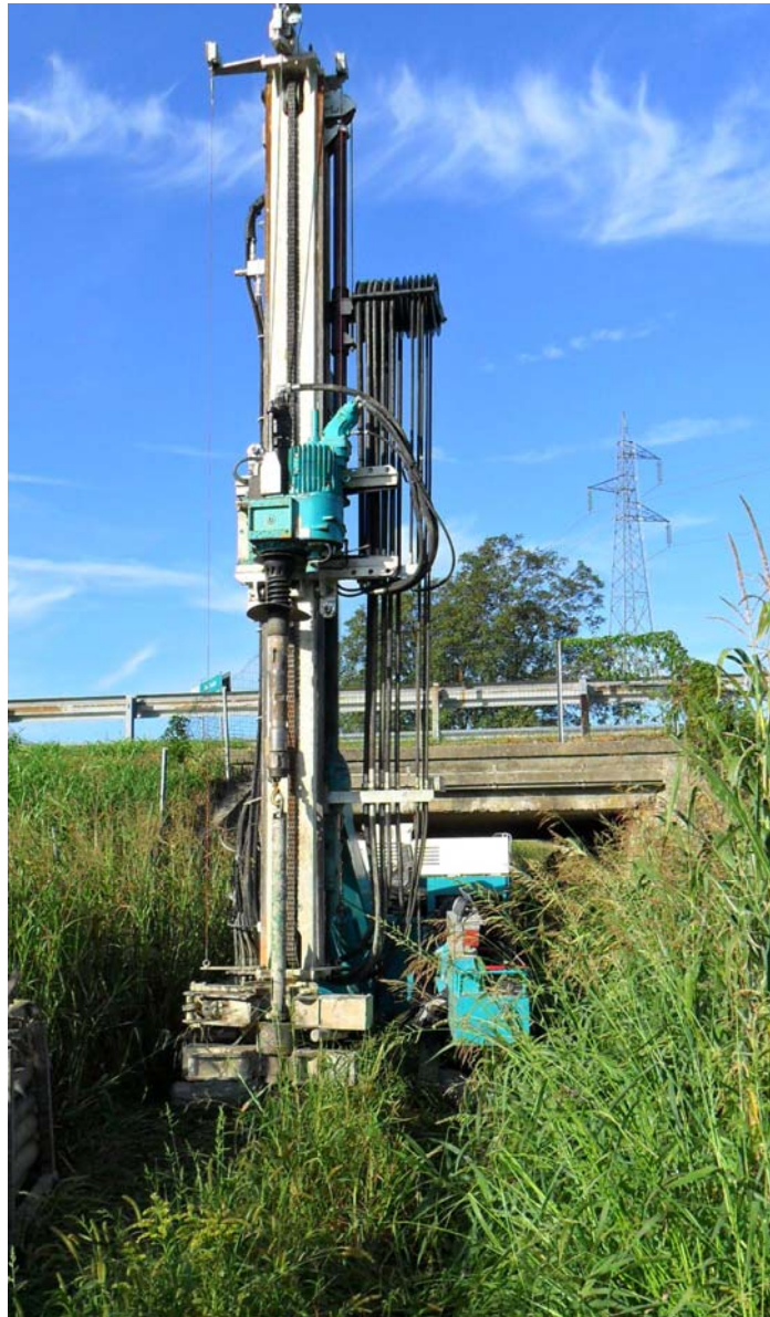
Sonda perforatrice Casagrande C6. Postazione S.4 Fasi di Carotaggio
