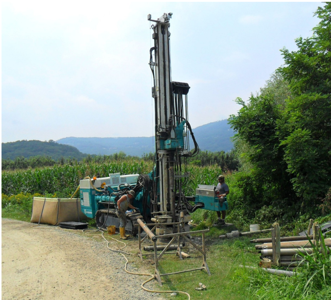
Sonda perforatrice Casagrande C6. Postazione S.2 Fasi di Sondaggio
