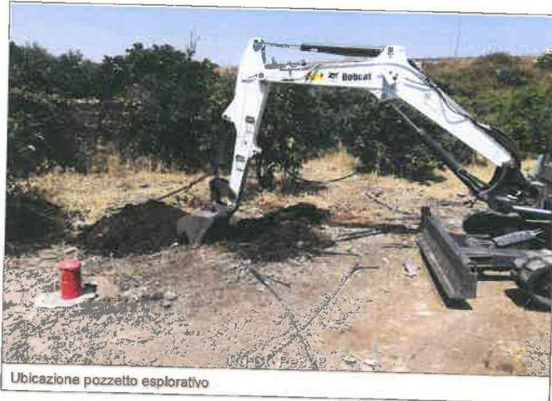
Figura 8-15 Documentazione fotografica – Ubicazione pozzetto PE328\_A (in realizzazione) e piezometro di sondaggio SE226\_AgP già realizzato.
