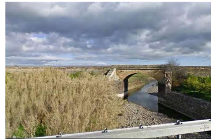
1. VISTA ATTUALE DEL TORRENTE E DEL PONTE DELLA FERROVIA STORICA LE SPONDE DEL TORRENTE CONTIGUE AL VIADOTTO IN PROGETTO SARANNO SISTEMATE SU ENTRAMBI I LATI CON GABBIONI IN PIETRA NATURALE PER UNA LUNGHEZZA DI 87 M E 95 M. LUNGO LO SVILUPPO DEL PRESIDIO IDRAULICO E NELL'AREA DI CANTIERE È PREVISTO L'INERBIMENTO E L'ALLESTIMENTO CON SPECIE ARBUSTIVE (437 PIANTE IN TOTALE).
