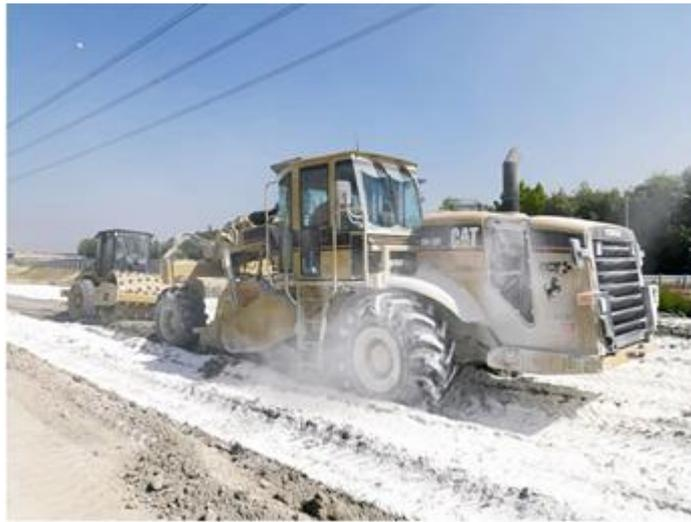
Figura 2 – Esempio operazioni di stabilizzazione a calce.
