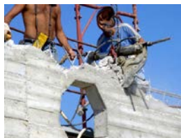
Demolizione eseguita manualmente
