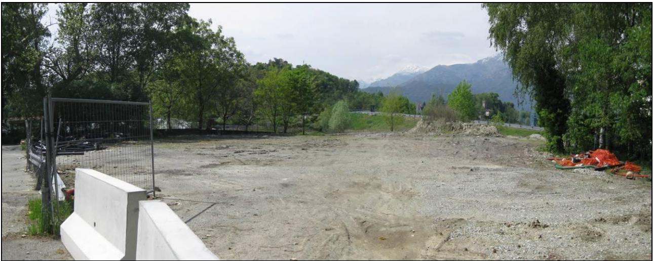
Figura 3.3/13 Vista dell'area in cui sorgerà il cantiere 2.3
