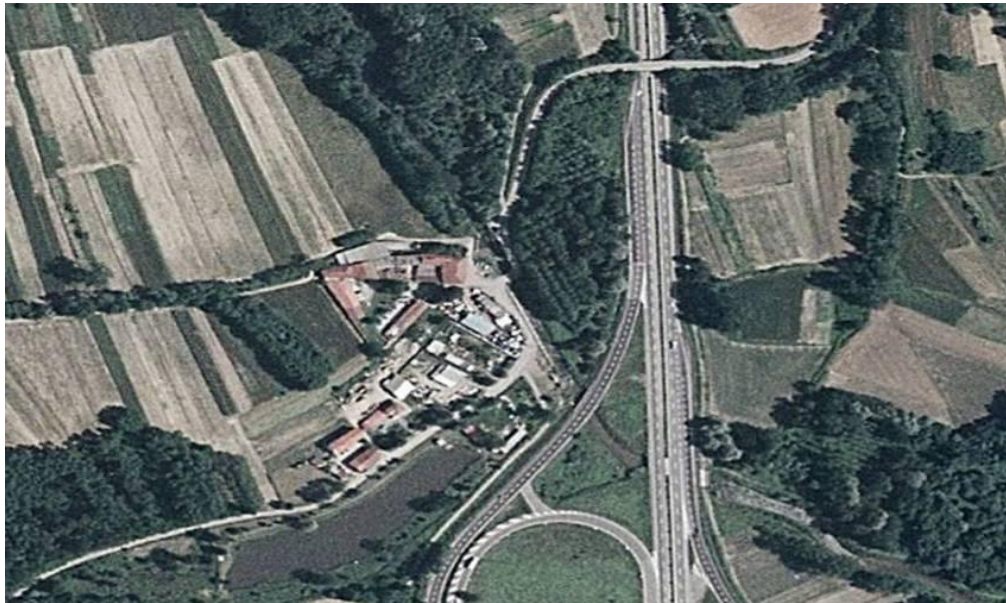
Figura 3.3/5 Vista dell'area in cui sorgerà il cantiere
