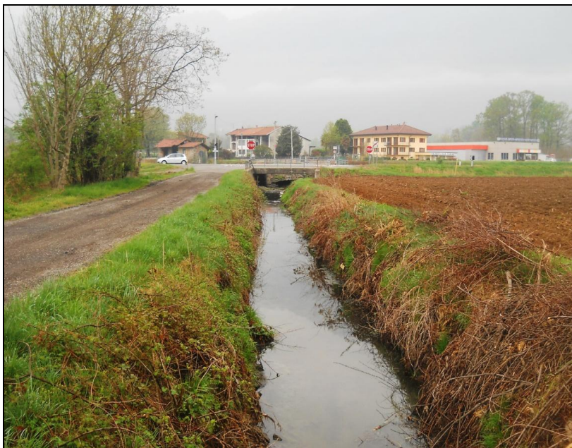
Figura 4.3/7 Il ramo di monte del rio delle Acque Rosse subito a monte dell'attraversamento della A5 – Sezione ACRI.
