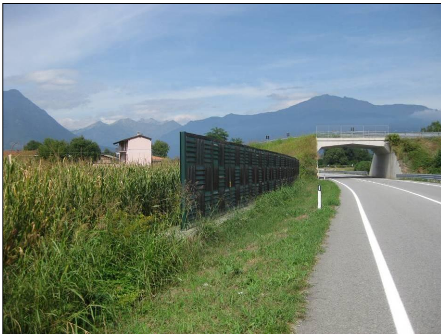
Figura 4.9/8 Macroarea di Salerano, area critica 3 – Tratto di barriera antirumore esistente lungo la Strada provinciale che affianca l'Autostrada posto a copertura del ricettore S10
