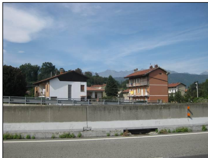
Figura 4.7/13 Insediamento residenziali al margine di Salerano
