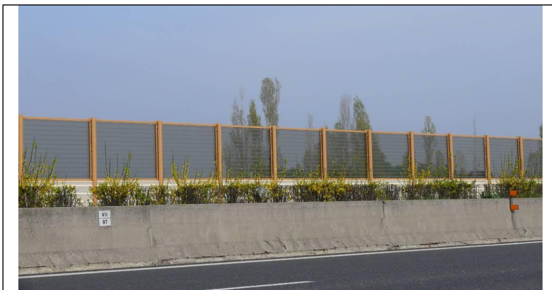
Figura 4.9/36 Esempio di barriera con pannelli trasparenti con trattamento anticollisione dell’avifauna mediante strisce satinare ottenute per abrasione
