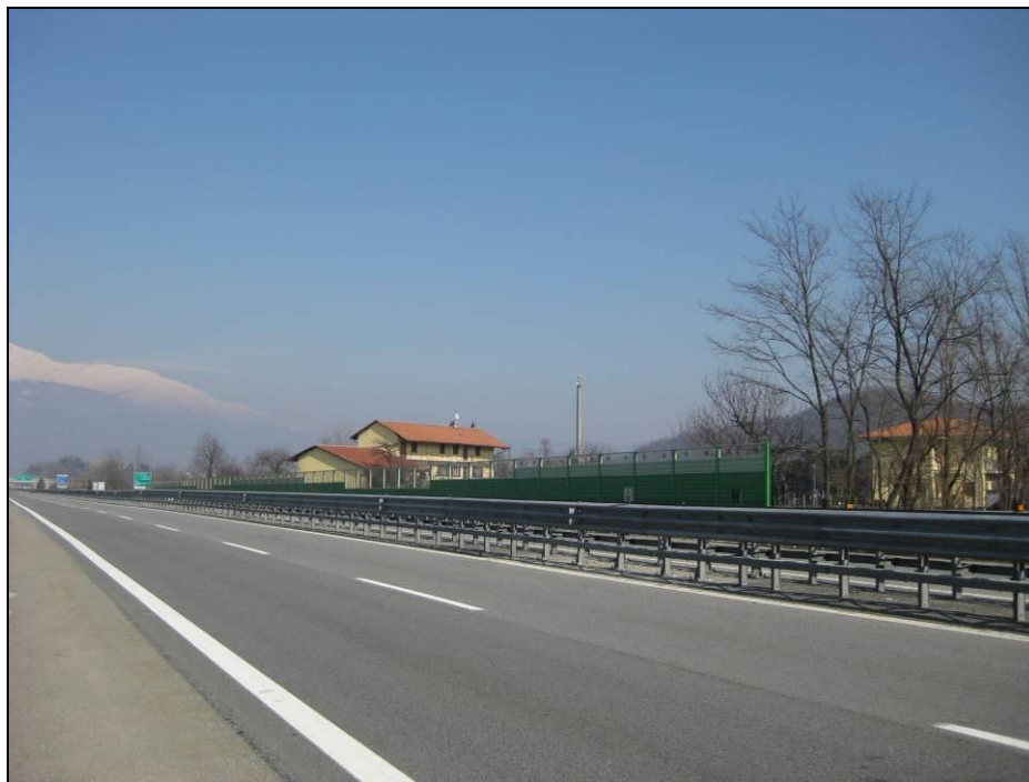
Figura 4.9/6 Macroarea di Pavone, area critica 1 – Barriera antirumore realizzata
