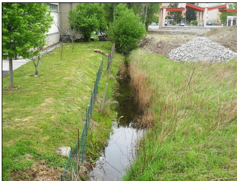
Figura 4.4/1 Ristagni d'acqua nei pressi della vecchia uscita autostradale dismessa di Ivrea (sullo sfondo).
