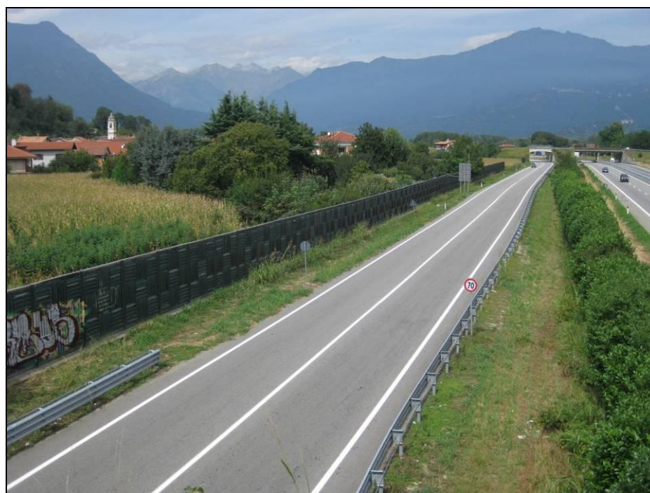
Figura 4.9/7 Macroarea di Saleranno, area critica 3 – Barriera antirumore realizzata lungo la Strada provinciale che affianca l'autostrada, integrata da una barriera verde lungo quest'ultima. Sono presenti due tratti di barriera antirumore, uno a copertura dei ricettori S8 ed S9, come di seguito identificati, ed uno, più breve, in prossimità del sovrappasso nello sfondo della foto, a copertura del centro S10
