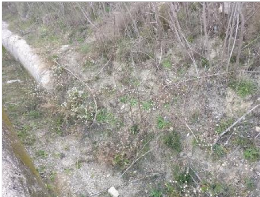
Foto 7.17 - Frana L3_2 situata tra le pk. 5+250-5+310 – particolare del tratto in cui è stata danneggiata la canaletta.
