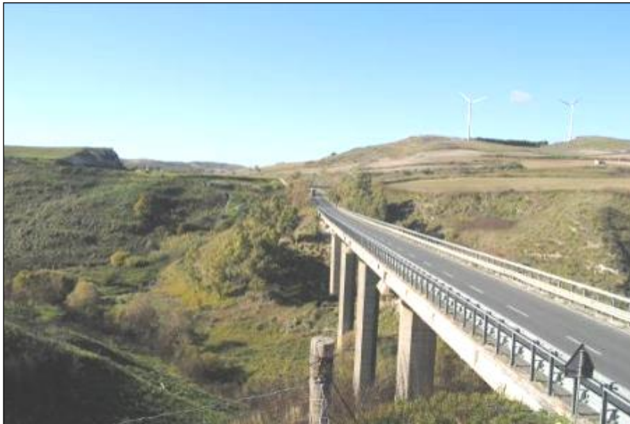
Foto 7.1 – Panoramica della valle del Torrente Fiumicello in corrispondenza dell'attraversamento del Viadotto Piano delle Rose; sullo sfondo la pianeggiante area di cava abbandonata.
