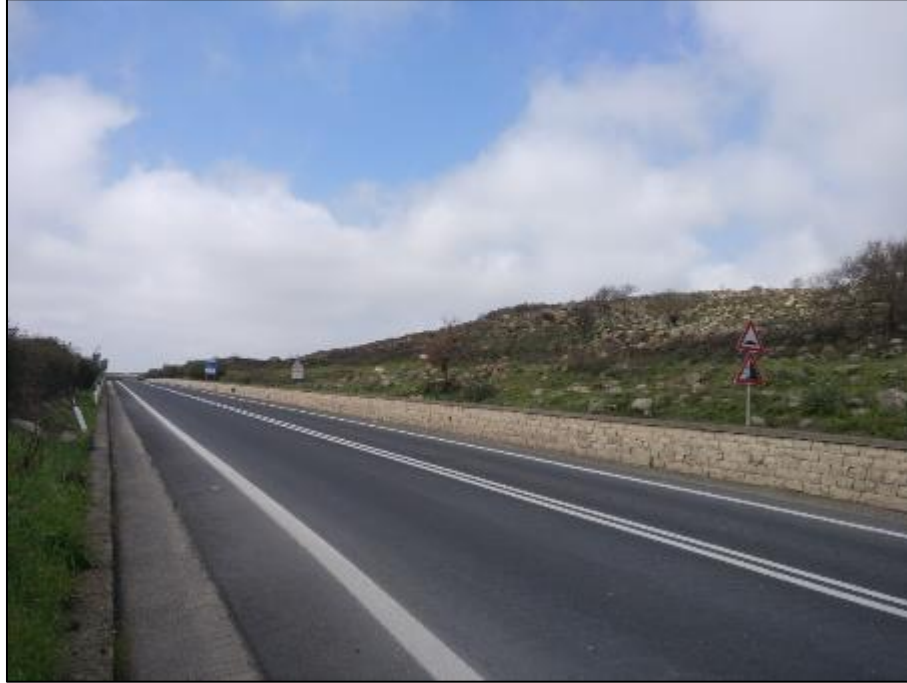
Foto 7.23 – Tratta pk. 9+000-9.500 in cui la sede stradale viene ampliata verso monte.
