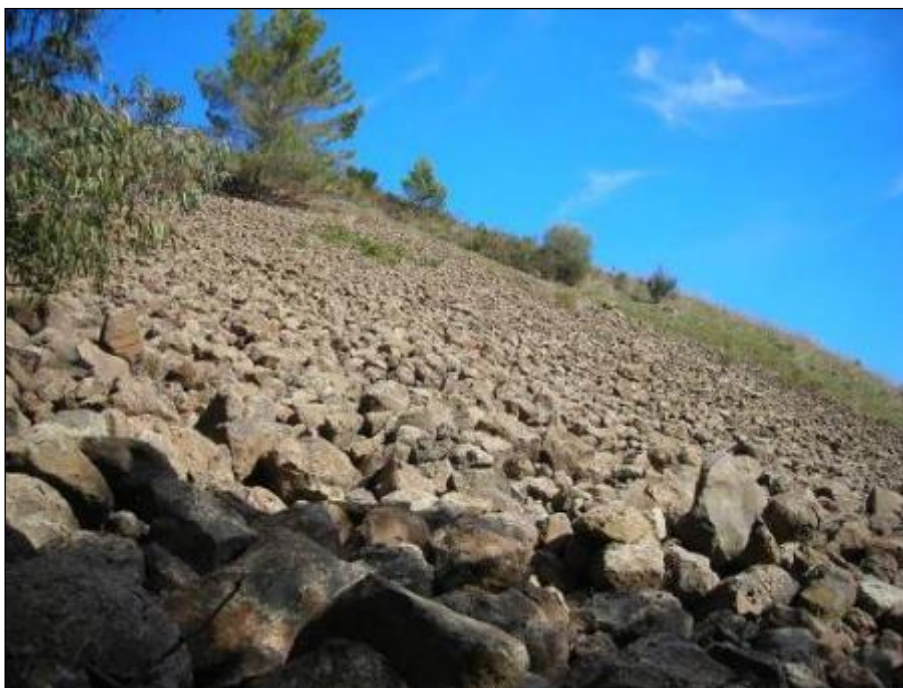
Foto 6.1 - Panoramica dell'accumulo di materiale di risulta dello scavo della trincea tra le pk. 11+500 e 11+600
