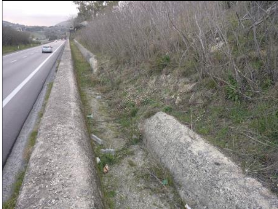
Foto 7.17 - Frana L3_2 situata tra le pk. 5+250-5+310 – particolare del tratto in cui è stata danneggiata la canaletta.
