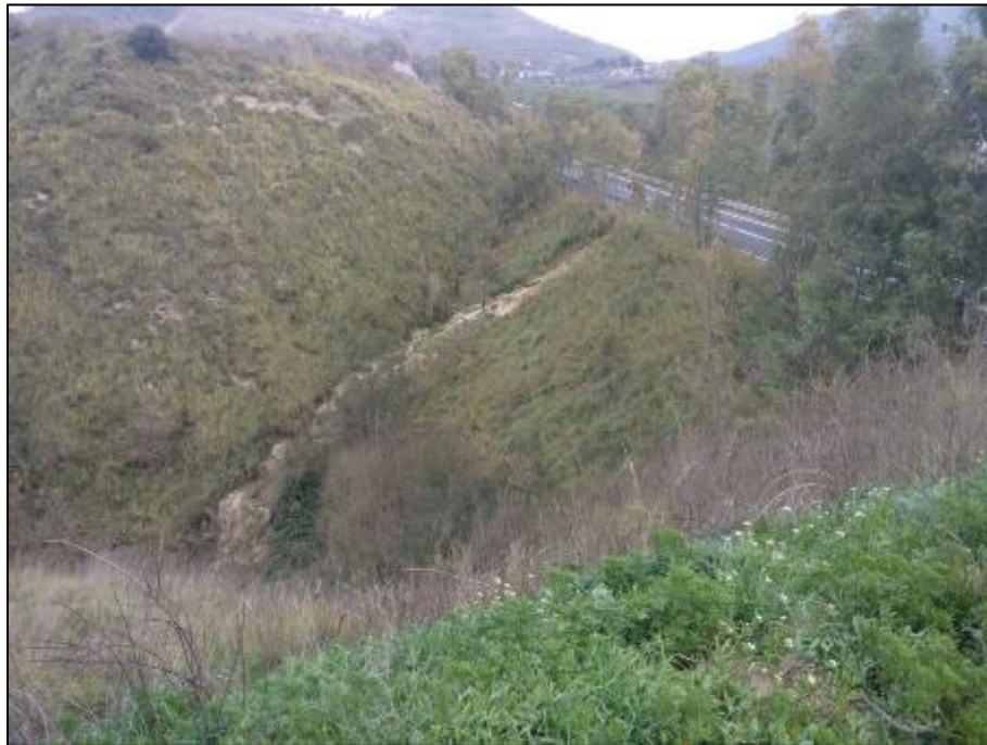
Foto 7.12 – Forme di erosione e dissesti a monte della SS 514 in sinistra T. Fiumicello.
