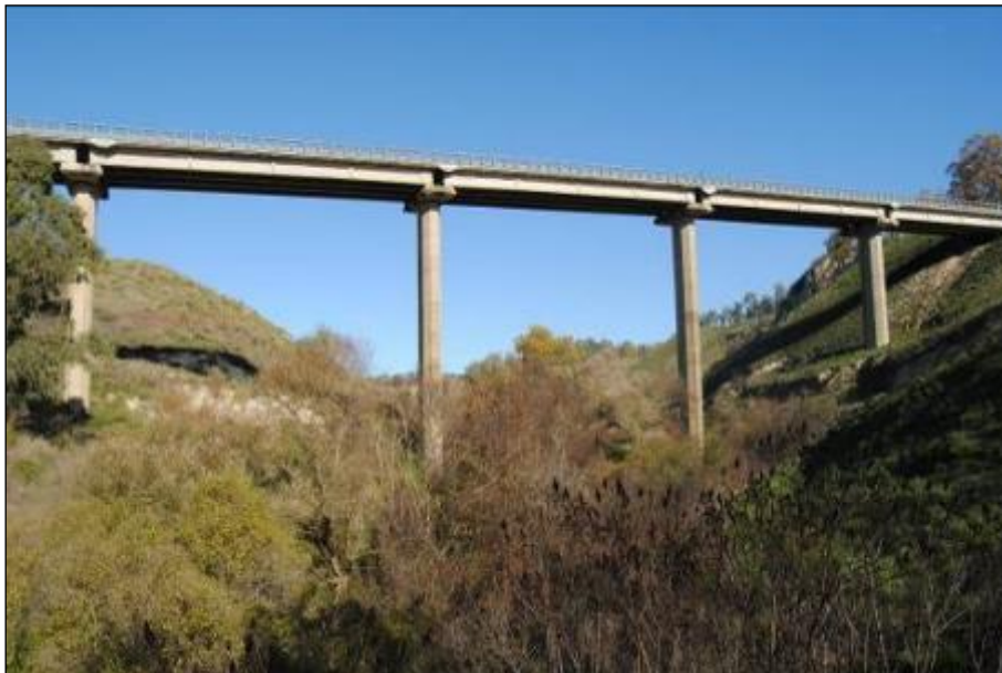
Foto 7.3 – Vista da valle dell'esistente viadotto che attraversa l'incisione del T. Fiumicello; l'asimmetria dei due versanti è attribuibile alla giacitura della stratificazione del substrato miocenico a franapoggio sulla sinistra della foto, e a reggipoggio sulla destra.
