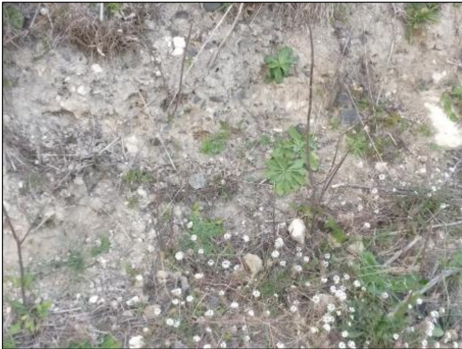
Foto 6.3 - Particolare di una fascia di detrito in affioramento osservata in un taglio stradale presso la pk. 15+400.
