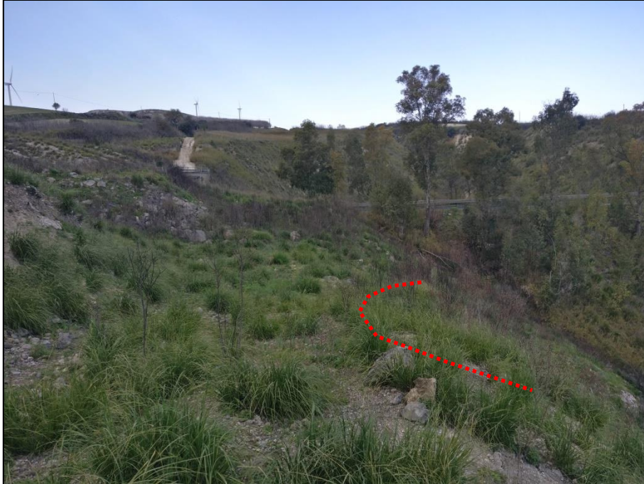
Foto 2-3 – Zono di testata della frana situata al limite dell'area di cava abbandonata.
