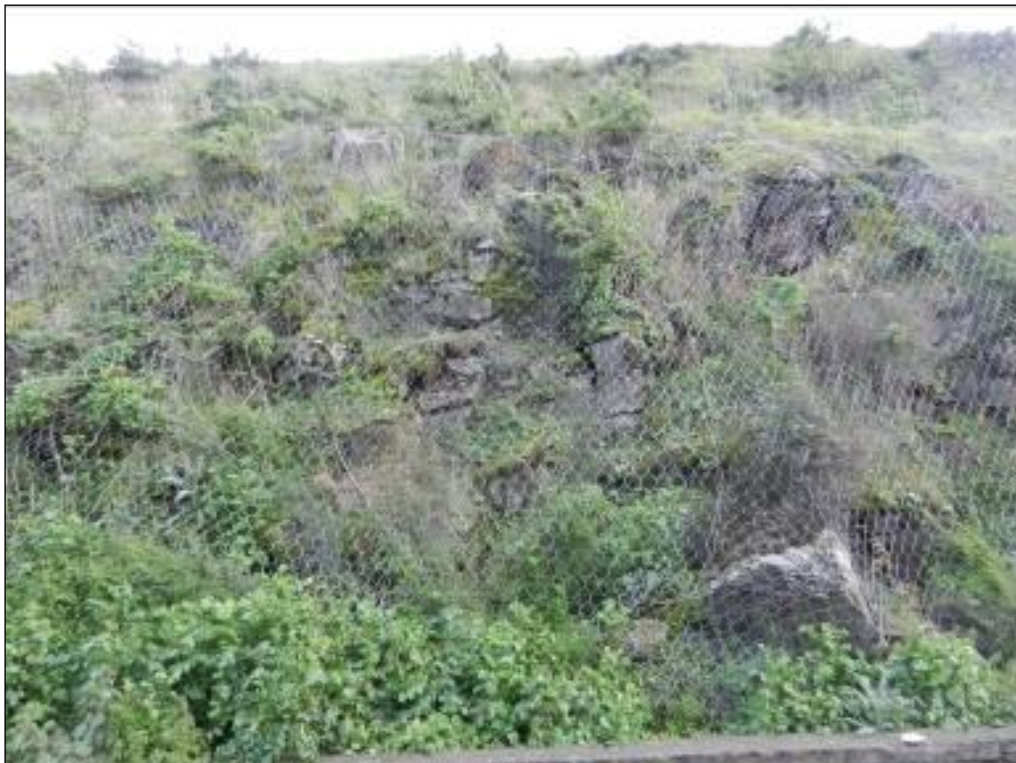
Stazione geomeccanica SG46
