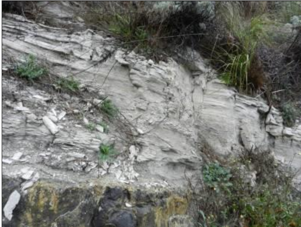
Stazione geomeccanica SG54
