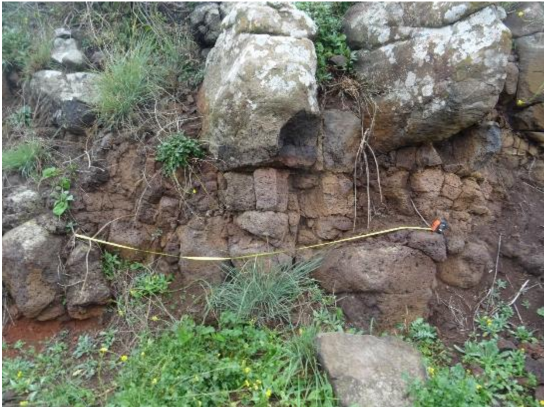
Stazione geomeccanica SG59
