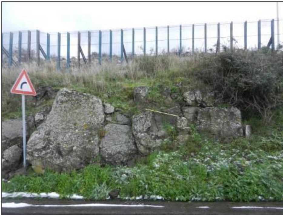
Stazione geomeccanica SG15
