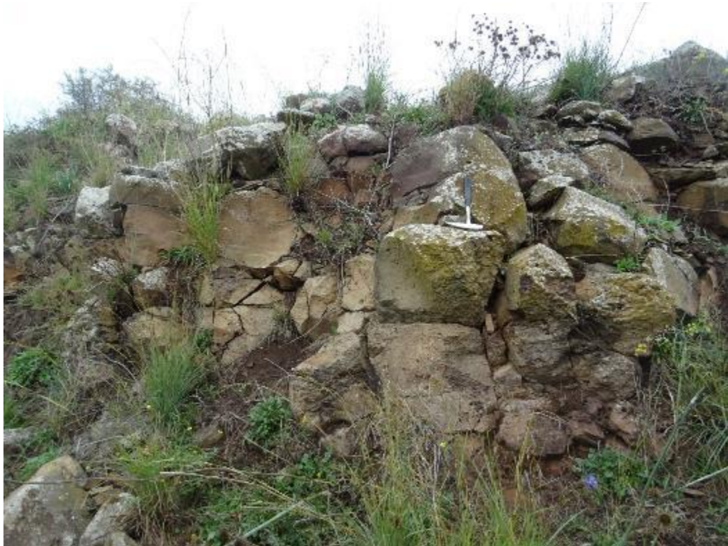
Stazione geomeccanica SG60
