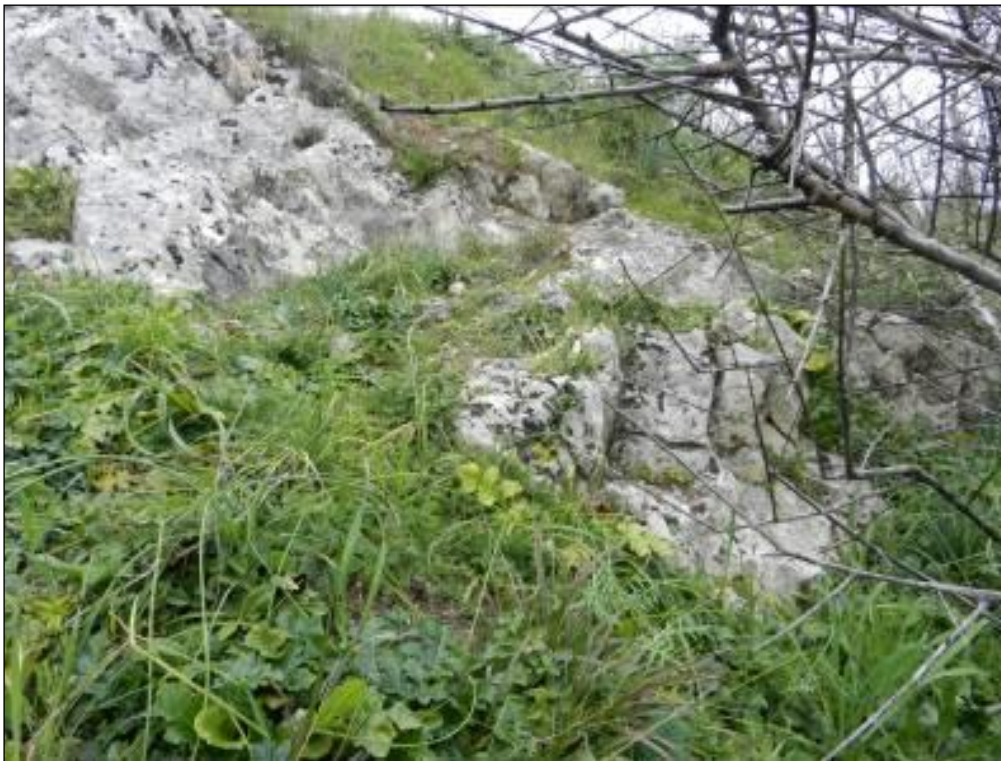
Stazione geomeccanica SG50
