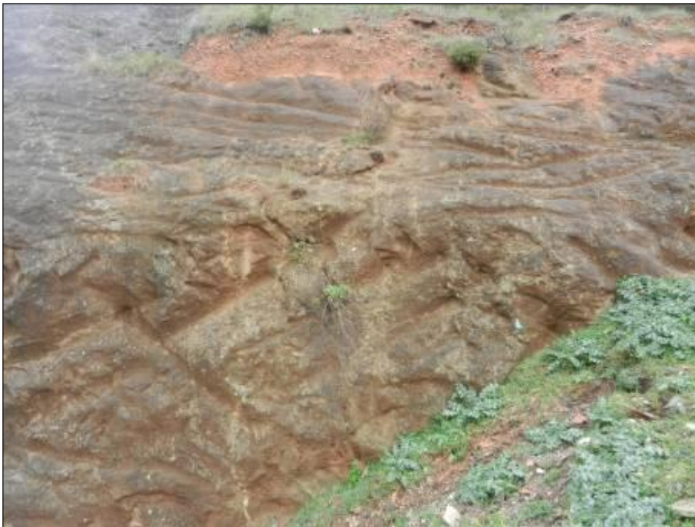
Stazione geomeccanica SG30
