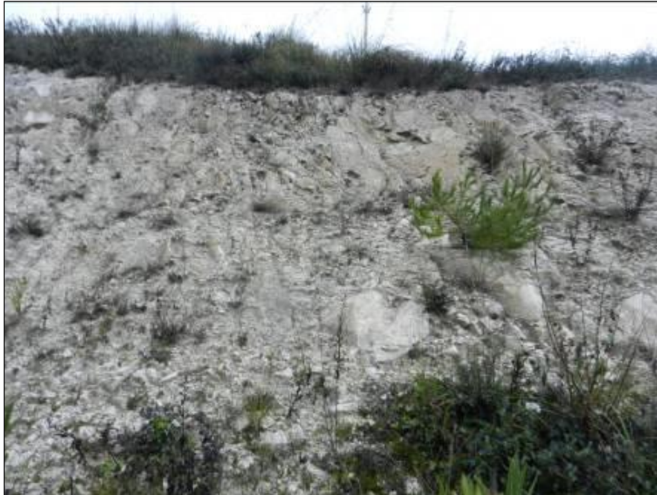
Stazione geomeccanica SG34
