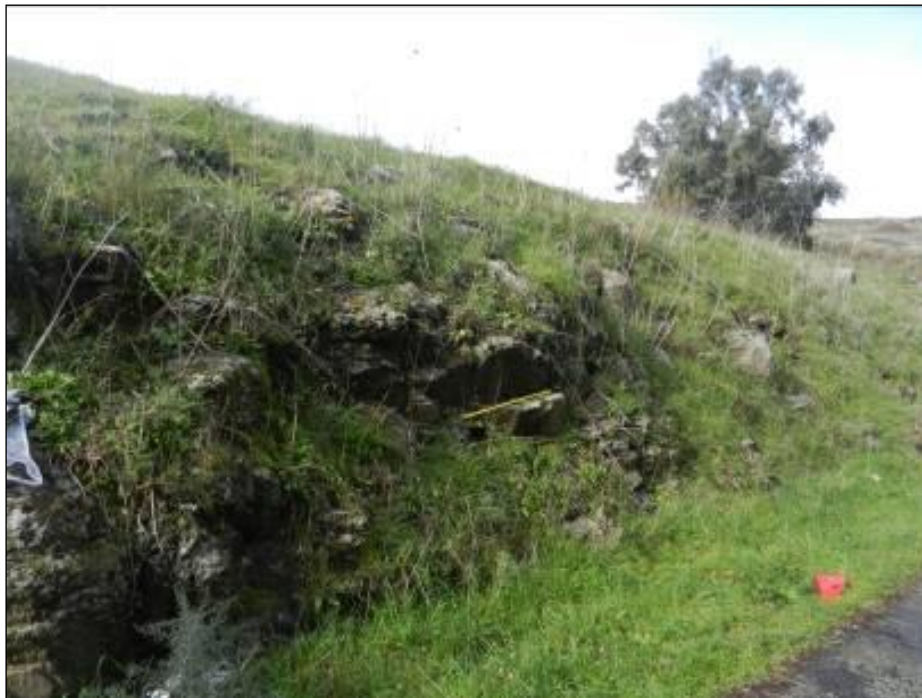
Stazione geomeccanica SG16
