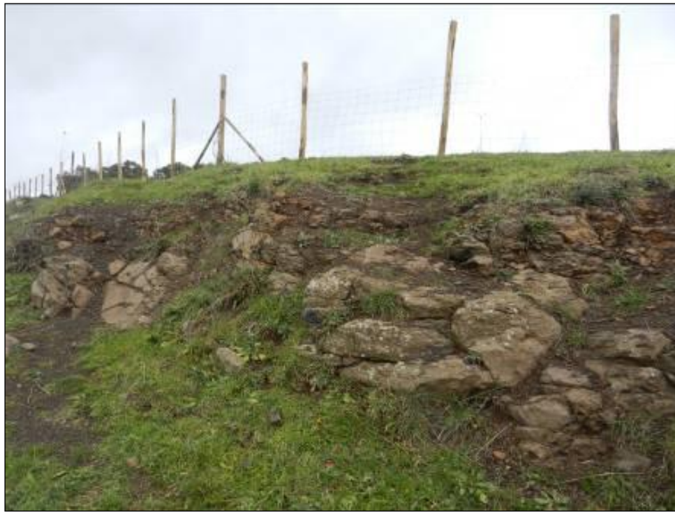
Stazione geomeccanica SG19
