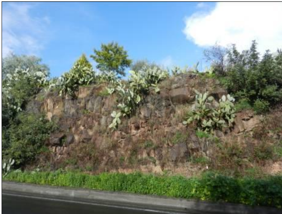
Stazione geomeccanica SG13
