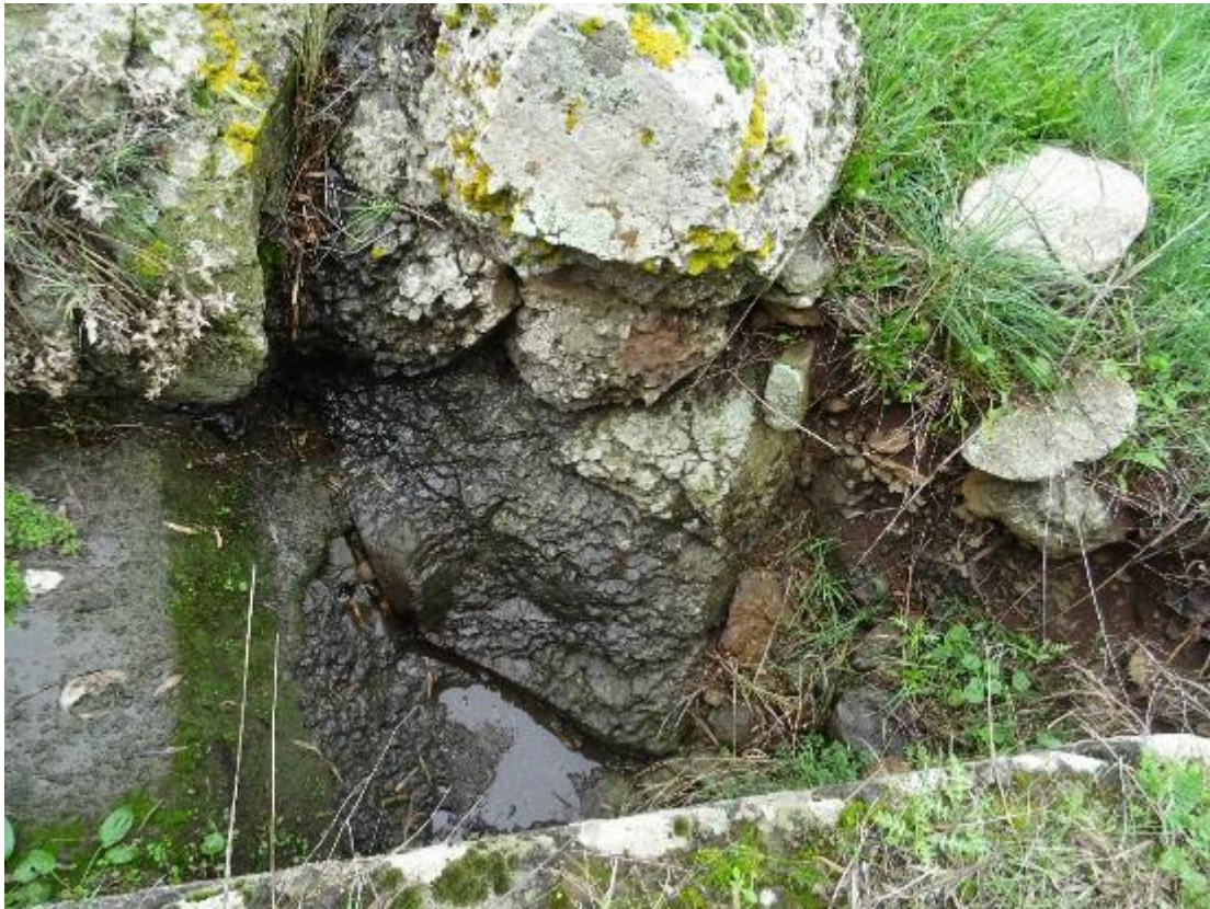
Stazione geomeccanica SG61
