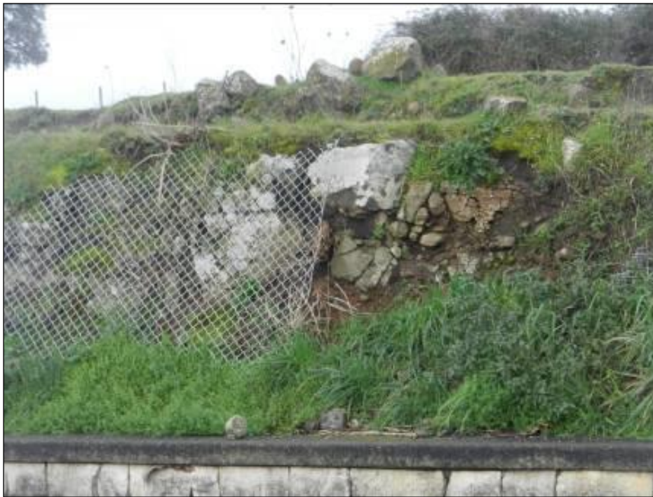
Stazione geomeccanica SG20
