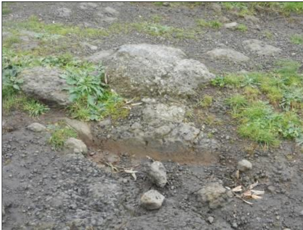
Stazione geomeccanica SG18
