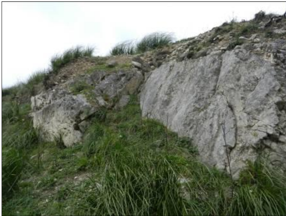
Stazione geomeccanica SG51
