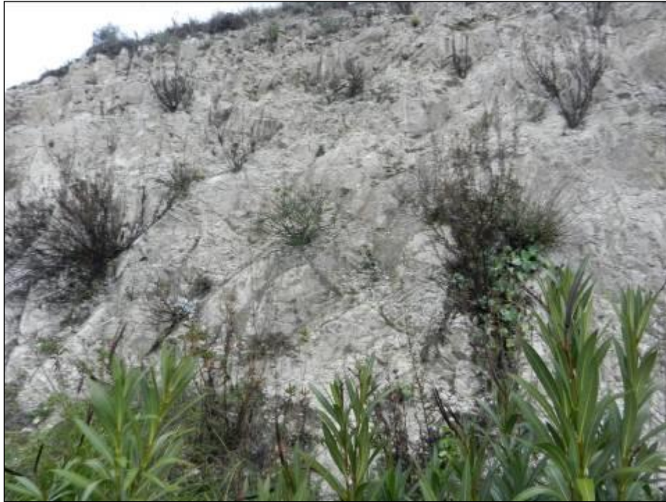
Stazione geomeccanica SG33
