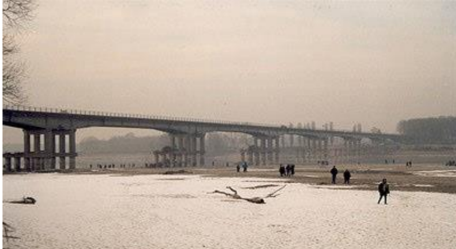
Figura 6.4: Esempio di erosione generalizzata sul fiume Po
