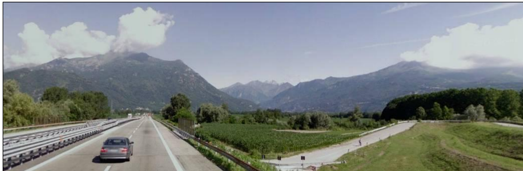
3.1 Tratto iniziale del lotto 3, immediatamente a valle del viadotto Fiorano
