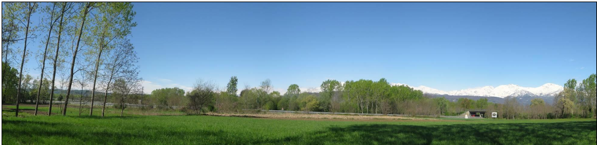
1.10 Vista laterale (lato est) del tratto autostradale di localizzazione del viadotto Cartiera – L'interferenza in fase di costruzione con la vegetazione boschiva prossima al rio Ribes richiede estesi interventi di ripristino da attuare al termine dei lavori.
