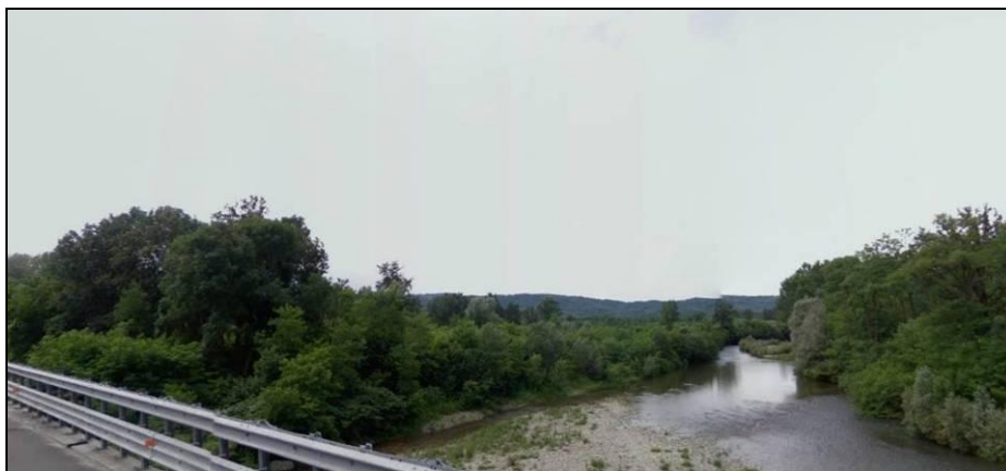
1.3 – Viadotto Chiusella - Continuità boschiva lungo il torrente - Settore a monte del viadotto
