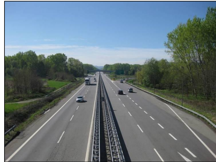
1.9 - Vista prospettica del tratto autostradale di localizzazione del viadotto Cartiera
