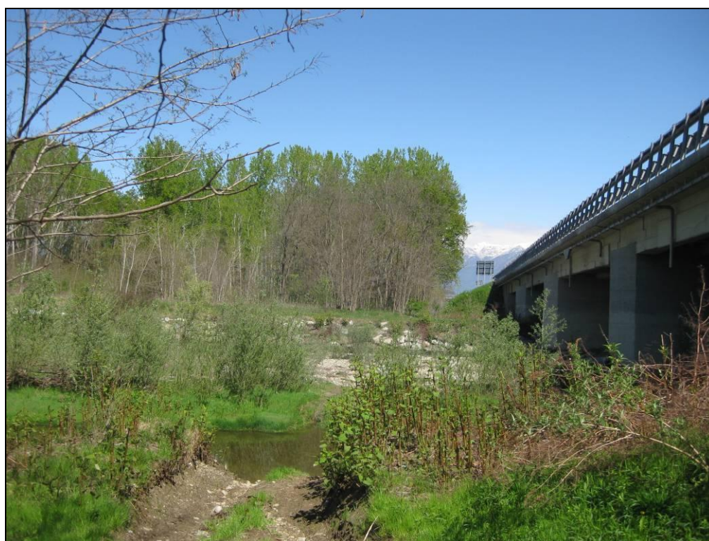
1.7 - Viadotto Chiusella – Zone di margine, lato monte, utilizzate per la cantierizzazione del viadotto
