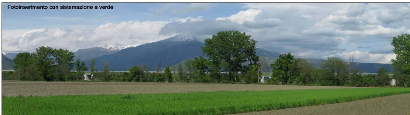
FOTOINSERIMENTO 8 - VISTA DELL'AUTOSTRADA DALLA S.P. 69, CON LA VEGETAZIONE DELLA ROGGIA ROSSA CHE COSTEGGIA L'AUTOSTRADA PER UN LUNGO TRATTO
