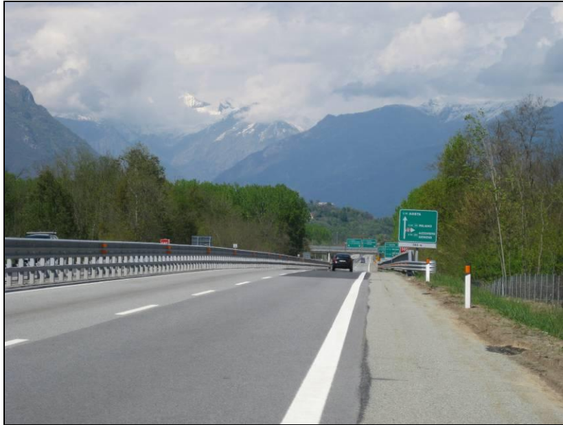
1.1 - Inizio intervento – Vista in direzione nord e verso lo svincolo di interconnessione
