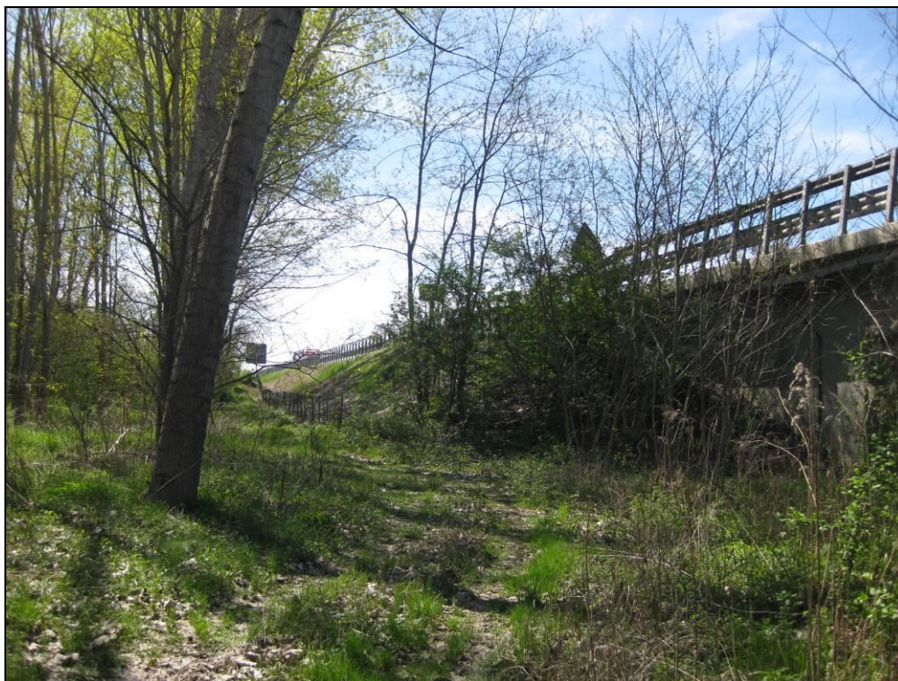
1.6 - Viadotto Chiusella – Zone di margine, lato valle, utilizzate per la cantierizzazione del viadotto
