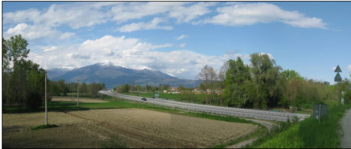
1.11 Tratto in rilevato di avvicinamento al viadotto Cartiera, lato Ivrea, vista da ovest.
