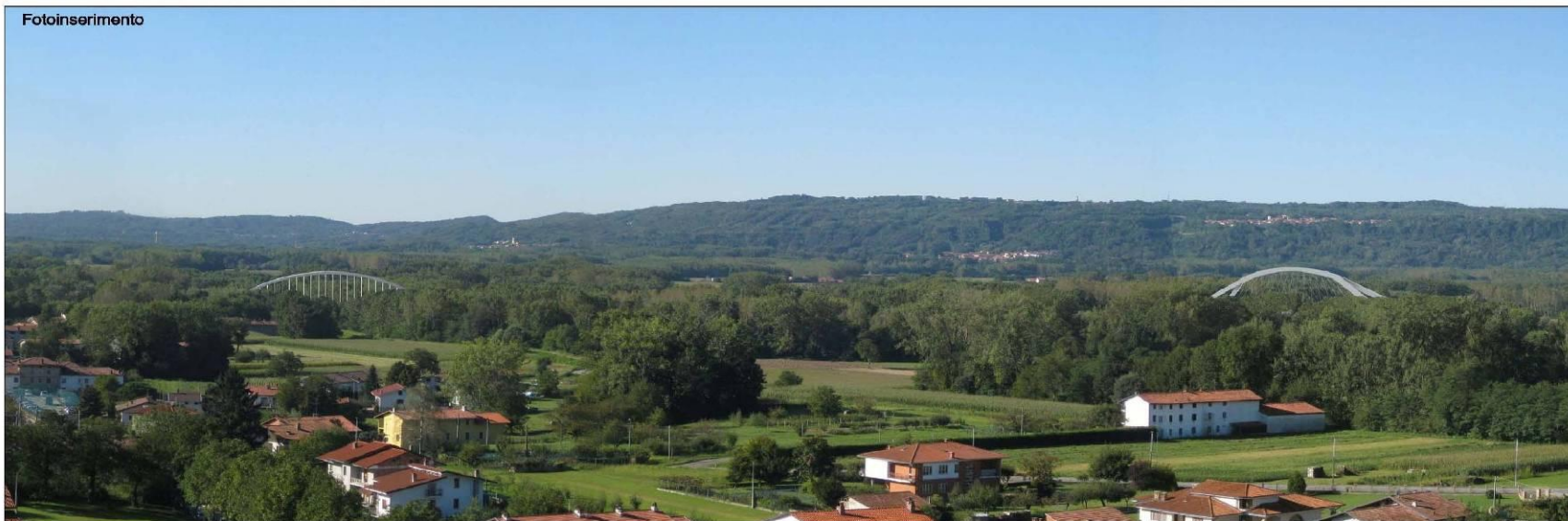
FOTOINSERIMENTO 4 - VISTA DEL NODO DI INTERCONNESSIONE CON I VIADOTTI MARCHETTI E CARTIERA DAL CASTELLO DI PAVONE
