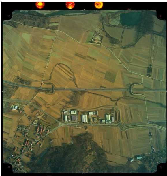
Fotogramma 4316 – km 43+084/km 43+819 (sovrappasso S.C. 67 Baio Dora-Fiorano e sovrappasso S.C. dell'Isola), veduta orientata in direzione E
