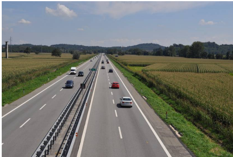
Foto 25 – km 43+084 , dal sovrappasso S.C. 67 Baio Dora-Fiorano, veduta del km 43+000 e, sullo sfondo, della zona Viadotto Fiorano, da NO
