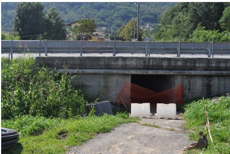
Foto 30 – km 45+343, ponte, lato E, da E
