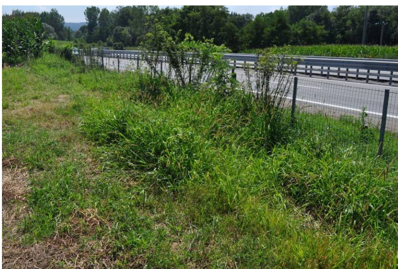
Foto 8 – km 38+100 , lato E, da N (zona cimitero Pavone)
