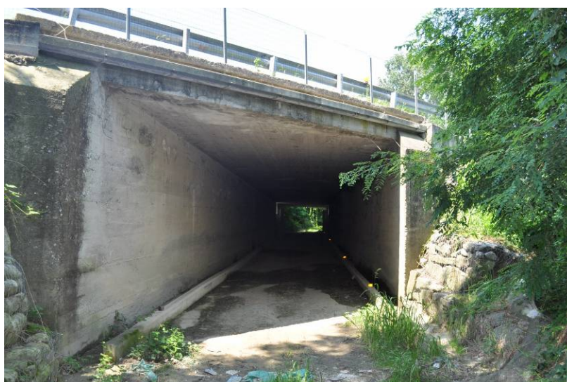
Foto 14 – km 38+767 , sottopasso Strada Vicinale (in Pavone), lato E, da E
