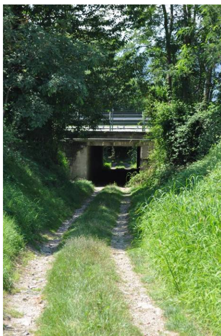
Foto 9 – km 38+133 , sottopasso Strada Rio Ribes, lato E, da E
