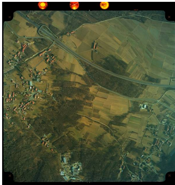
Fotogramma 4318 – km 44+077/km 45+650 (termine Lotto 3), veduta orientata in direzione N-E
