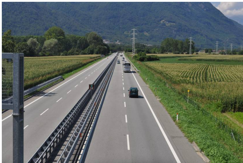
Foto 26 – km 43+084 , dal sovrappasso S.C. 67 Baio Dora-Fiorano, veduta lato N (sullo sfondo sovrappasso dell'Isola, km 43+819), da SE
