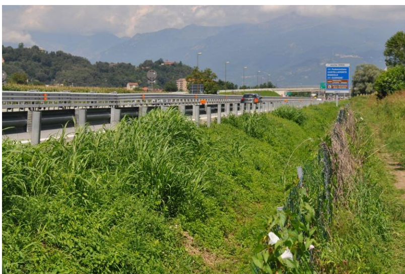
Foto 17 – km 38+767 , lato E, da SE (sullo sfondo svincolo di Ivrea)
