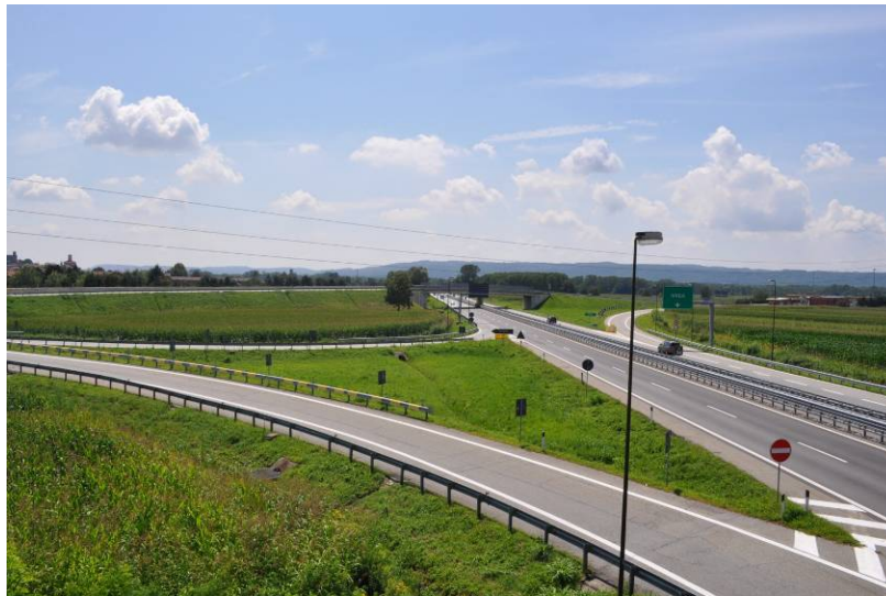
Foto 19 – km 39+500 , vista dello svincolo di Ivrea dal sovrappasso S.P. 565 Pedemontana, lato E, da NE
