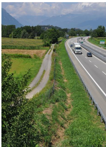
Foto 6 – km 37+793 (zona N Viadotto Cartiera), dal sovrappasso Strada Vicinale di Sanguignolo, lato NO, da S
