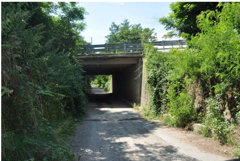
Foto 11 – km 38+458 , sottopasso S.C. di Ribes o del Cimitero (Pavone-Colleretto), lato E, da E
