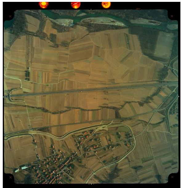
Fotogramma 4314 – km 41+400/km 43+084 (Viadotto Fiorano e sovrappasso S.C. 67 Baio Dora-Fiorano), veduta orientata in direzione E
