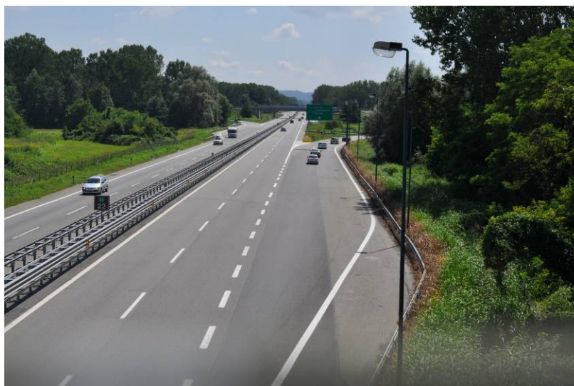
Foto 4 – km 37+793 (zona N Viadotto Cartiera), dal sovrappasso Strada Vicinale di Sanguignolo, lato SO, da N (sullo sfondo interscambio A4/A5)
