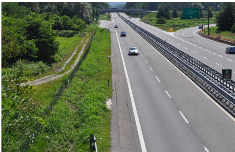
Foto 3 – km 37+793 (zona N Viadotto Cartiera), dal sovrappasso Strada Vicinale di Sanguignolo, lato SE, da N (sullo sfondo interscambio A4/A5)
