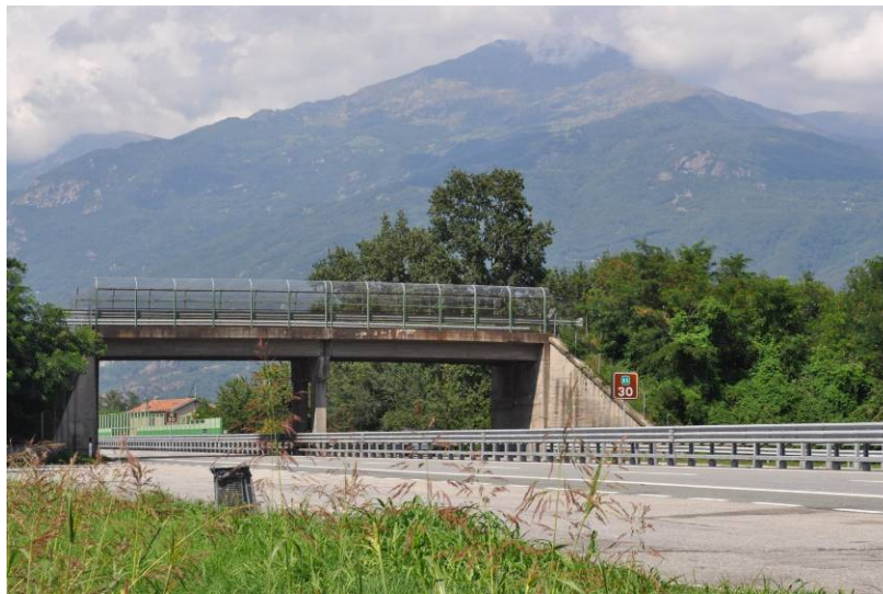
Foto 32 – km 45+500 , ponte al limite N del Lotto 3, da SO
