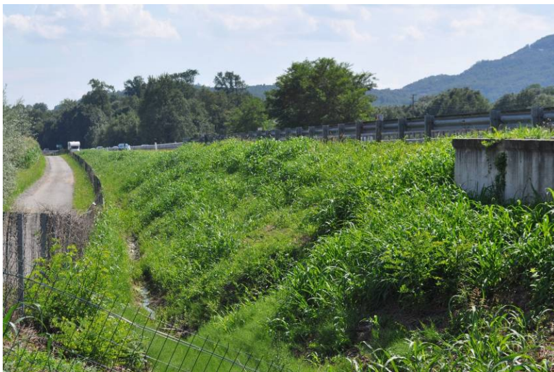
Foto 29 – km 45+343, lato E, da NE
