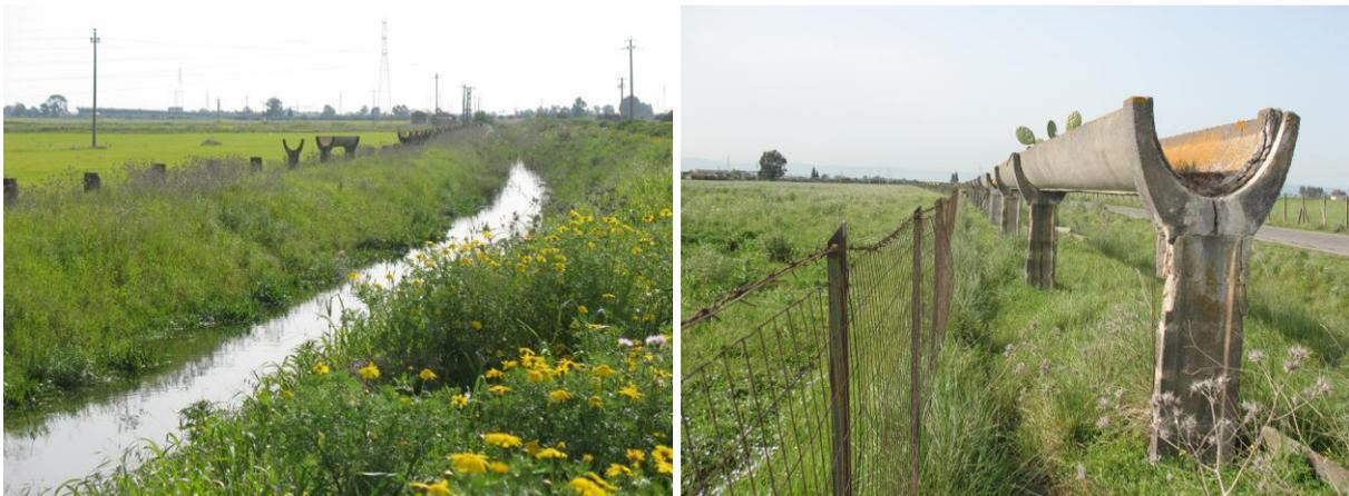
Figura I.8 - Gli elementi della rete irrigua in essere (sx) e i canali sopraelevati della bonifica ormai in disuso (dx)
