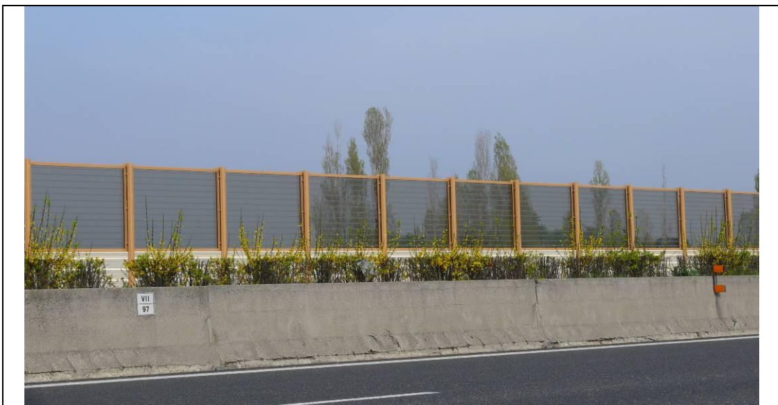
Figura 4.8/2: Esempio di barriera con pannelli trasparenti con trattamento anticollisione dell'avifauna mediante strisce satinare ottenute per abrasione
