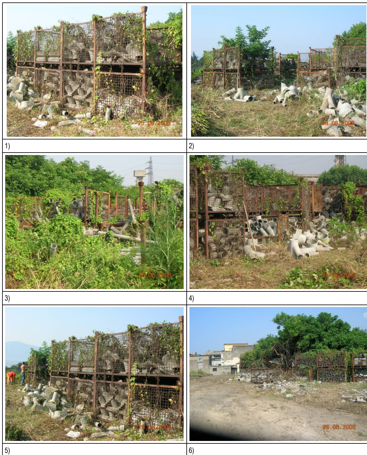
Figura 4.3.11 – Lavorati in fibrocemento abbandonati alle intemperie
