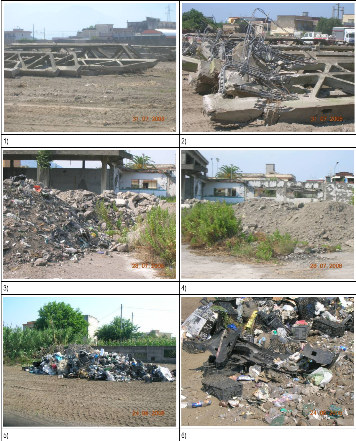
Figura 4.3.12 – Materiali edili e rifiuti vari accumulati al suolo
