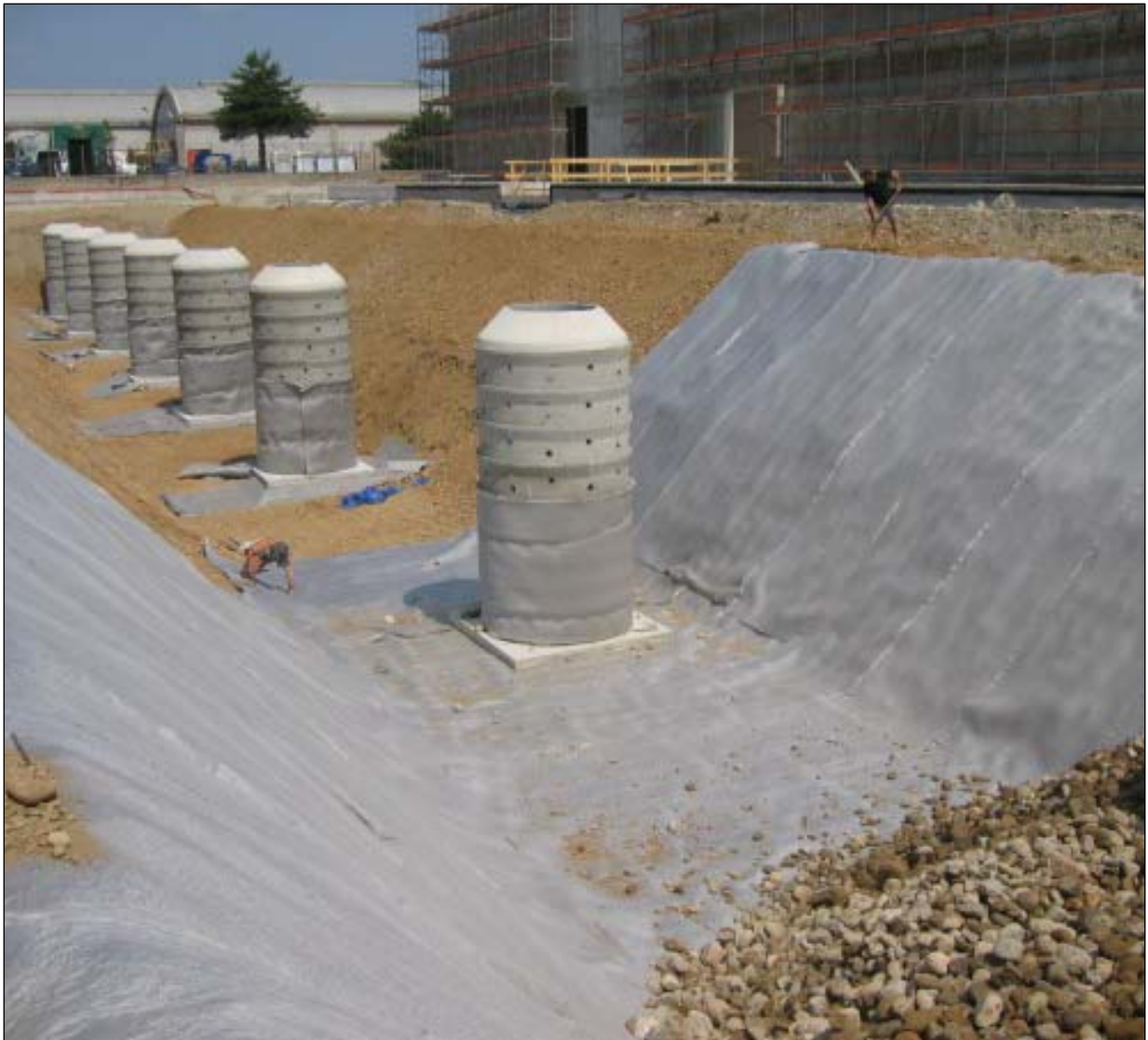
Figura 3.9.14 –Posa in opera pozzi disperdenti
