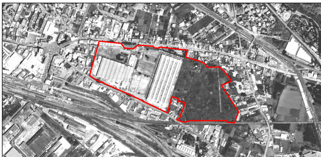
Figura 2.2.2 – Stato di fatto : foto aerea - (stralcio tav 5.5 del Contratto d'area Torrese-Stabiese)
