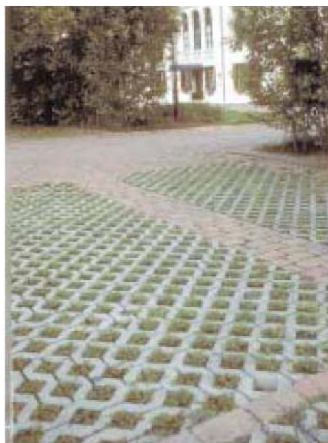
Figura 2.5.5 – stratigrafia degli stalli in erbablok ed esempio di sistemazione
