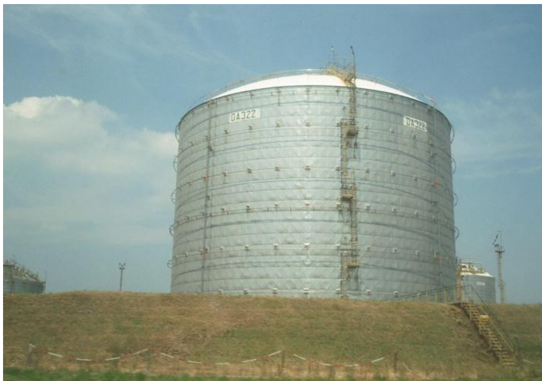
Figura 3-3 Il Serbatoio DA322 del Parco Serbatoi Ovest
