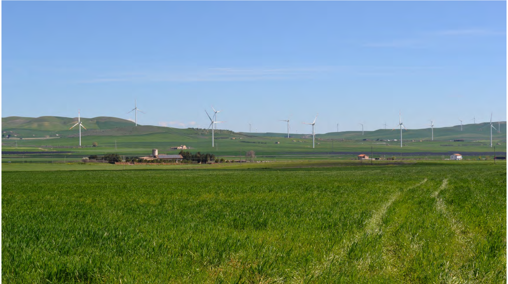
Fotoinserimento da Masseria Bascianelli (post-operam)
