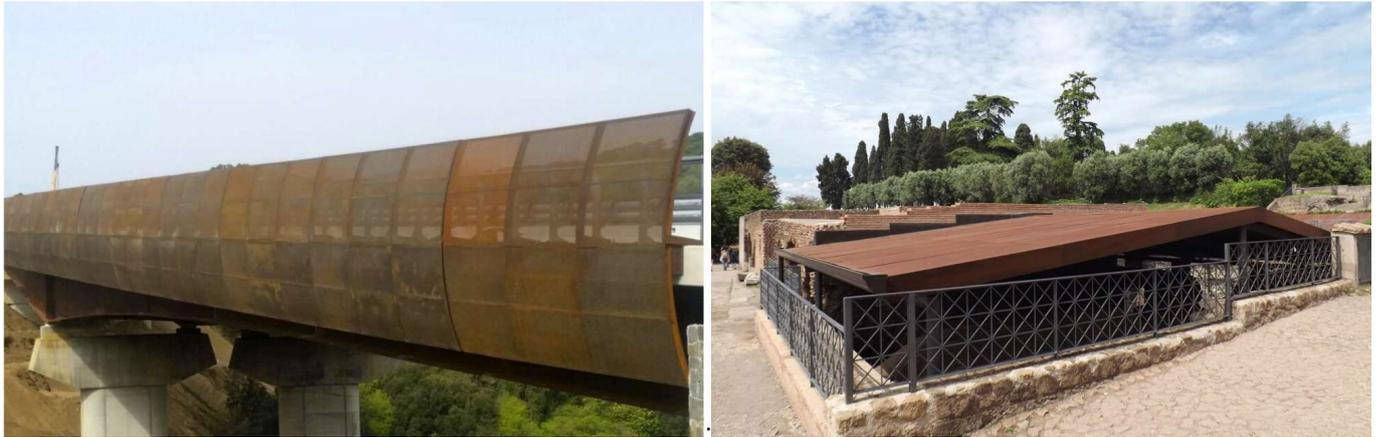
**Figura 41 Esempi di utilizzo del corten su un viadotto e in un'area archeologica dell'Italia centrale.**
