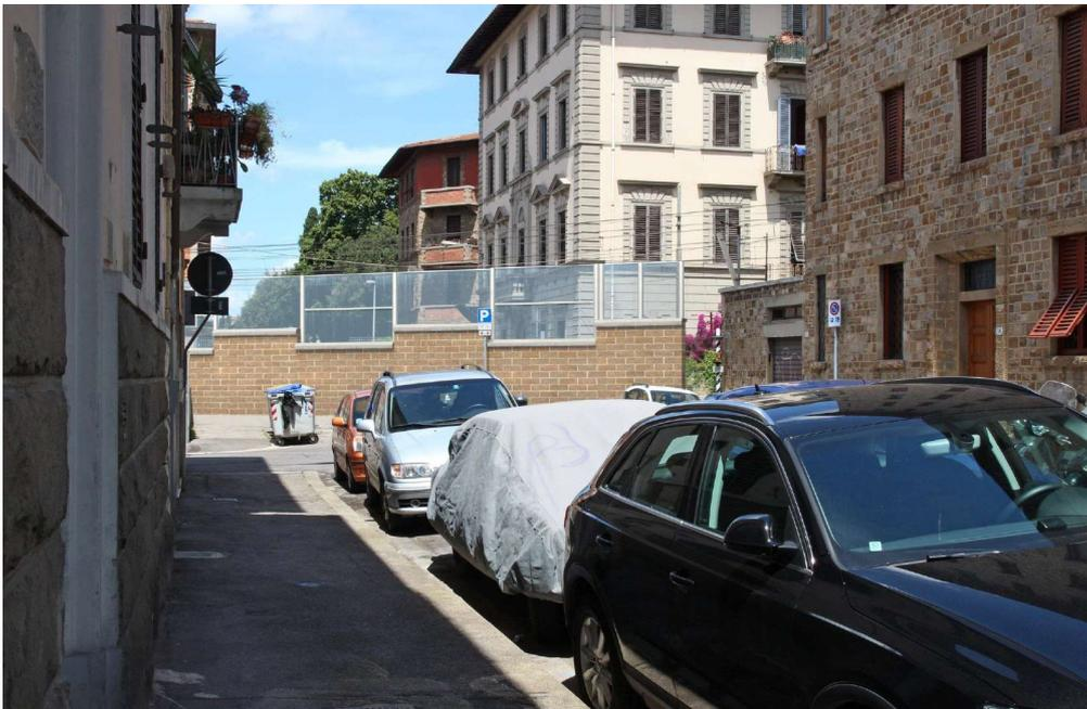
**Figura 44 Esempio di barriera antirumore mista con pannelli trasparenti e pareti opache rivestite in mattoni per l'inserimento paesaggistico dell'intervento.**
