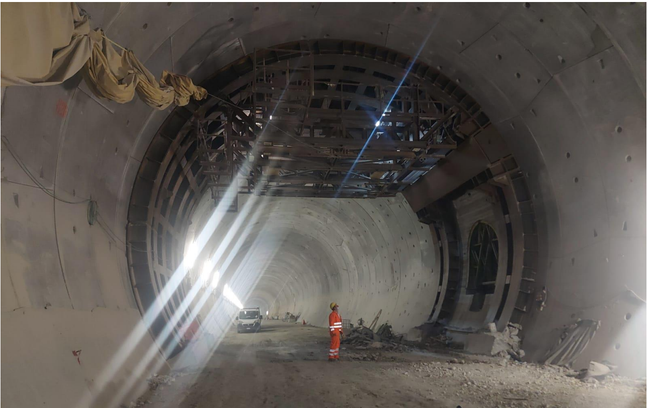
Figura 3 Immagine fotografica struttura di sostegno
