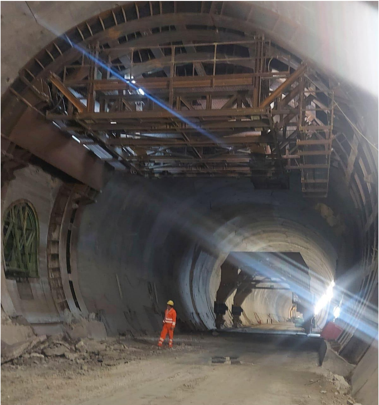
Figura 4 Immagine fotografica struttura di sostegno
