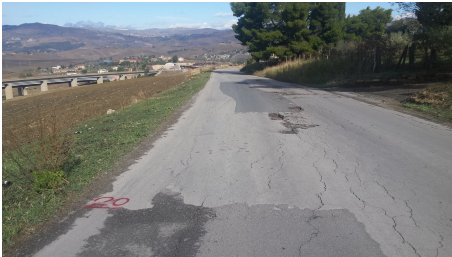
Figura 8 – Dissesto gravitativo in corrispondenza dell’innesto con la Via Mangilasagne
