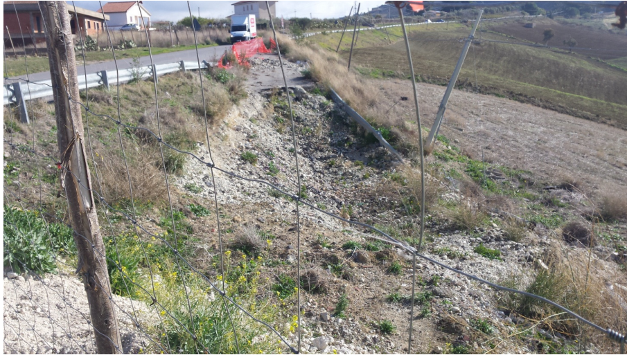
Figura 8 – Dissesto gravitativo in corrispondenza dell’innesto con la Via Mangilasagne
