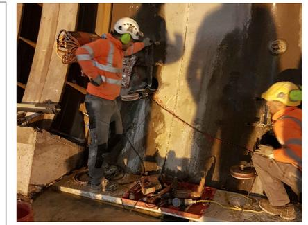
Foto 1 - Insetimento nelle predisposizioni Ø 200 delle pulegge a tuffo con volani di rinvio e collocazione del filo diamantato nell'impianto dei volani.
