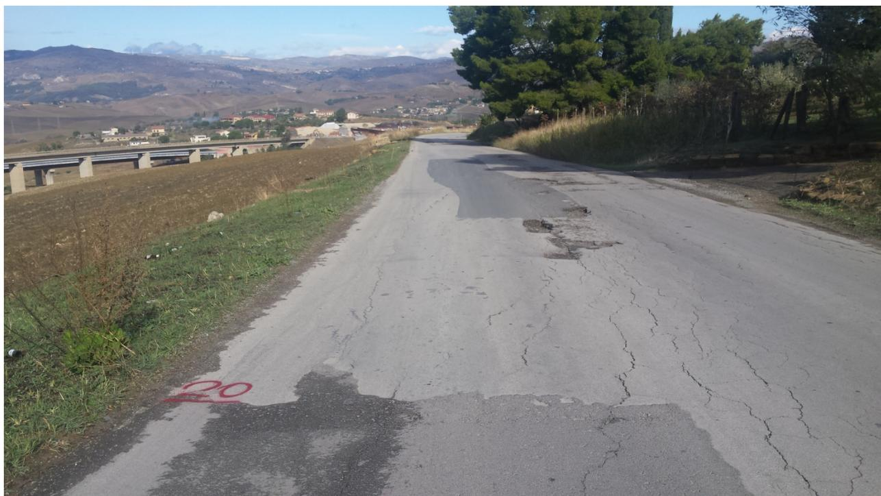
*Figura 6 - Deformazioni del piano viario*
