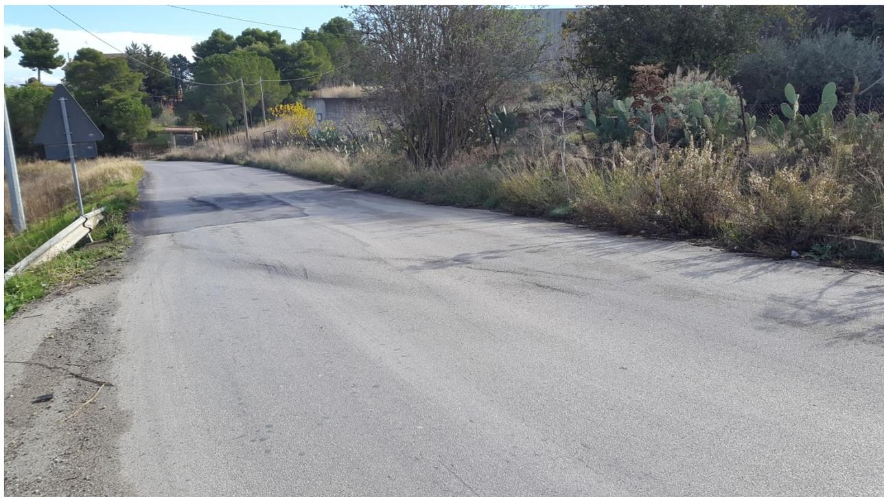
*Figura 11- Cedimenti della sezione stradale*
