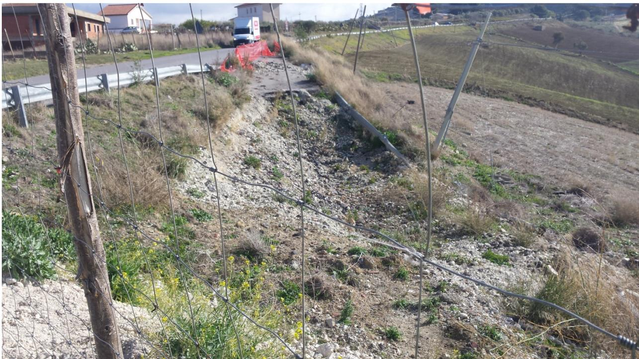
*Figura 4 - Dissesto gravitativo in corrispondenza dell'innesto con la Via Mangialasagne*
