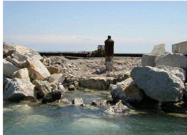
**Figura 17** Uno dei cannoni-prese di ormeggio inseriti nel corpo del molo sud alla bocca di Malamocco, durante lo smontaggio del tratto di molo interessato (maggio 2005). La parte bianca corrisponde al tratto di cannone inserito nella malta cementizia (il circolo di colore rosso evidenzia la posizione dello stemma con la corona reale inglese); la parte ossidata corrisponde alla porzione emergente dal piano di calpestio del molo.
