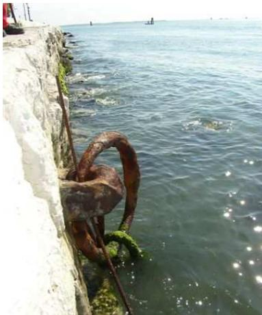
**Figura 20** Anello di ormeggio costituito dalla cicala di un’ancora “immurata” nella riva degli Alberoni, tuttora in opera. Si tratta della medesima posizione in cui si trovava l’ancora M5. A quest’ancora tuttora “immurata” e ad M5 si riferisce probabilmente il documento del 1830 riportato sopra.
