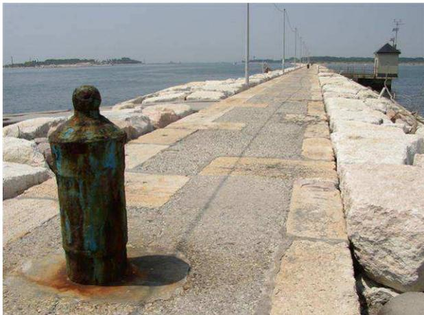
**Figura 15 Bocca di Malamocco, molo nord: cannone inserito nel corpo del molo, come bitta – resa di ormeggio. Precisamente a questi cannoni fanno riferimento i documenti riportati di seguito.**
