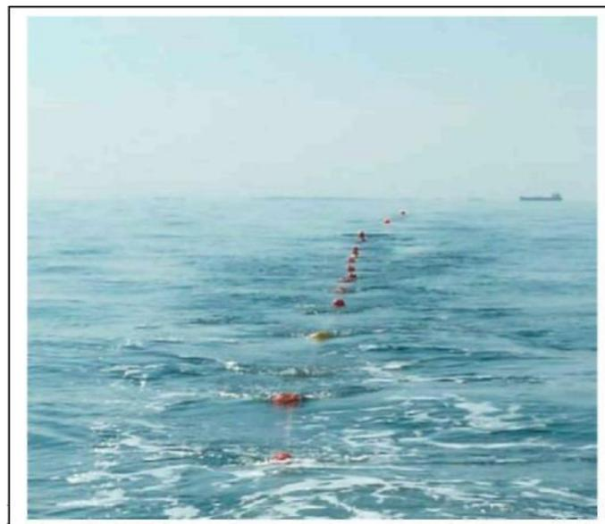
**Figura 9 - particolare che documenta l'impiego di boette e gavitelli per mantenere in galleggiamento il cavo**
