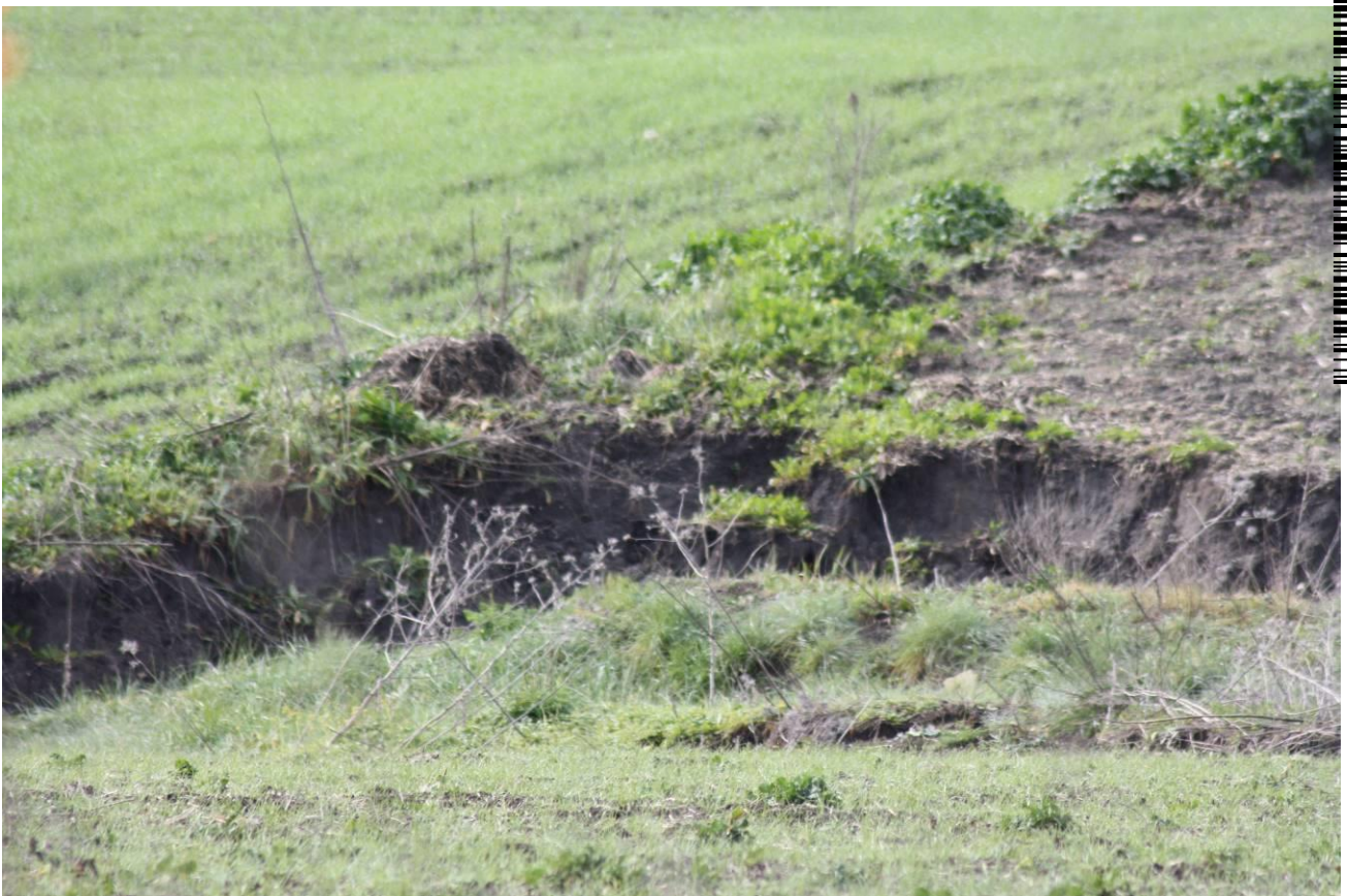
Foto 2c/2d – Particolare dei danni causati dalle acque di scarico
