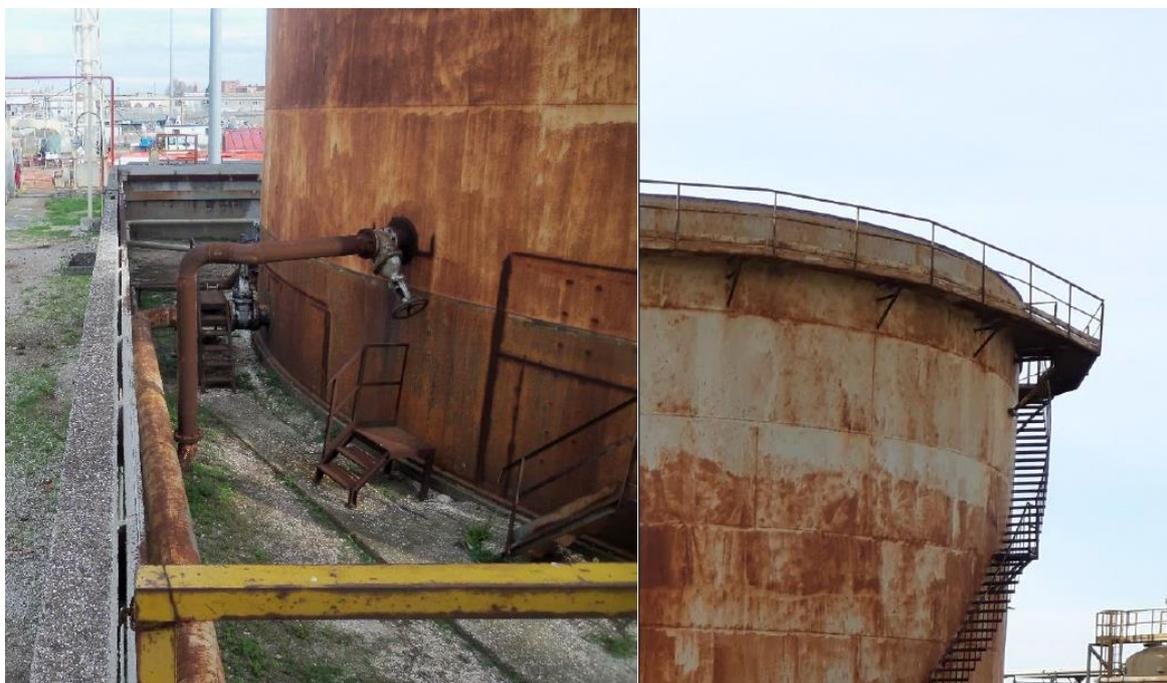
Figura 2-10: Serbatoio per trattamento acque di zavorra (No.606) - Dettagli Esterni (Tubazioni, Cordolo di Fondazione e Scala)
