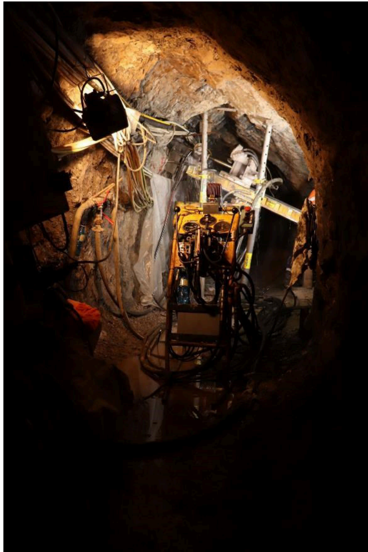
Foto 2: Sonda posizionata e centralina idraulica.
