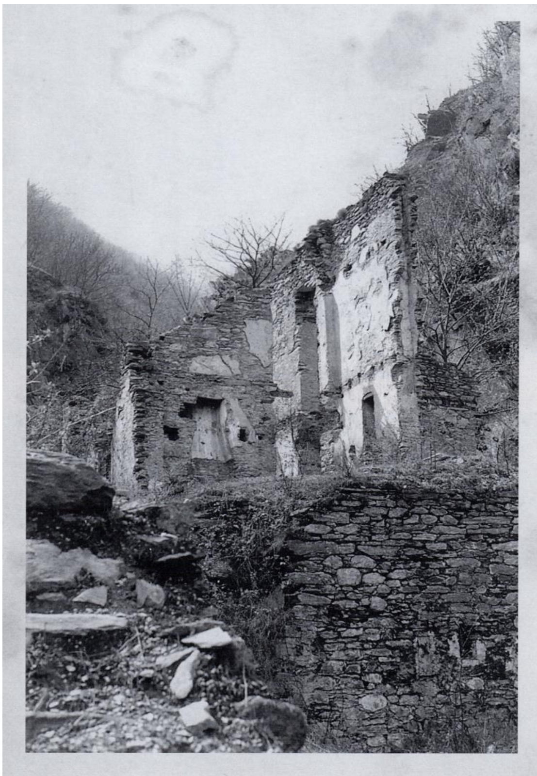
Resti dello stabilimento detto 'dei francesi' sul torrente Marmazza
