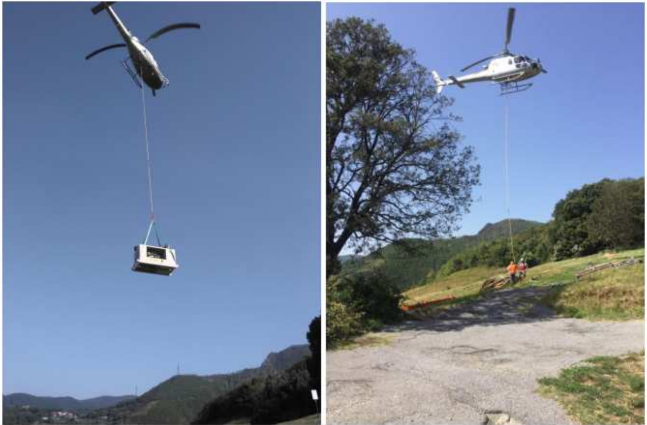
Foto 18 - 19: esempio di elitransporto del materiale.
