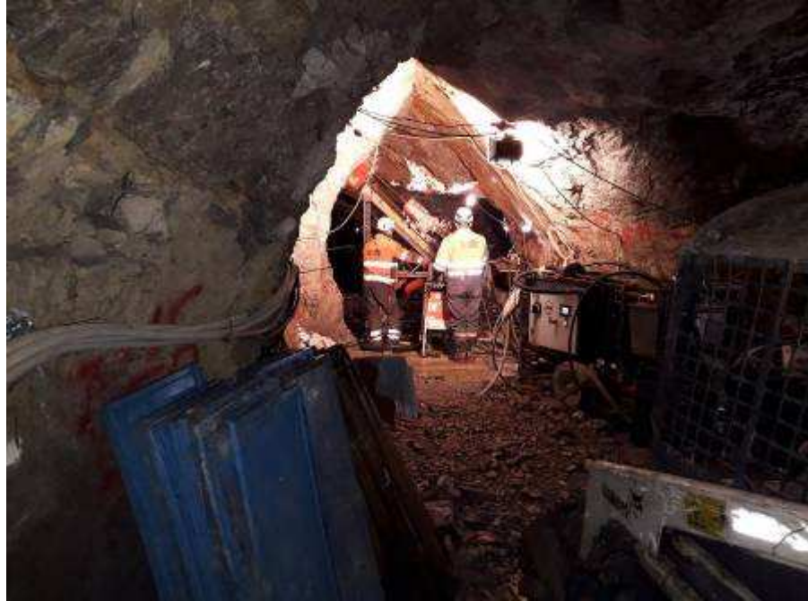
Foto 14: Sondaggio in galleria a piccola sezione e attrezzature di cantiere
