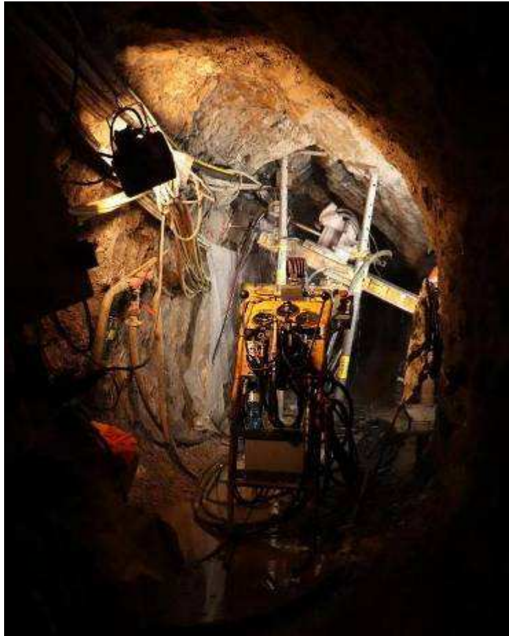
Foto 16: Sonda posizionata e centralina idraulica
