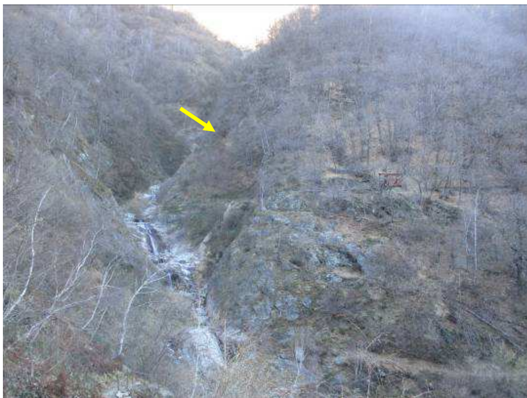
Foto 21: Torrente Marmazza visto dal sentiero che porta alla galleria Livello -2 Val Toppa; ubicazione imbocco galleria Cropino – Viezza (livello Nobili) →
