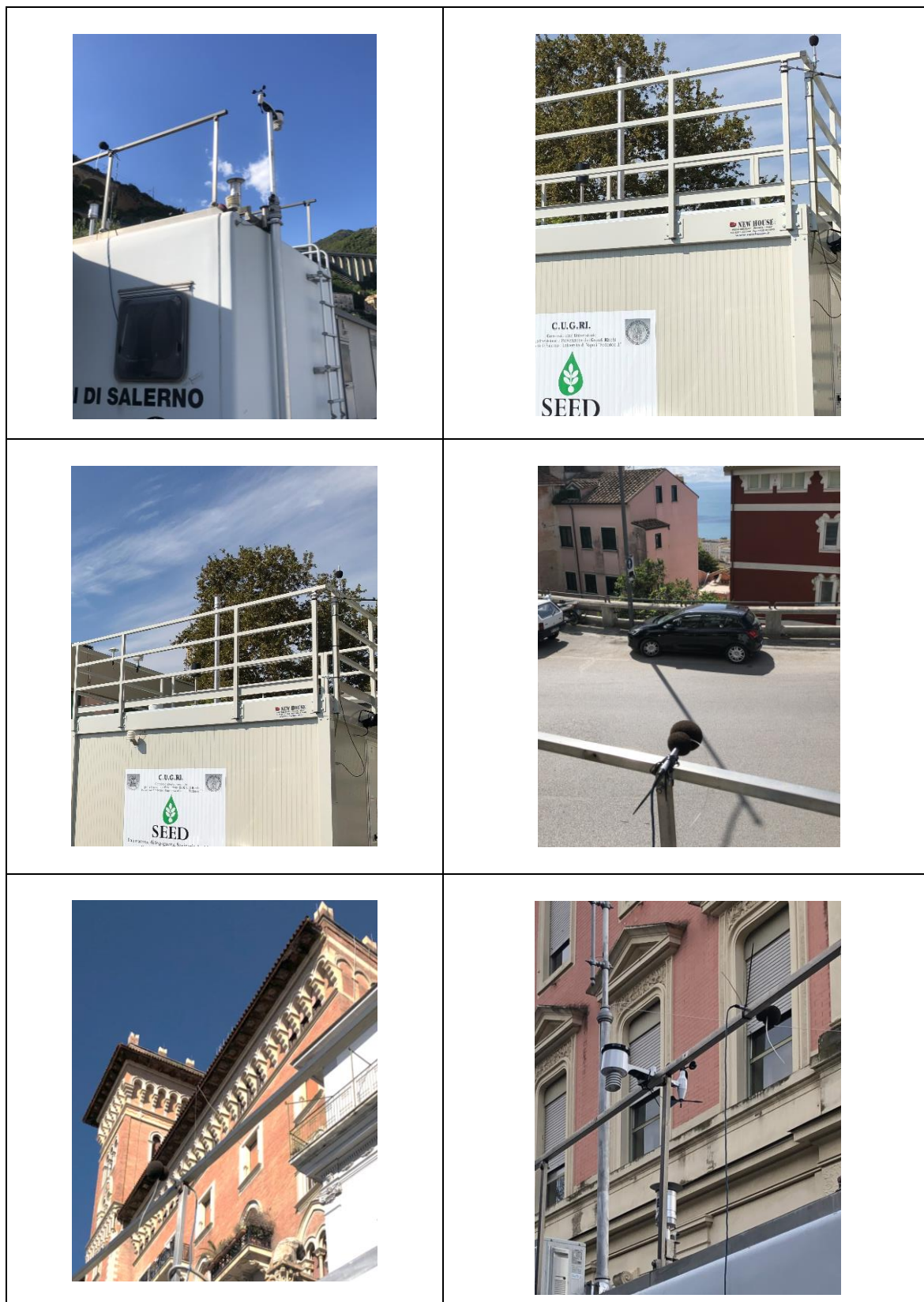
Figura 5.1 - Posizionamento della strumentazione fonometrica nell'ambito della IV campagna corso d'opera e I campagna post-operam: RUM01 (alto sx), RUM02 (alto dx), RUM03 (centro sx), RUM04 (centro dx), RUM05 (basso sx) e RUM06 (basso dx)
