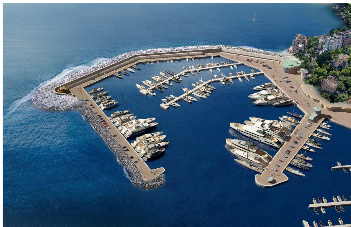
Fig. 5.42 – Post operam - Vista a volo d'uccello nord-est dell'area di intervento
