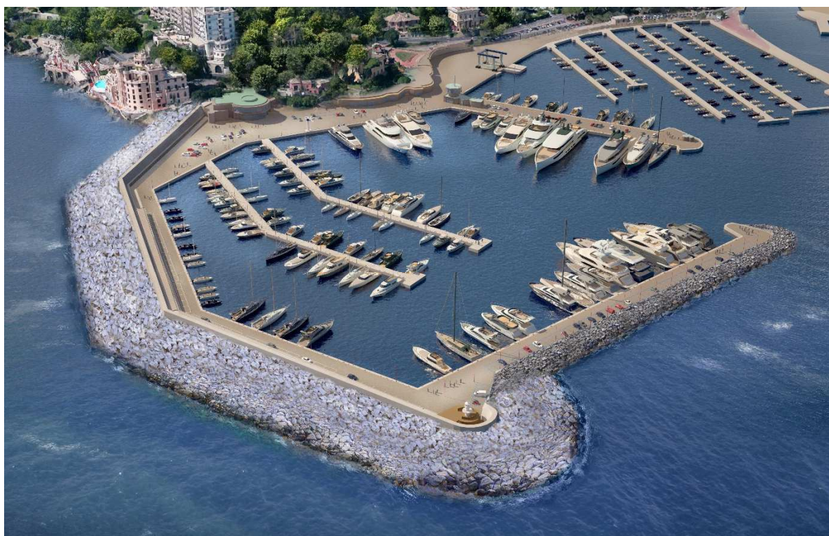
Fig. 5.44 – Post operam - Vista a volo d'uccello sud-est dell'area di intervento
