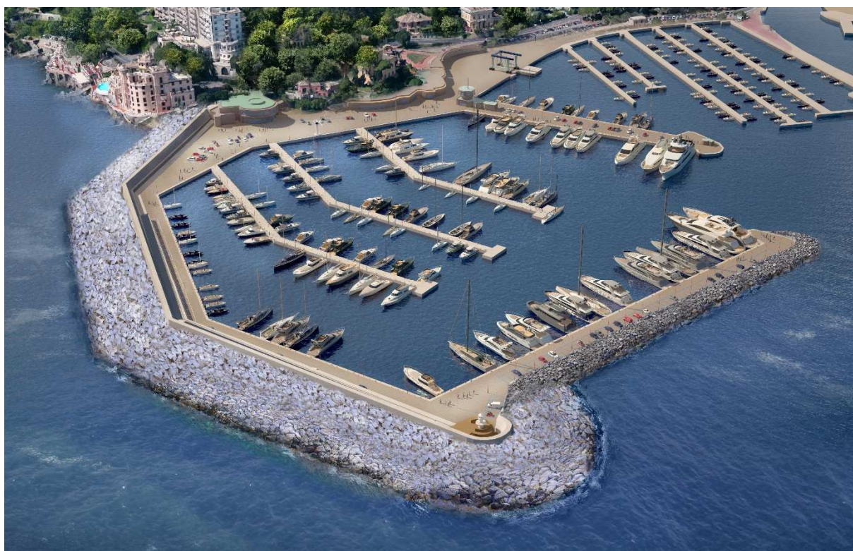
Fig. 5.43 – Ante operam - Vista a volo d'uccello sud-est dell'area di intervento
