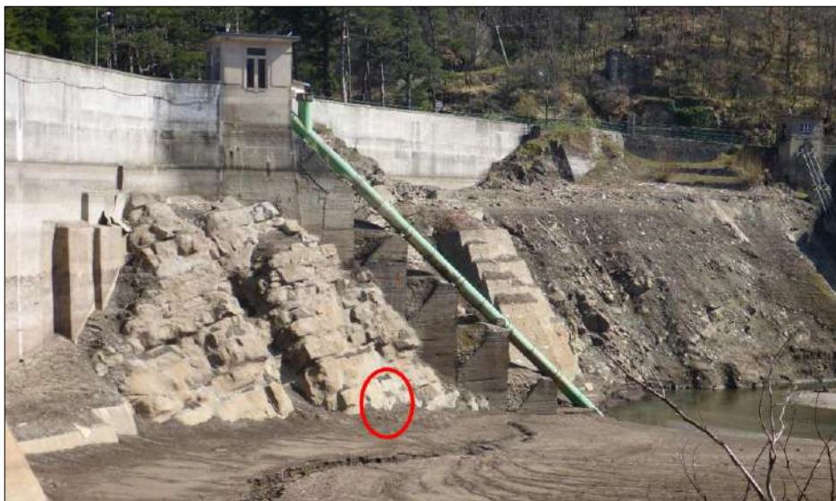
Figura 3-11: Panoramica della zona di realizzazione della nuova bocca di presa dello scarico di fondo. In cerchio rosso la posizione della bocca di presa sul versante in roccia, al limite della quota di sedimentazione dei limi lacustri.
