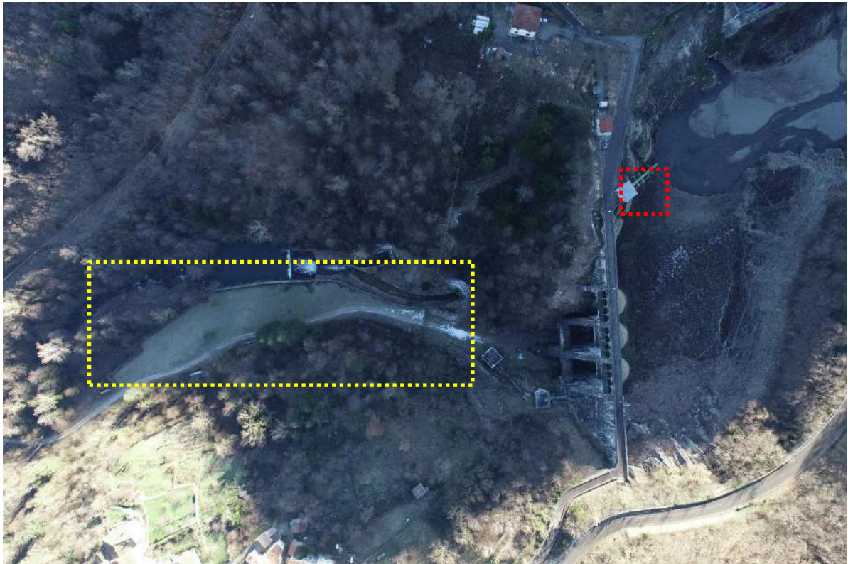
Figura 3-25: Foto con drone dell'area di intervento (14.01.2022). In giallo è evidenziata l'area in cui sorgerà l'area di cantiere a valle della diga mentre in rosso quella a monte
