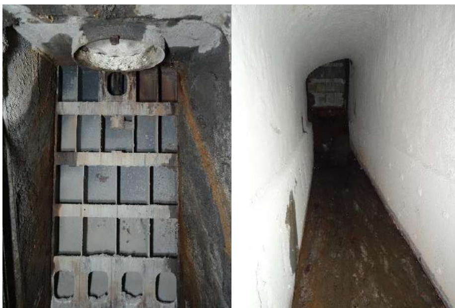
Figura 3-5: Condotto aeroforo a valle delle paratoie (sinistra) e sezione della galleria a valle della paratoia destra. Ispezione del 09.03.2021.
