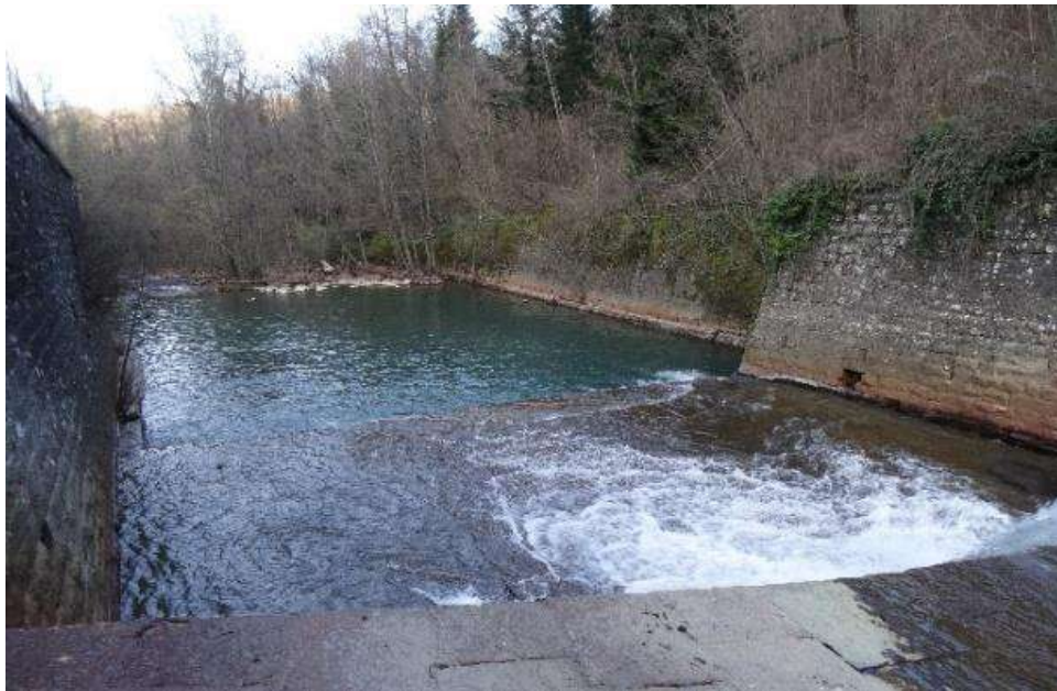
Figura 3-10: Vasca di dissipazione. Ispezione del 09.03.2021.
