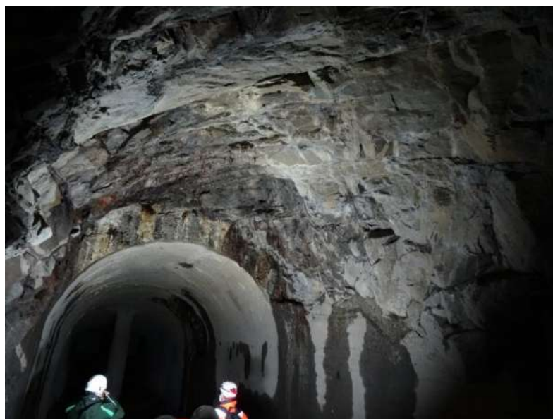
Figura 3-6: Diaframma di congiunzione delle due semi-gallerie a valle delle paratoie e inizio del tratto in roccia della galleria dello scarico di fondo. Ispezione del 09.03.2021.
