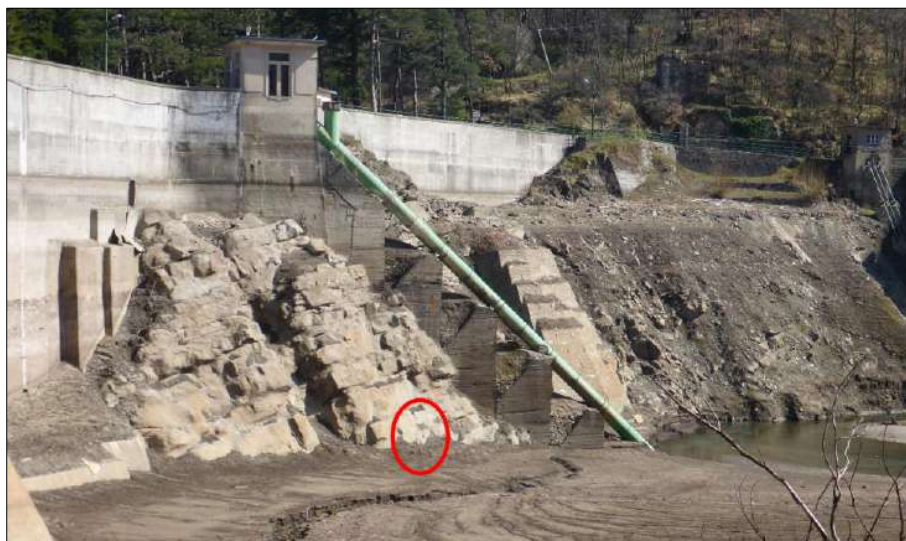
Figura 4-38: Panoramica della zona di realizzazione del nuovo scarico di fondo. In cerchio rosso la posizione del portale lungo il versante in roccia su cui si sono sedimentati i limi lacustri
