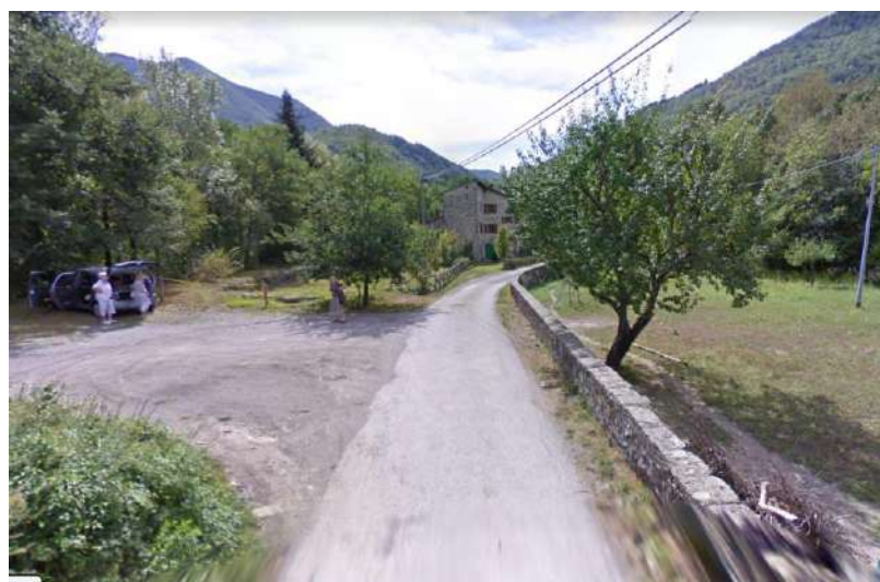
Figura 3-33: Strada di accesso al piede diga, nei pressi del "Mulino di Chicon".
