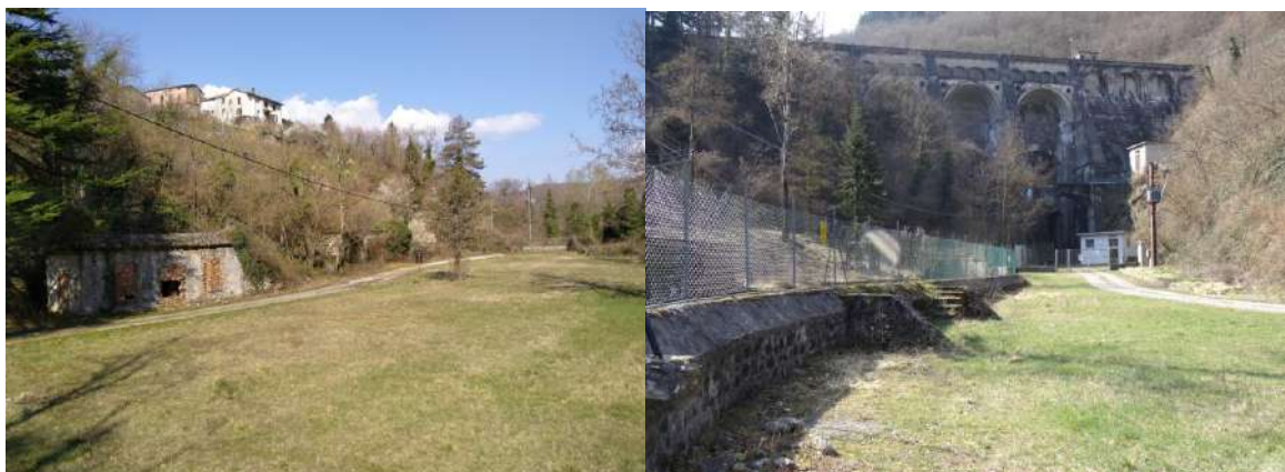
Figura 3-26: Vista delle aree di valle della diga di Pavana (10.03.2021)
