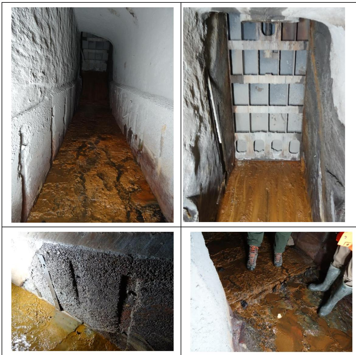
**Figura 2-5:** Cunicoli nel segmento di galleria a valle delle paratoie, con evidenza dei danni alle blindature (sopralluogo del 09.03.2021)
