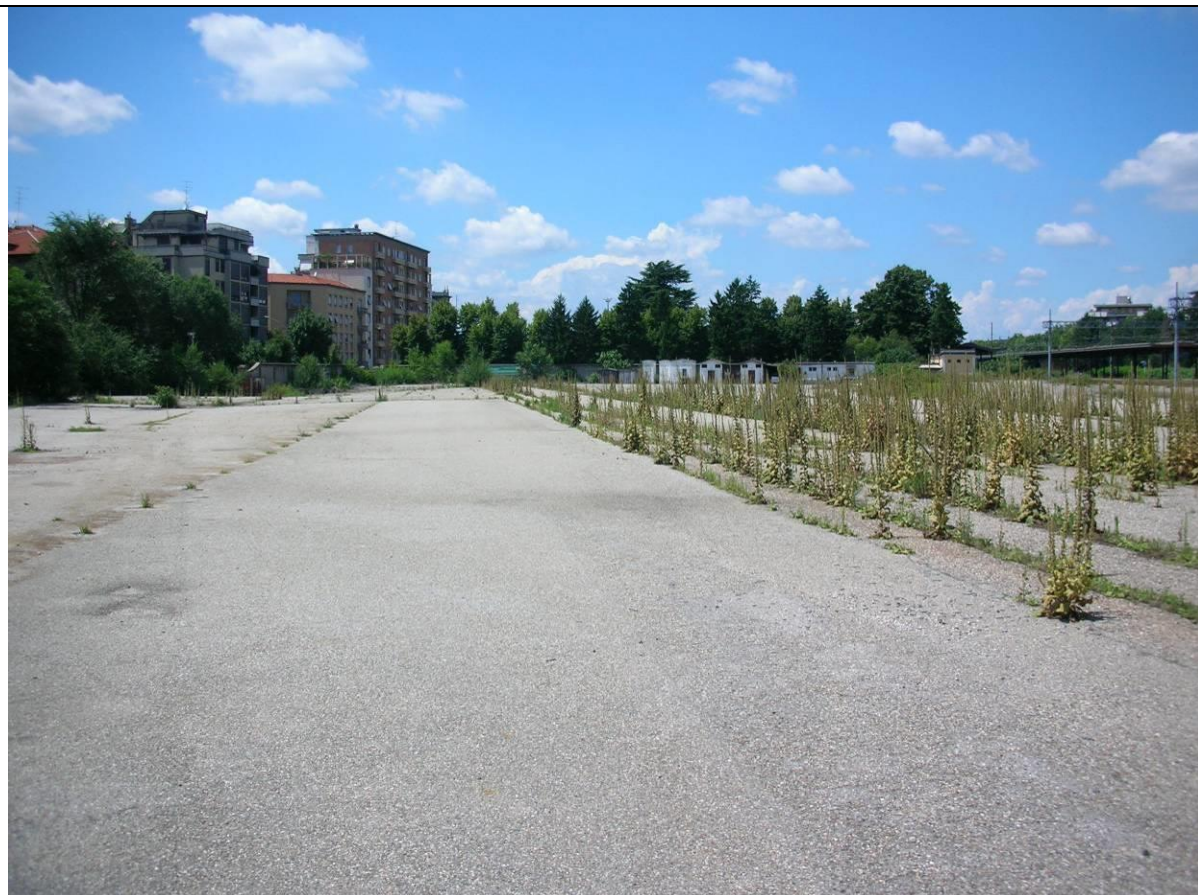
Vista dell'area destinata al cantiere.
