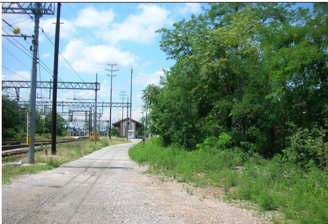
Vista dell'area di cantiere.
