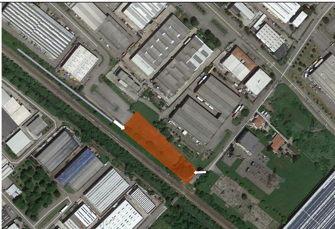
Vista aerea dell'area in cui si inserisce il cantiere, con , sulla destra, la via Olona (ortofoto da Google Earth, aggiornamento 2017).
