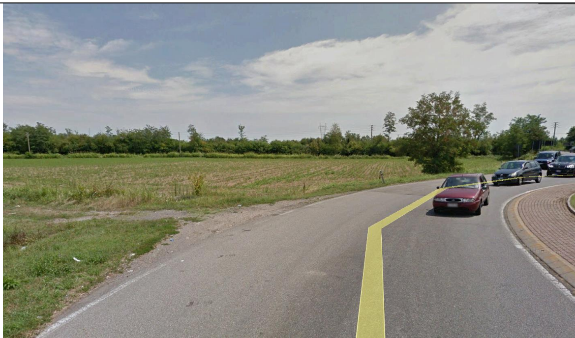
Vista della zona destinata ad area di stoccaggio e del punto di ingresso.
