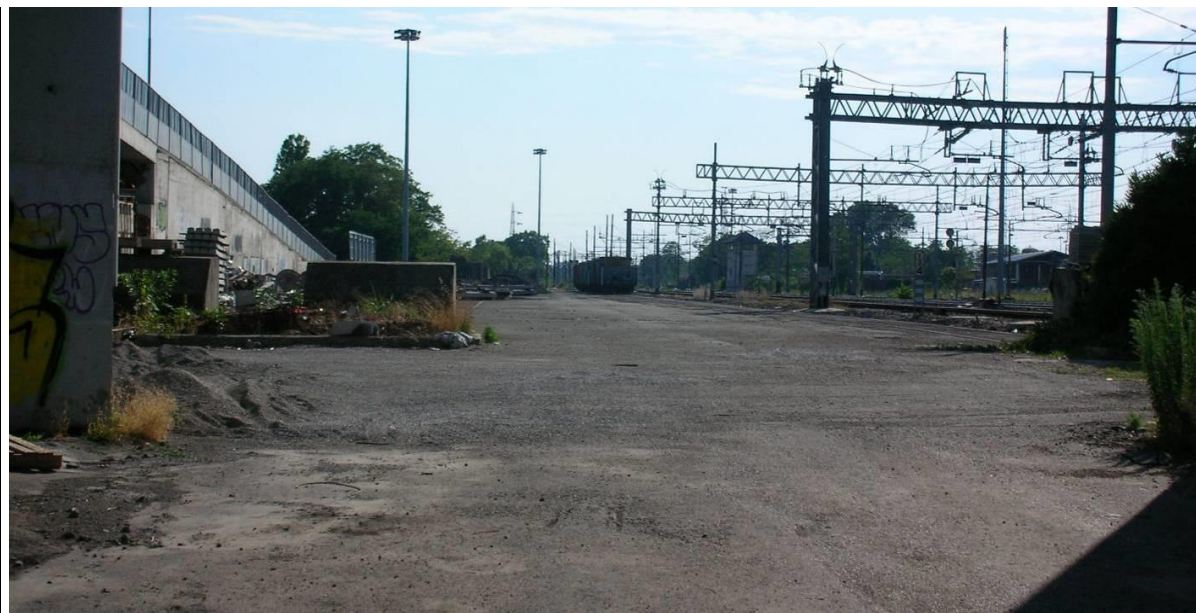
Vista dell'area destinata al cantiere dal cancello di ingresso su via Magenta.
