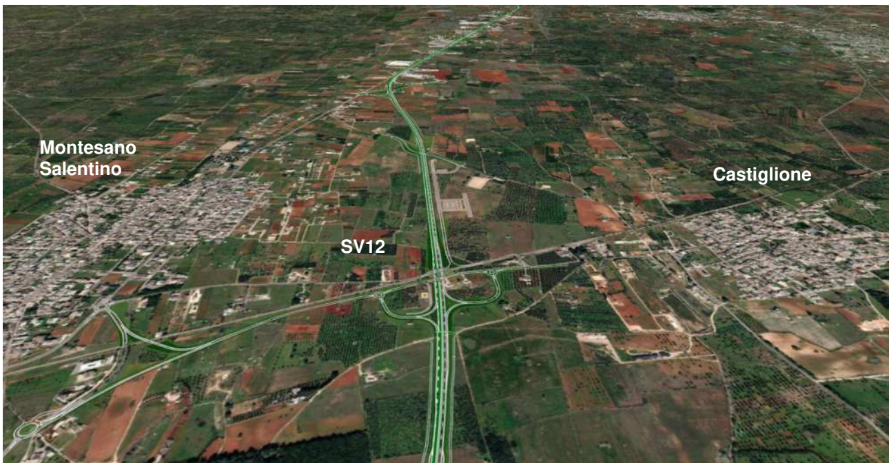
Figura 9-8. Morfologia del paesaggio e percezione visiva - Vista 8 direzione Nord
