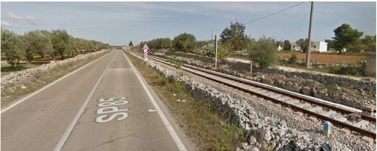
Foto 13 – Vista da SP 85 dell'area ove si prevede la realizzazione dello svincolo SV12- Montesano – Andrano.
