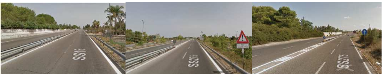
S.S. 16 km 984 – Presenza di spartitraffico
