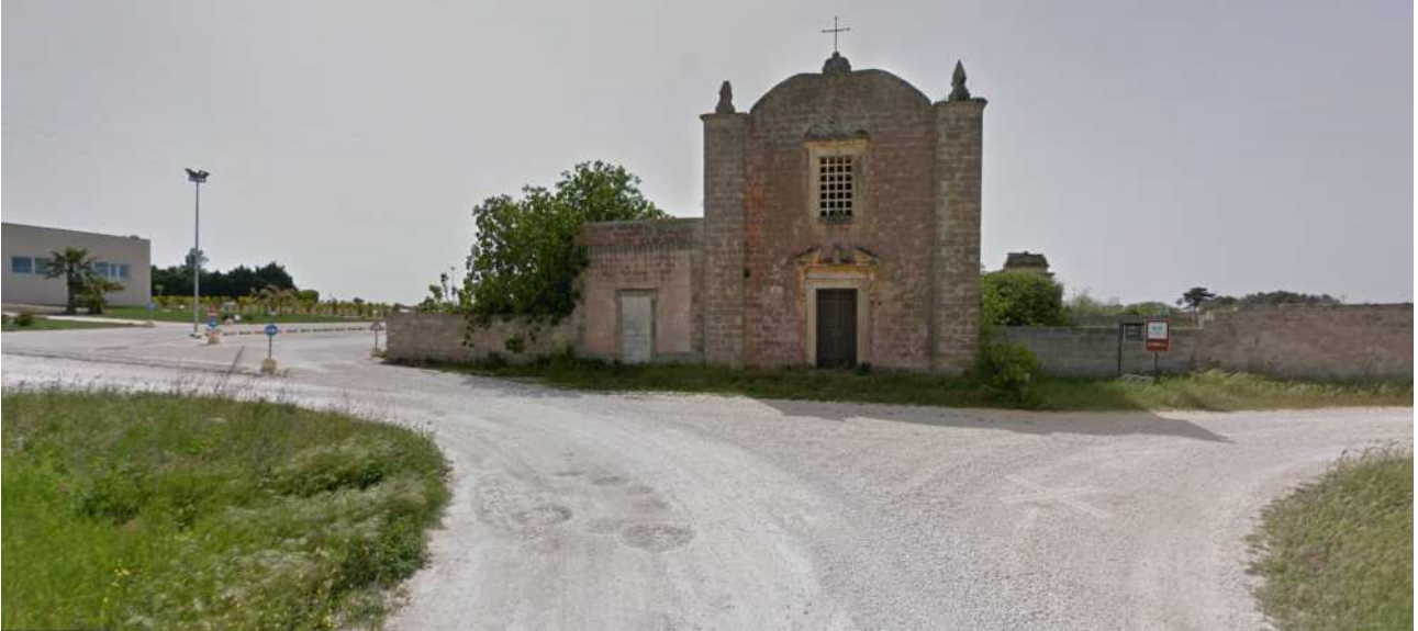
Foto 12- Facciata della Cappella della Madonna di Leuca SITA nel territorio comunale di Surano e vista in corrispondenza del tratto terminale del sovrappasso
