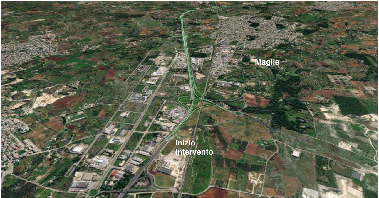
Figura 9-1. Morfologia del paesaggio e percezione visiva - Vista1 direzione sud: tratto iniziale intervento
