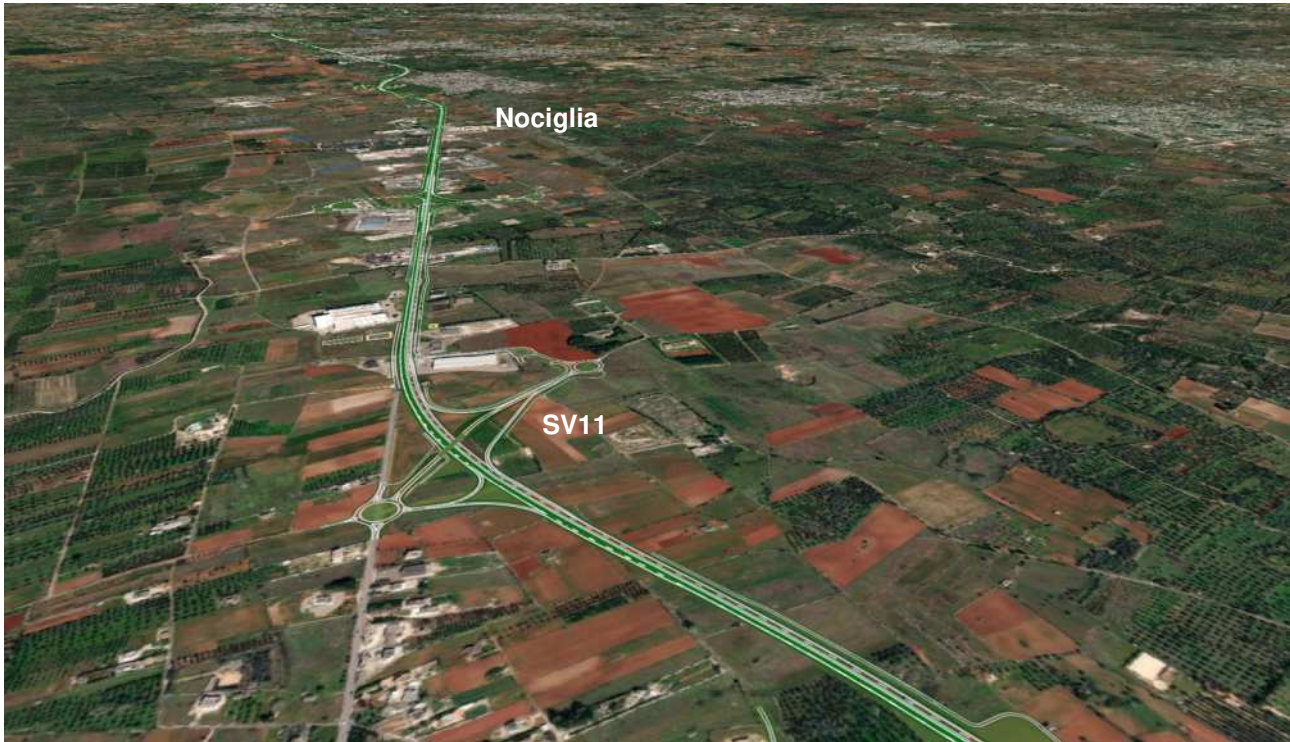
Figura 9-7. Morfologia del paesaggio e percezione visiva - Vista 7 direzione Nord
