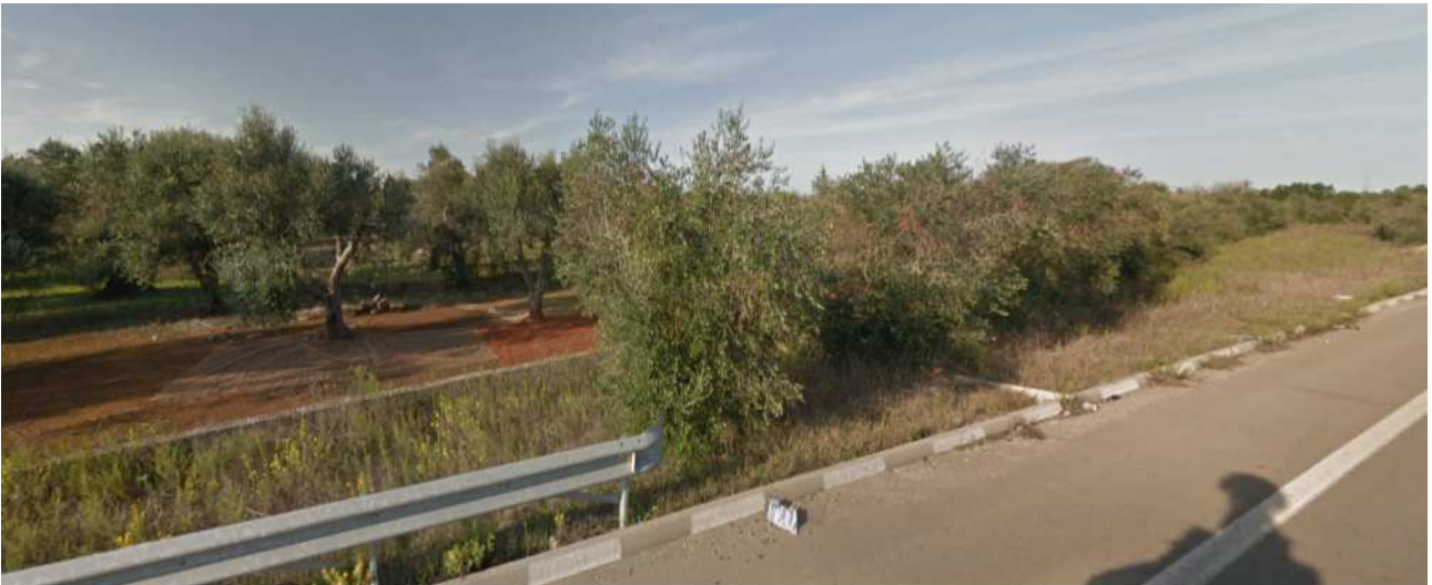
Foto 14 - Area in cui ha fine l'intervento di ammodernamento della SS275 I Lotto
