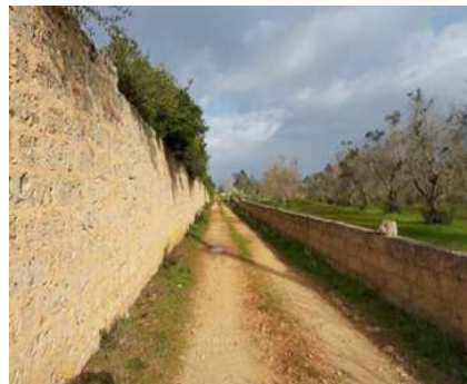
Vista del muro perimetrale Est della Macchia di Ponente
