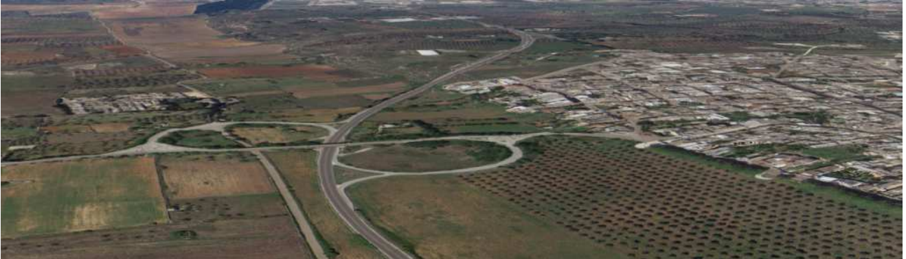
Vista in corrispondenza dell'esistente svincolo per Surano e oggetto dell'intervento di realizzazione dello Svincolo (Sv9b) Surano Nord
