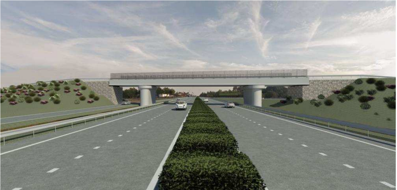
Figura 9-14. Vista post operam verso sud della SS275 in corrispondenza del Cavalcavia CV20 con evidenza del rivestimento in pietra locale dei muri andatori e delle pareti a vista e delle relative opere a verde come previste da progetto
