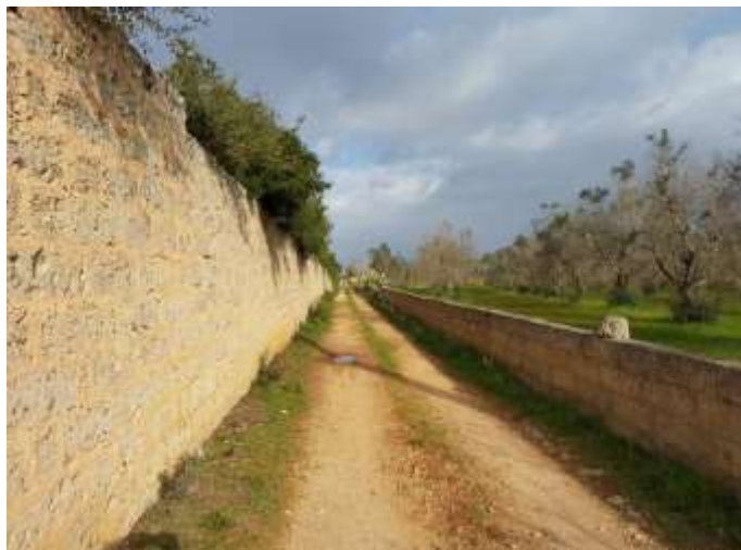
Figura 55 – Particolare del muro di recinzione della Macchia di Ponente
