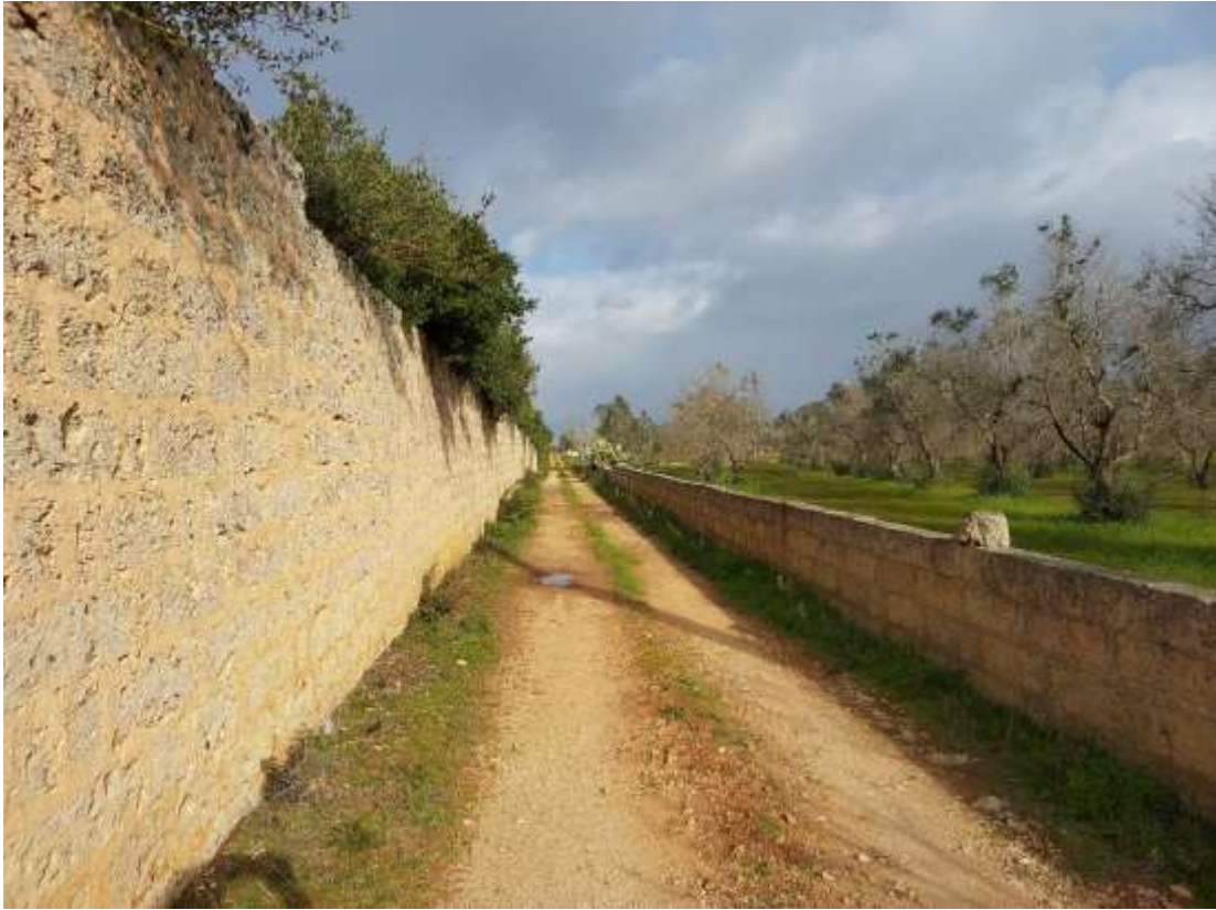
Figura 189 – Area naturale Bosco Macchia di Ponente – Ripresa da terra – A sinistra il muro perimetrale che protegge il bosco
