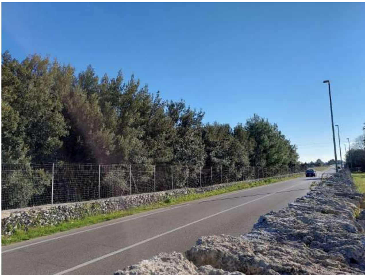
Figura 181 – Svincolo Cursi – Area boscata che sarà salvaguardata a seguito della configurazione del PD 2019
