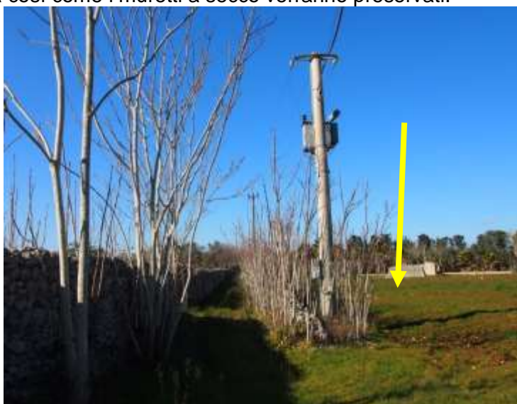
Figura 13 – Svincolo 4 Santa Cesarea Terme - Variante Localizzativa Sv4a – L'immagine mostra la stradina esistente mentre la freccia gialla indica l'area in cui verrà realizzata la strada secondaria in progetto.
